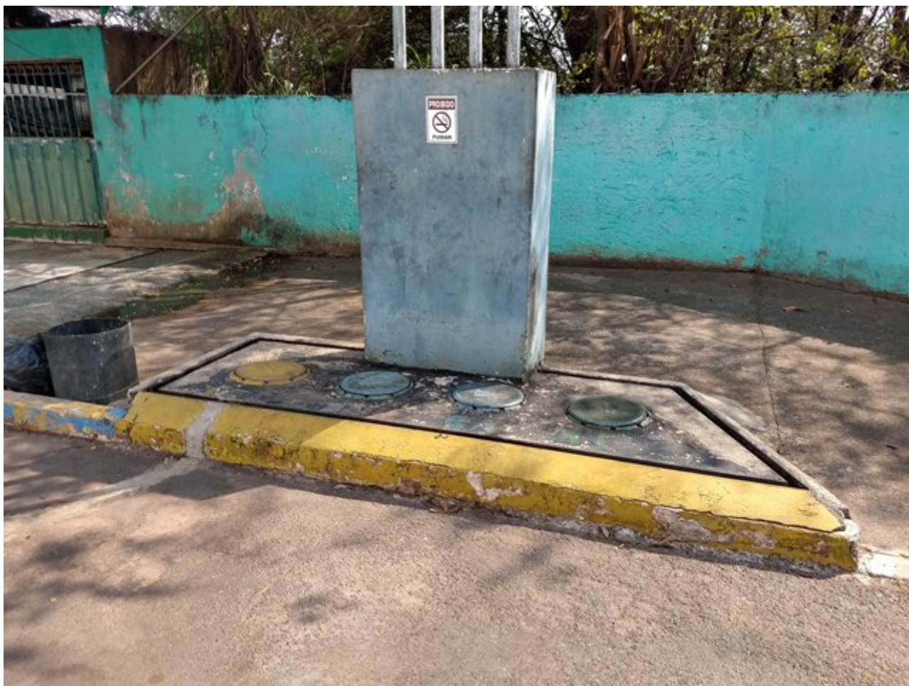
Figura 8- Descarga selada sobre o tanque.
