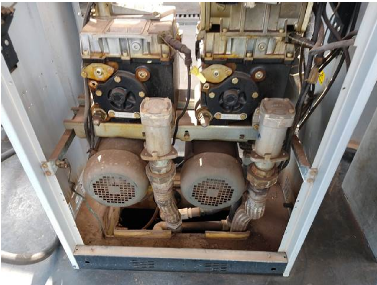
Figura 12- Unidade de abastecimento. observa-se que as tubulações não estão contidas na câmara de contenção( Sump de bomba ).
