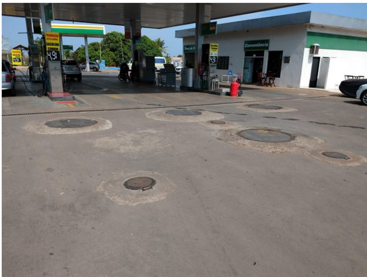
Figura 4- Área de Tancagem da pista 1 de abastecimento.
