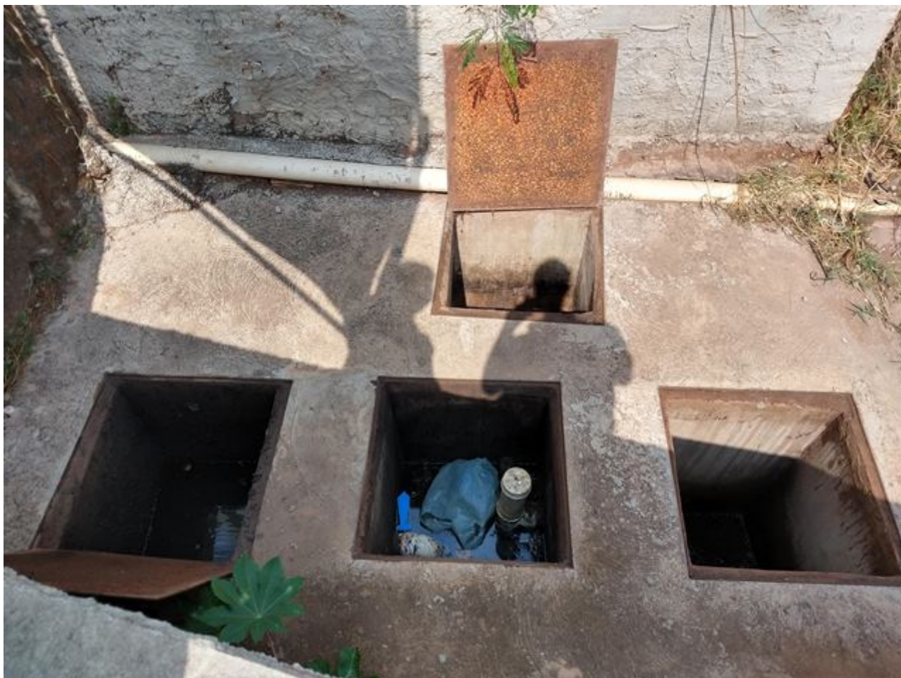
Figura 12- Unidade de abastecimento. observa-se que as tubulações não estão contidas na câmara de contenção( Sump de bomba ).
