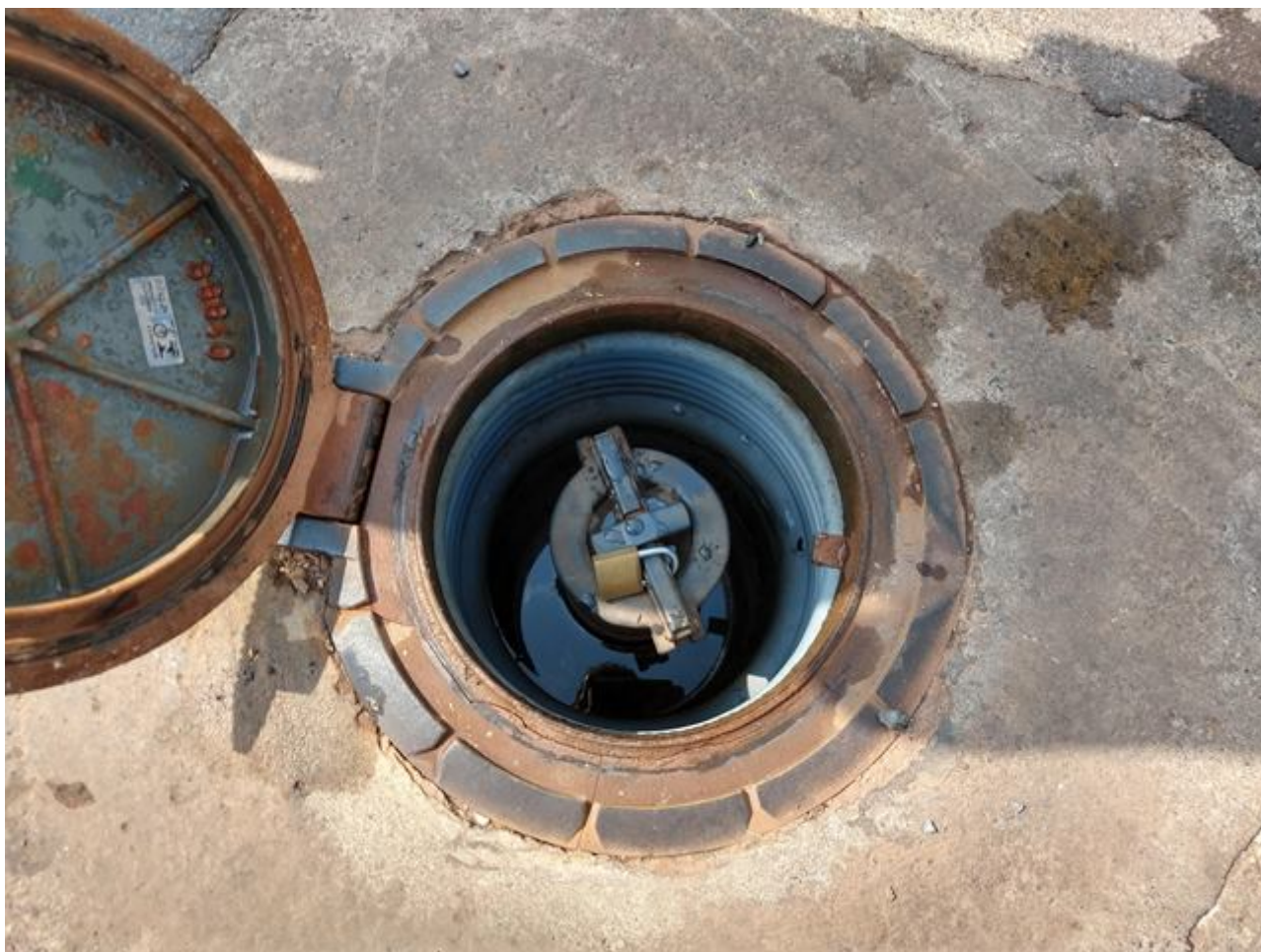
Figura 8- Descarga selada sobre o tanque.
