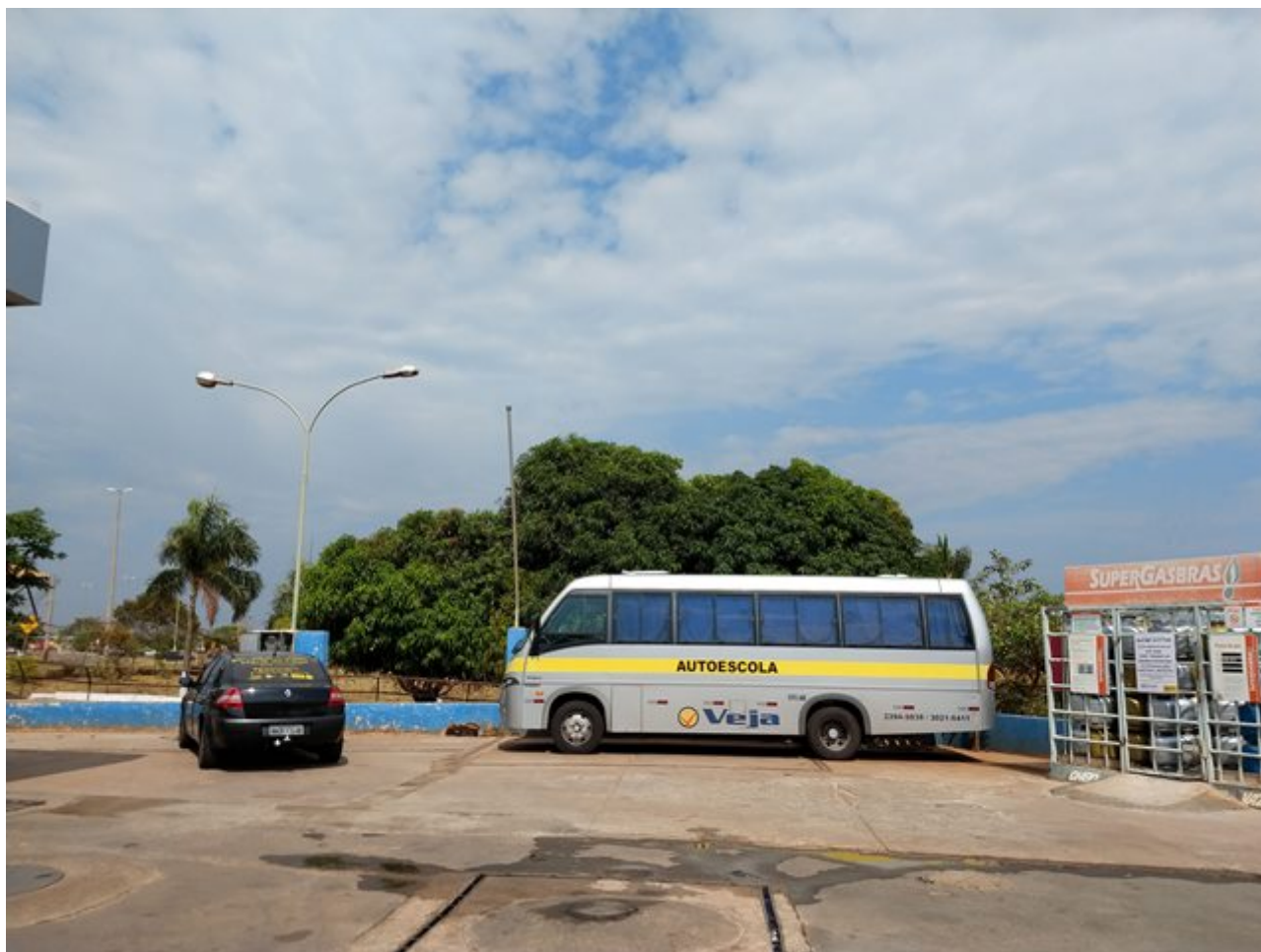
Figura 11- Respiro da pista de abastecimento 2 proveniente do tanque de diesel, com terminal corta-chamas.
