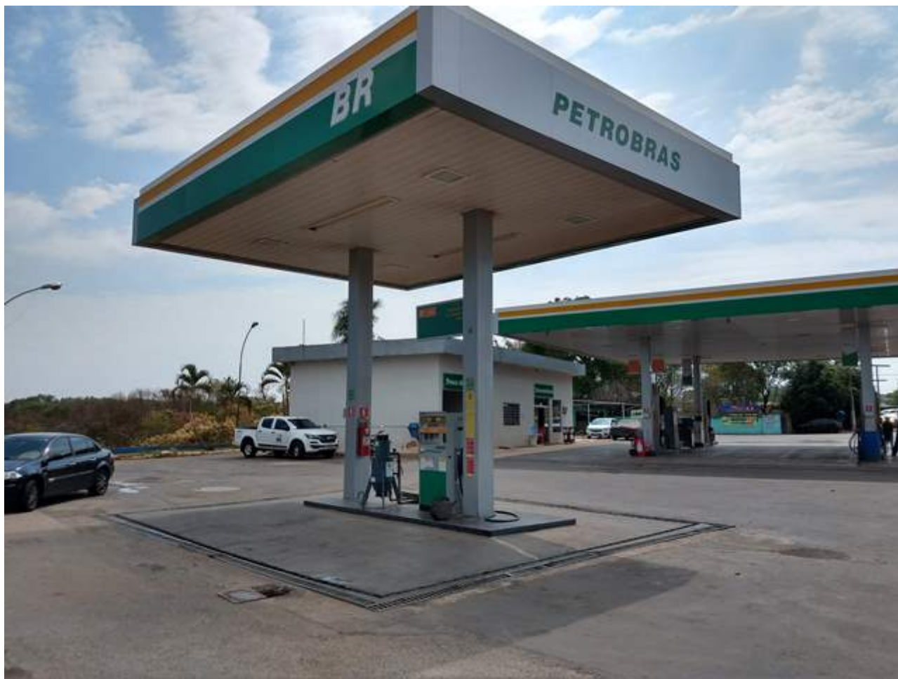
Figura 7- Pista de abastecimento 2 com presença de ilha, uma unidade abastecedora de diesel e filtro de diesel.
