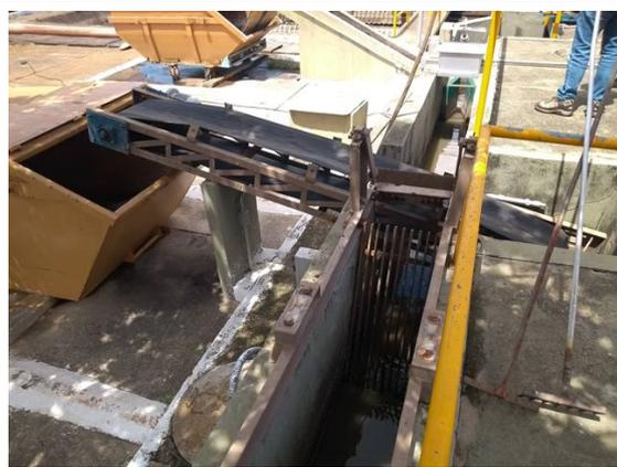
FOTO 2: Gradeamento manual e esteira para a retirada dos resíduos retidos na grade
