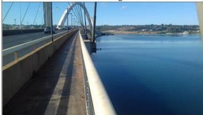
Figura 4 – Visualizam-se as estruturas de fixação dos estais
