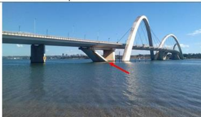
Figura 5 – Indicação do bloco de fundação que será objeto de reforço estrutural.
