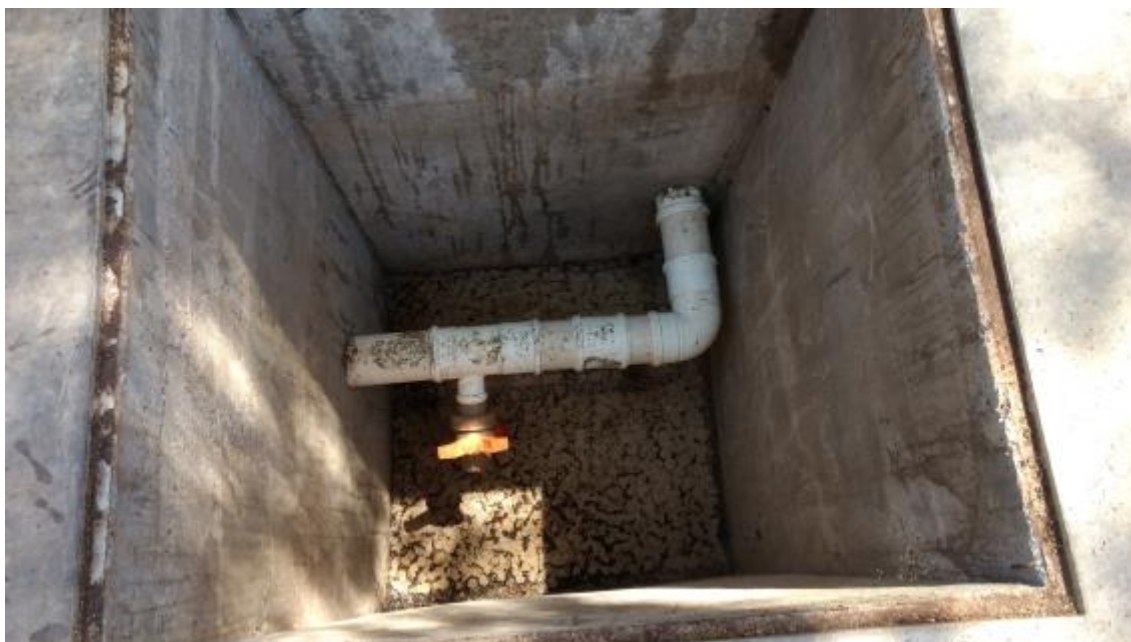
Foto 17: Ponto de amostragem do SAO em "T" da pista de abastecimento.
