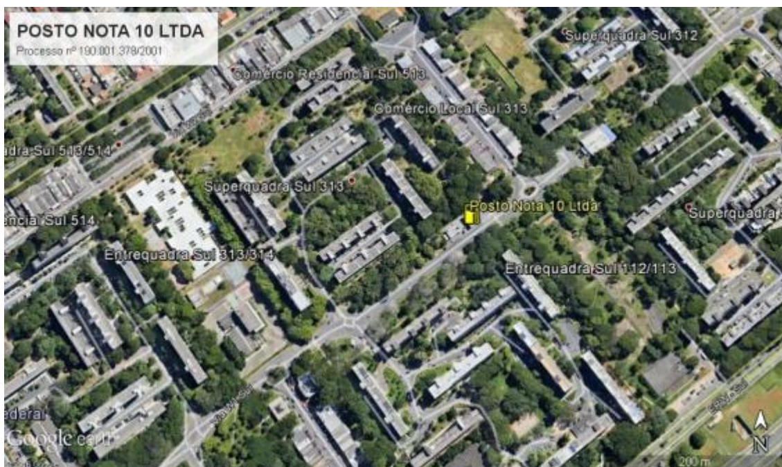
Foto 1: Localização do empreendimento. Imagem de 18/02/2014, extraída do software Google Earth Pro.
