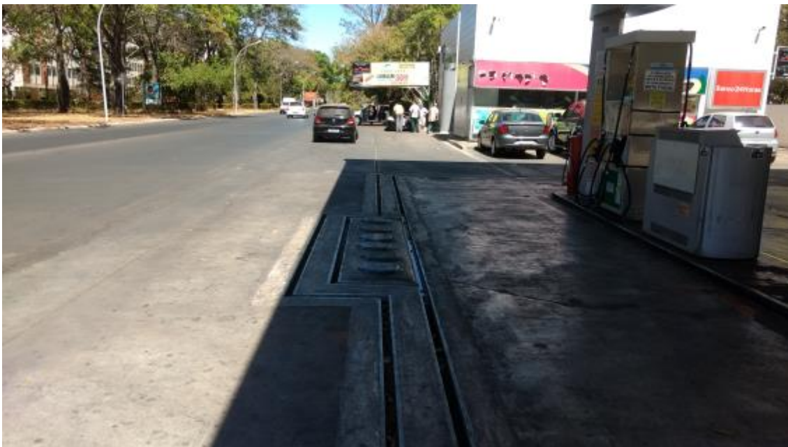
Foto 08: Pista de abastecimento com um conjunto de canaletas para captação de água pluvial e outro para os efluentes, que está ligado ao SAO.
