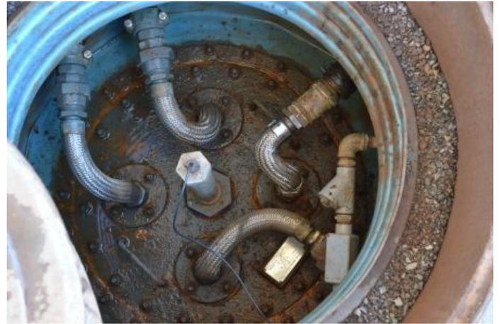
**Figura 30** – Aspecto interno da Boca de Visita do Tanque evidenciado controle eletrônico de estoque e tubulação subterrânea de metal. Observa-se a necessidade de manutenção operacional constante conforme exige a tabela 1 da ABNT NBR 15594-3:2008
