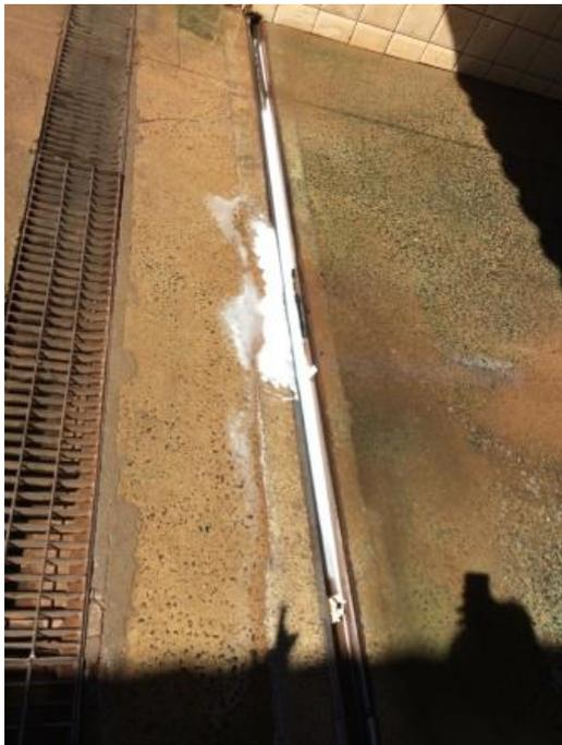
**Figura 45** – Aspecto do canaleta localizado na área do Lava Jato. Observa-se o extravasamento do efluente gerado quando da lavagem de veículos denotando não está com a inclinação para a caixa de areia central.
