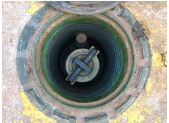
**Figura 13** – Detalhe interno das descargas Seladas à distância.
