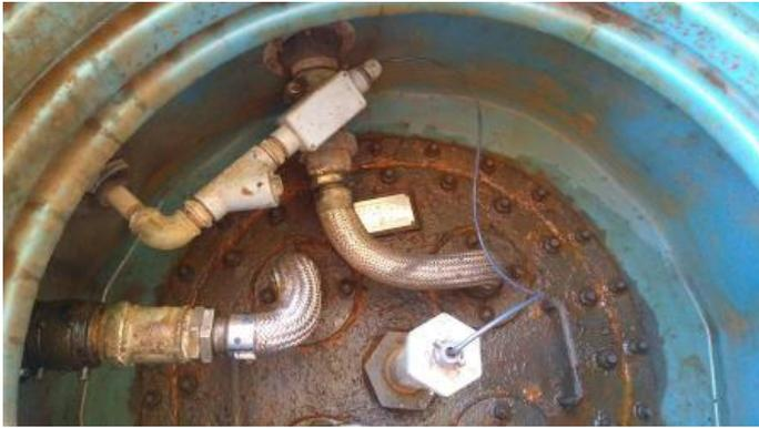
**Figura 29** – Aspecto interno da Boca de Visita de um dos 4 SASC com controle eletrônico de estoque e tubulação subterrânea de metal. Observa-se a necessidade de manutenção operacional constante conforme exige a tabela 1 da ABNT NBR 15594-3:2008
