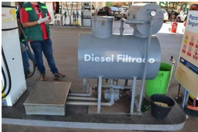
**Figura 5** – Aspecto do filtro de Diesel (S10) com a câmara de contenção da unidade filtrante.
