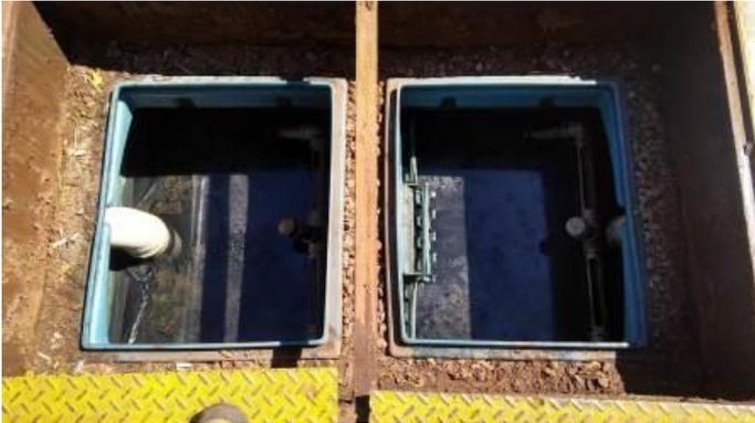
**Figura 17 –** Caixa Separadora do SAO da pista de abastecimento
