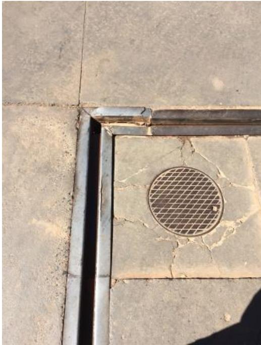
**Figura 8**- Detalhe da danificação interna de um trecho dos Canaletes.
