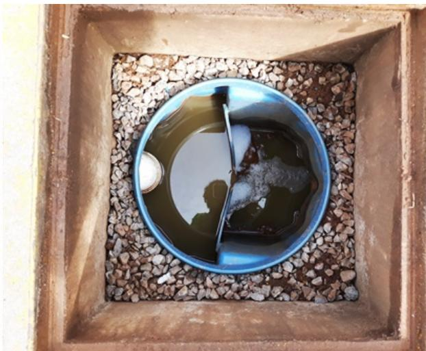
Figura 22 – Aspecto da Caixa de Amostragem de efluentes do SAO da área de lavagem.
