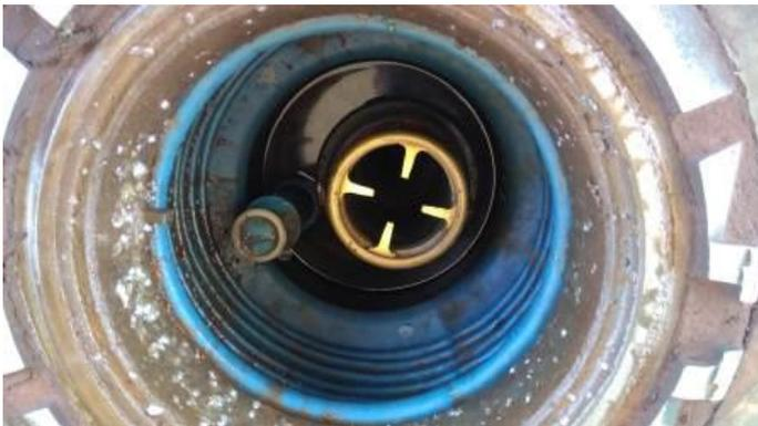
**Figura 31** – Aspecto da Descarga selada sobre o tanque, não possui *válvula anti-transbordamento*.
