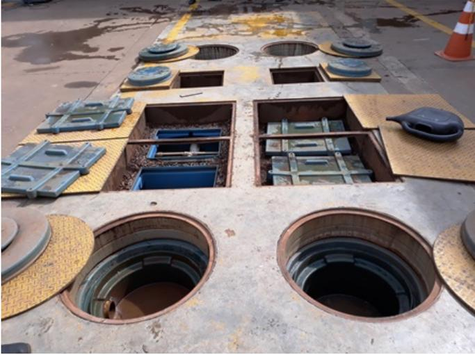
**Figura 15:** Aspecto Geral dos SAO's da área da pista de abastecimento, lubrificação e lavagem de veículos.
