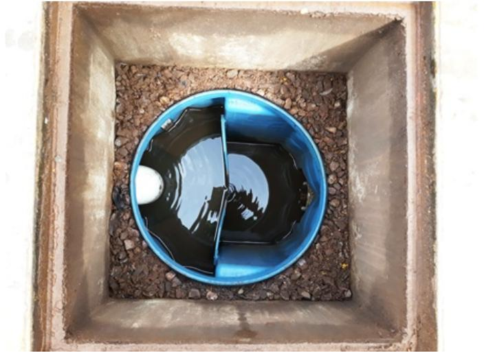
**Figura 18 –** Caixa de Amostragem de efluentes do SAO da pista de abastecimento.
