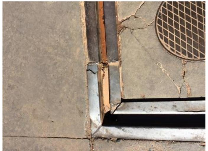
**Figura 9** – Detalhe da danificação interna de um trecho dos Canaletes.
