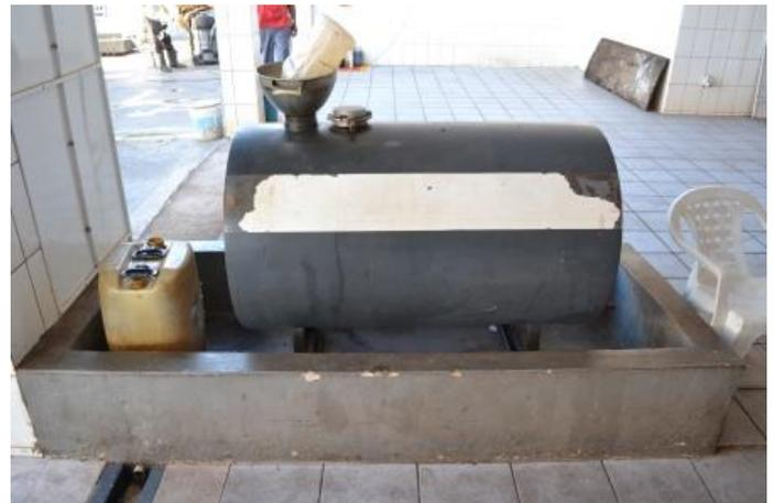
Figura 36 – Aspecto do Tanque aéreo de Óleo Usado ou Contaminado - OLUC.
