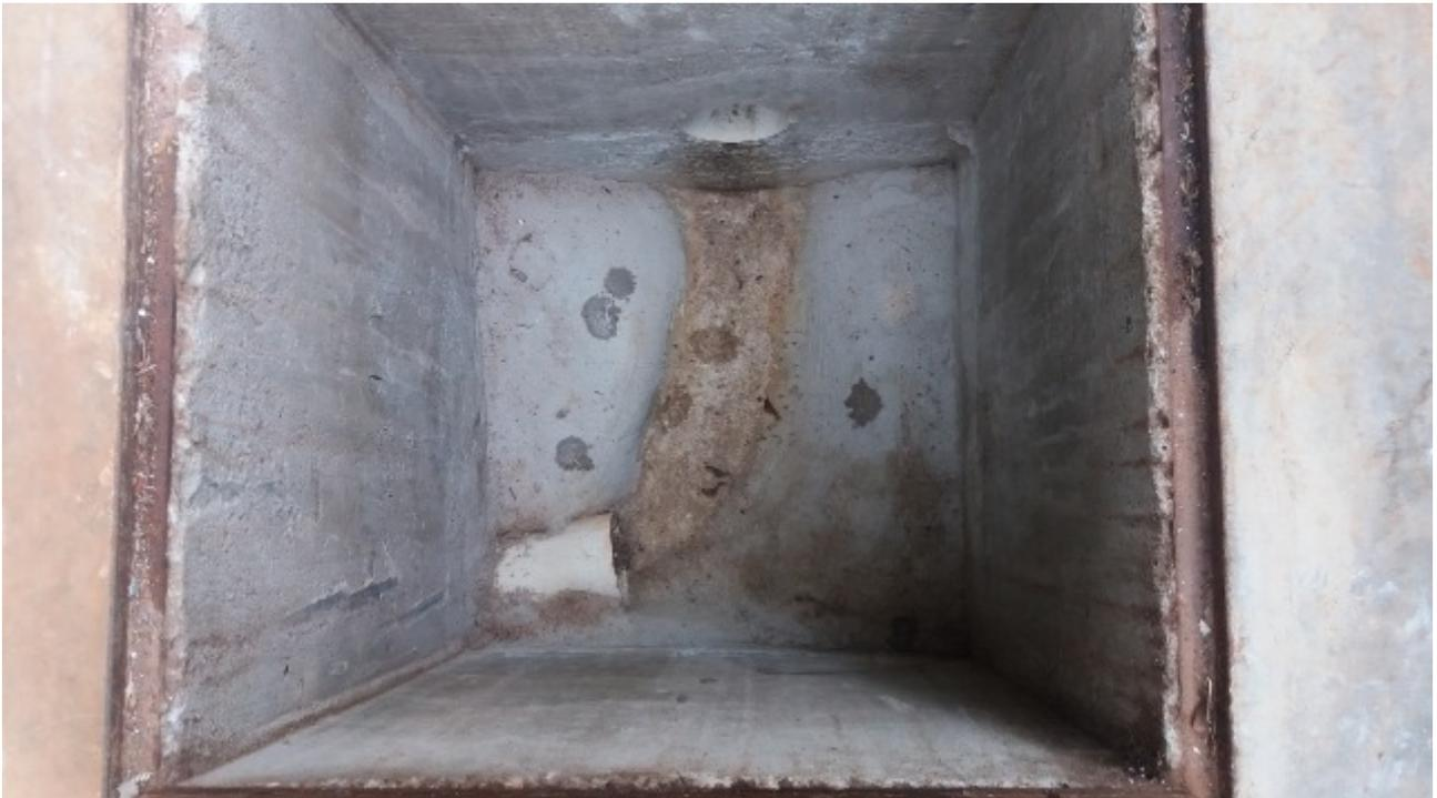
Figura 14 – Caixa de amostragem em alvenaria
