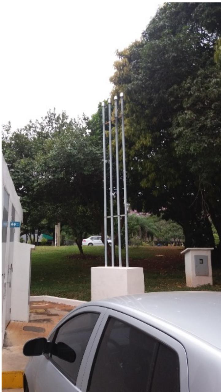
Figura 10 – Vegetação a menos de 1,5 m do terminal corta-chama dos respiros dos tanques
