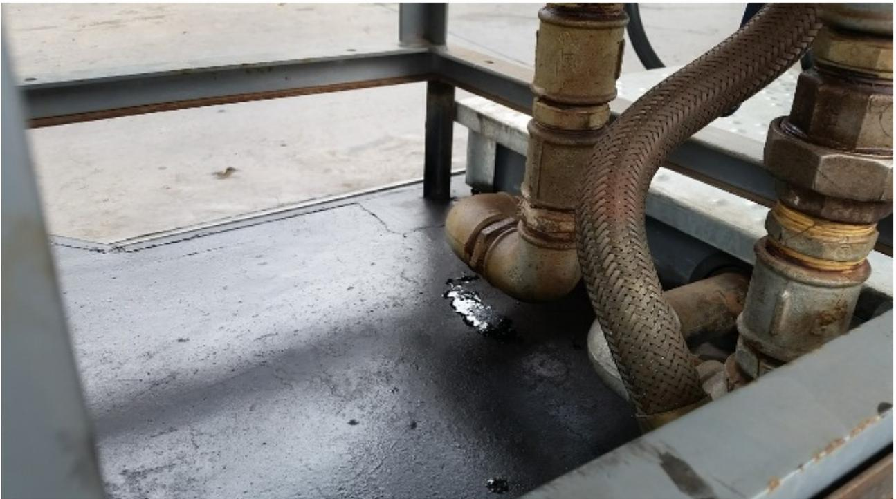
Figura 5 – Filtro de Diesel com gotejamento em área com piso impermeável e circundado por canaletes
