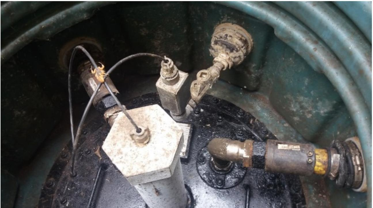
Figura 11 – Câmara de contenção na boca de visita do tanque com controle eletrônico de estoque, tubulação subterrânea em PEAD e flanges de vedação em bom estado de conservação
