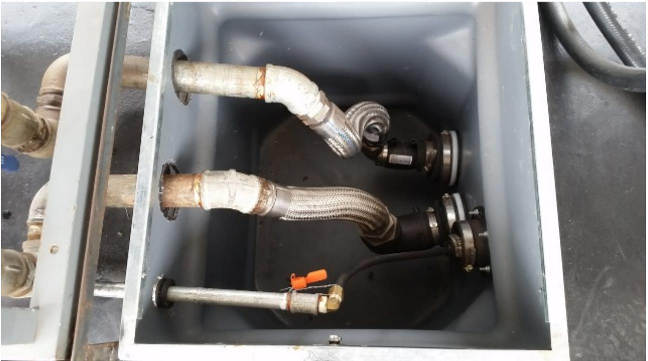
Figura 3 – Câmara de Contenção do filtro de Diesel
