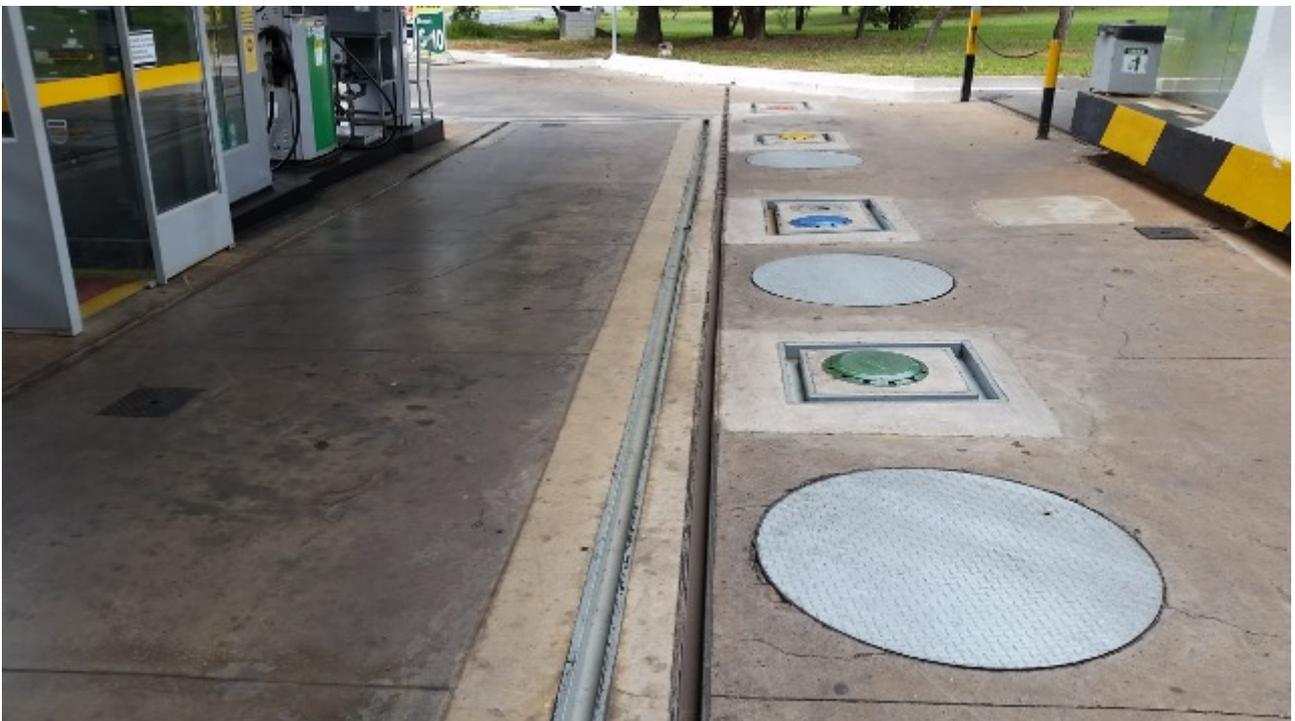
Figura 6 – Área dos tanques com Descargas seladas circundadas por canaletes
