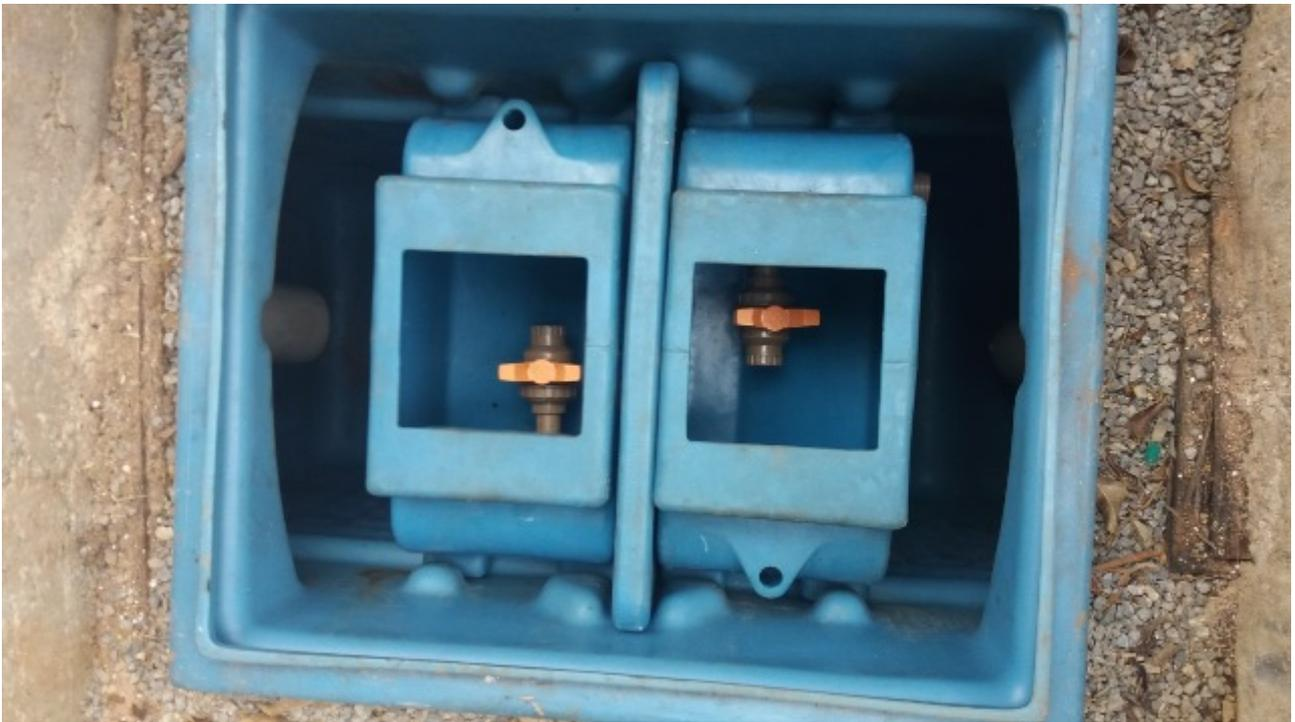
Figura 13 – Caixas separadora e de coleta de óleo do SAO
