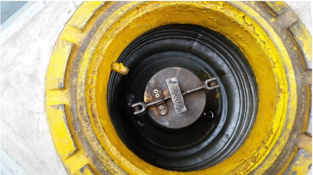
Figura 7 – Descarga Selada sobre o tanque equipada com câmara de contenção e em bom estado de conservação
