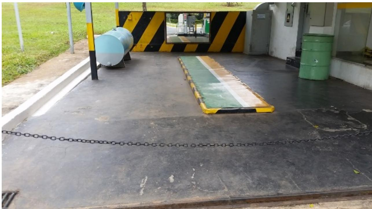
Figura 15 – Área de lubrificação isolada por corrente, com vala coberta por placa metálica, tanque de OLUC e barril de armazenamento de embalagens de óleo usadas
