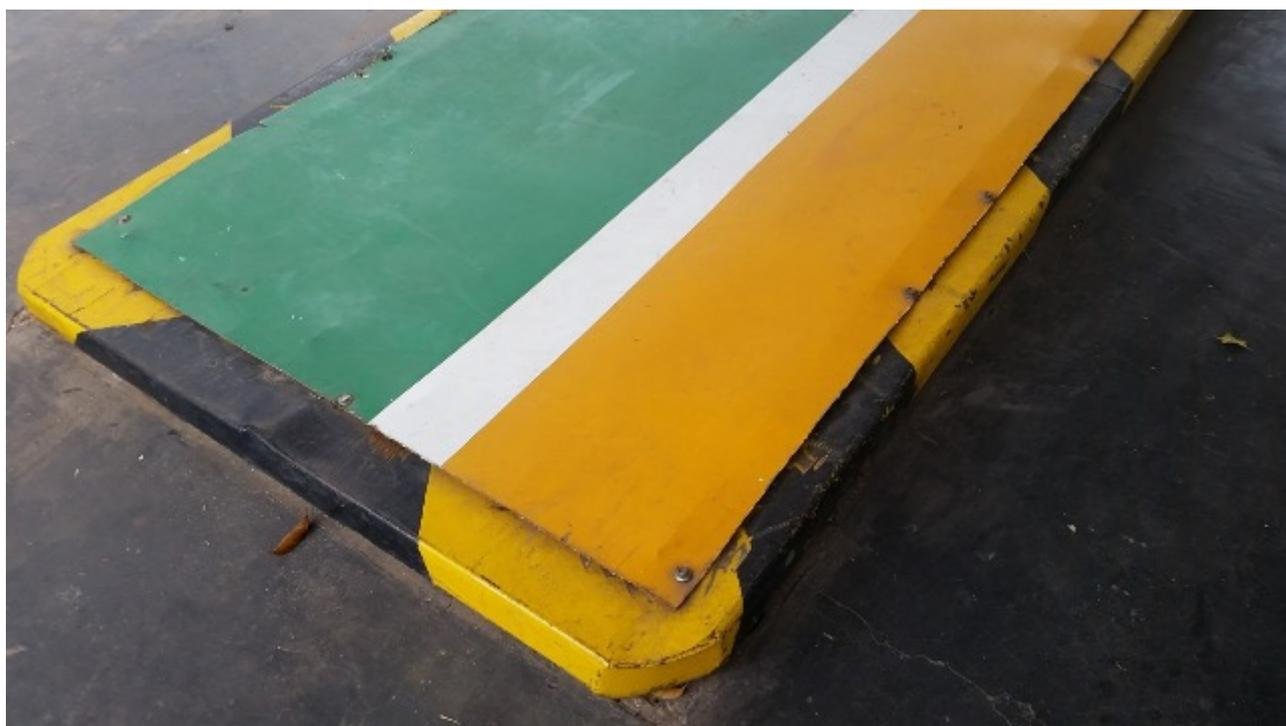
Figura 16 – Detalhe de placa metálica presa ao solo com a utilização de parafusos
