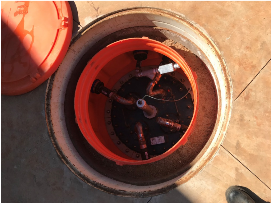
Foto 9. Visão geral da boca de visita de um dos tanques.
