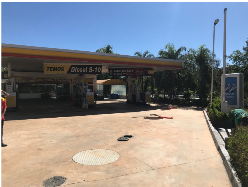
Foto 1. Visão geral do local onde os novos tanques foram instalados.
