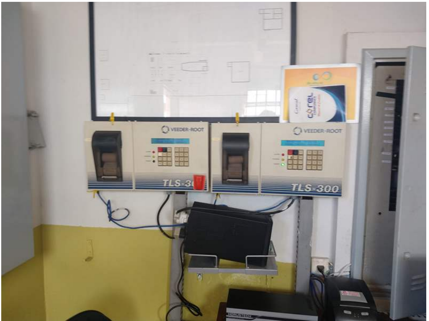
Figura 21 - Sistema de monitoramento ambiental e controle eletrônico de estoque.
