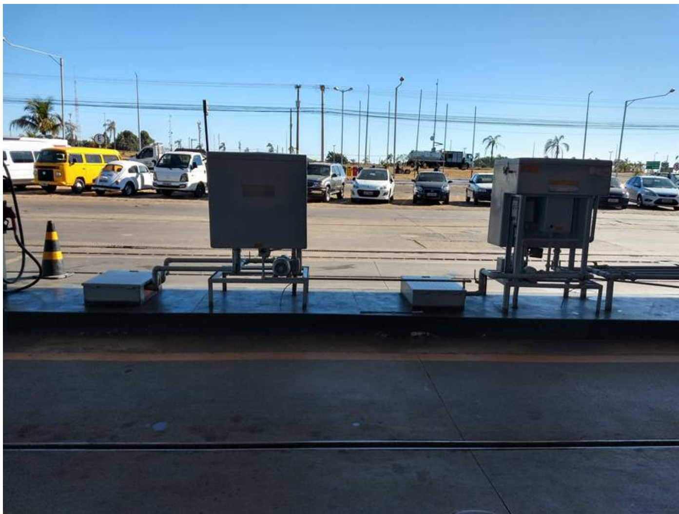
Figura 13 - Unidades filtrantes de diesel, foram efetuadas correções na tubulação para se adequar às normas técnicas.
