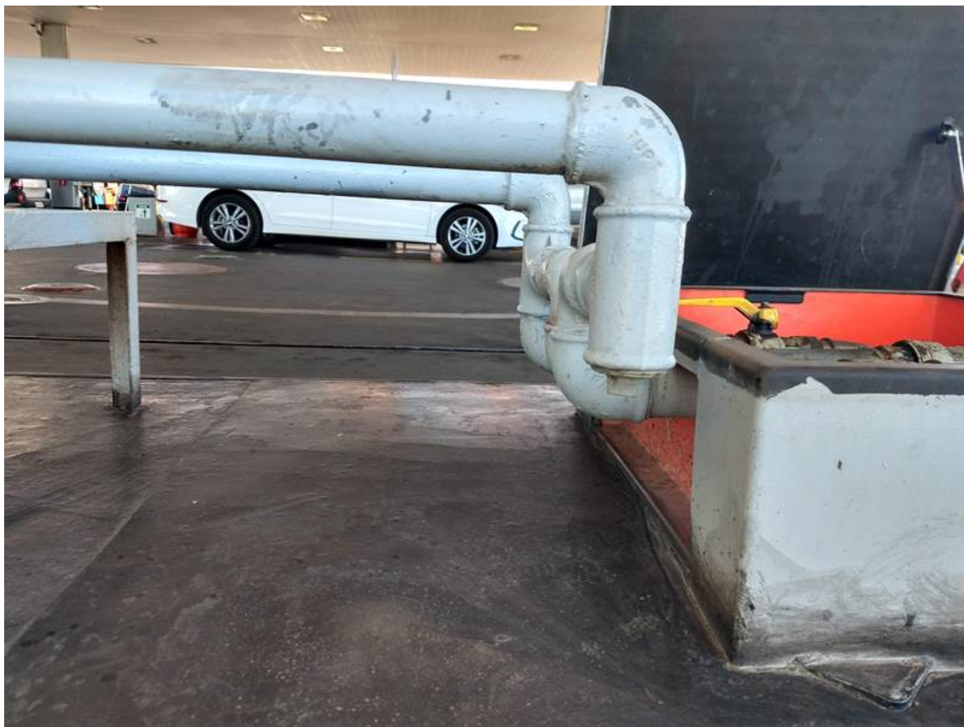
Figura 16 - Destaque das tubulações da unidade filtrante, observa-se que não existe mais tubulação metálica subterrânea e a troca de material é feita na câmara de contenção.
