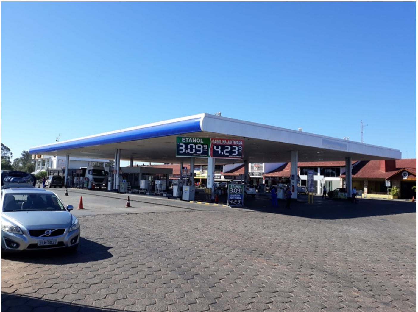
Figura 02 - Visão geral da pista de abastecimento, coberta, circundada por canaletes e piso impermeabilizado.
