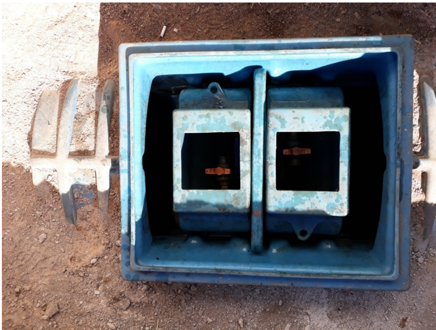
Figura 17 - Caixa separadora de água e óleo e coletor de óleo (modelo compacto).
