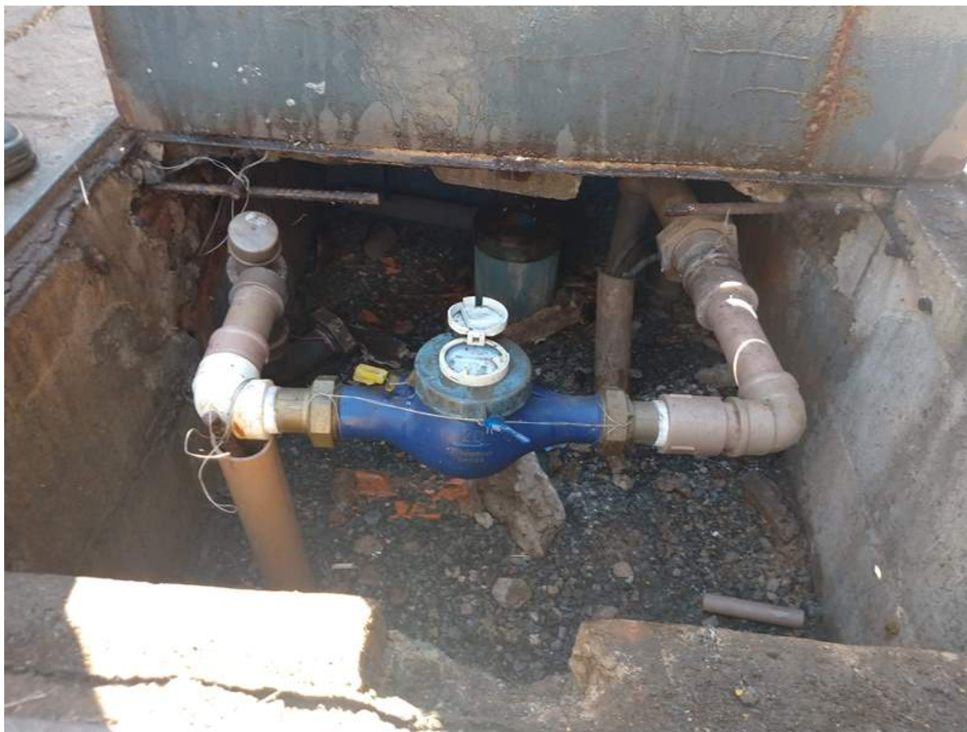
Figura 19 - Poço de captação de água desativado, seu uso foi interrompido até a finalização do gerenciamento de área contaminada no local.
