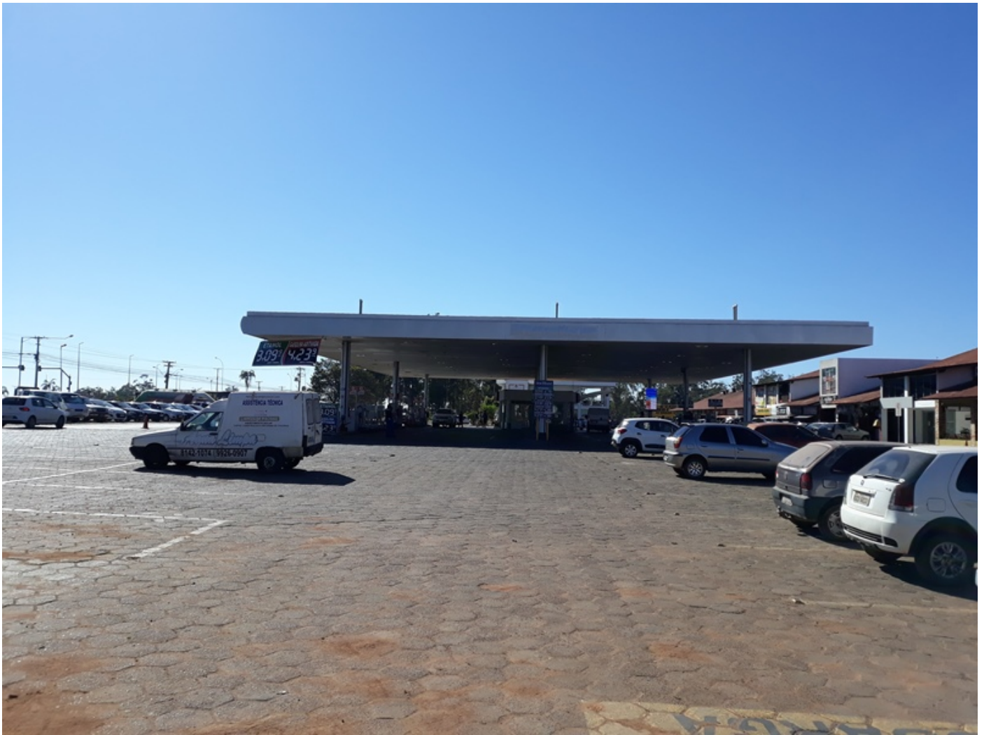
Figura 03 - Visão lateral do empreendimento, onde é possível ver os três conjuntos de respiros das câmaras do tanque, todos dotados de terminal corta-chamas na cobertura da pista de abastecimento.
