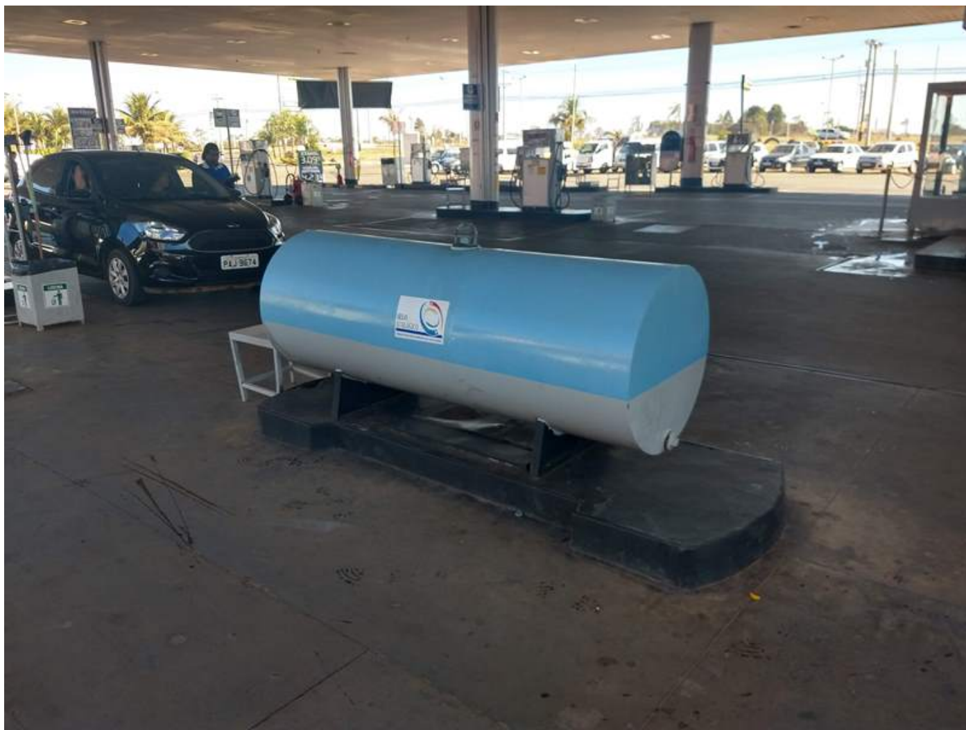
Figura 20 - Tanque de OLUC no interior da pista de abastecimento.
