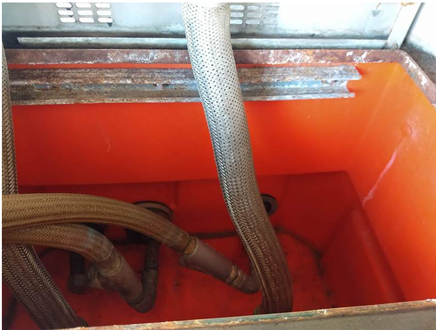
Figura 11 - Câmara de contenção da unidade filtrante, observa-se boa manutenção do equipamento e tubulações em conformidade com as normas técnicas.
