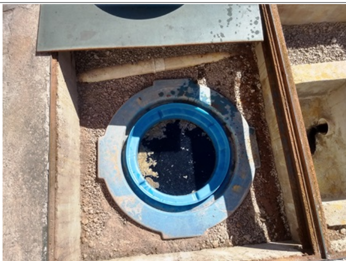
Foto 17- Caixa coletora de óleo.
