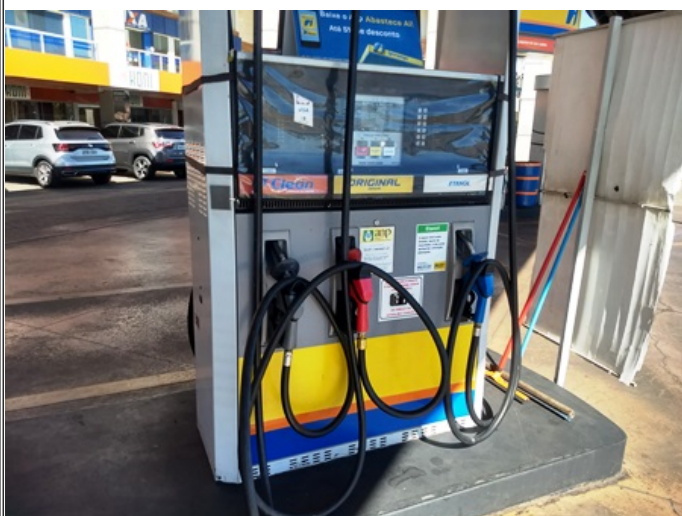
Foto 10 - Unidade abastecedora com 06 bicos injetores.
