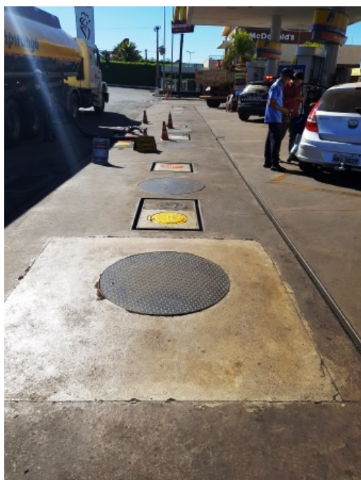
Foto 01 - Área de armazenamento e de descarga de combustíveis.
