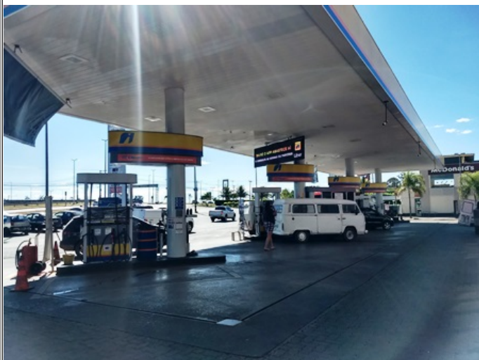
Foto 08 - Vista geral da pista de abastecimento.
