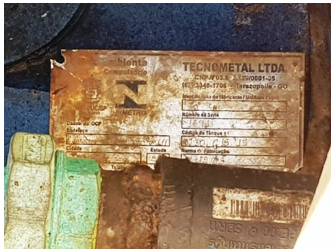
Foto 04 - Placa de identificação do tanque com ano de fabricação de 2009.
