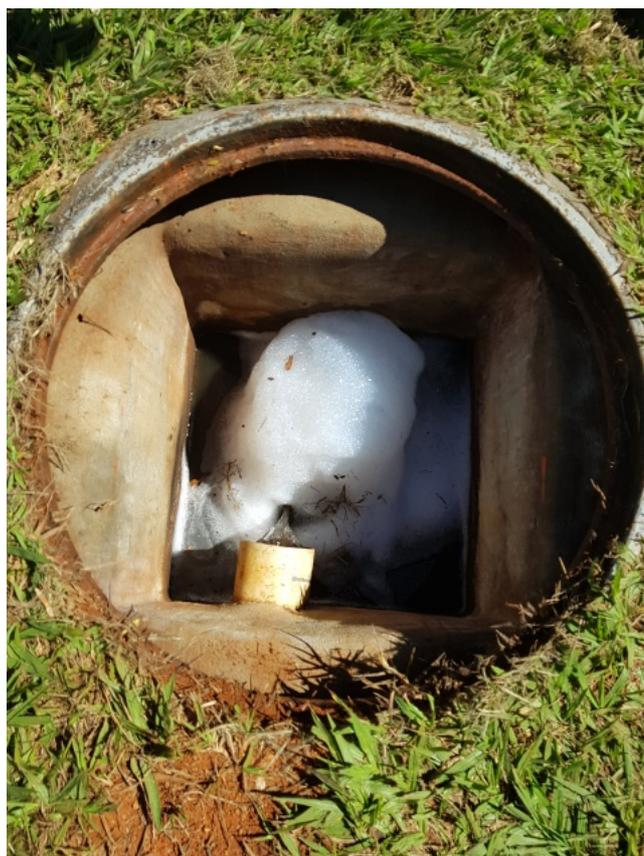
Foto 34 - Caixa de amostragem de efluente
