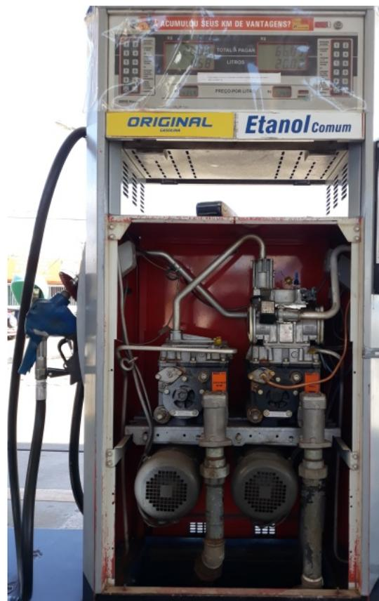
Foto 10 - Unidade abastecedora com dois bicos injetores
