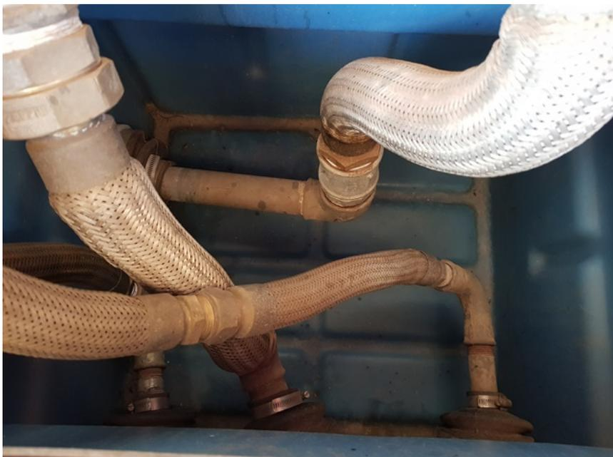
Foto 11 - Sump de bomba - câmara de contenção, em bom estado de manutenção
