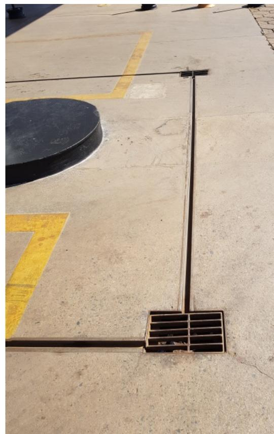
Foto 08 - Canaletes e caixas de passagem do empreendimento em bom estado de manutenção
