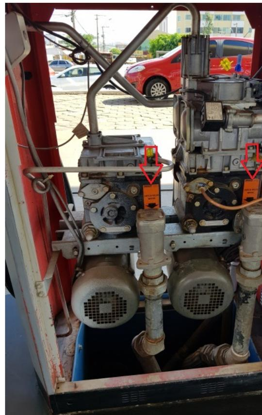
Foto 12 - Check Valve de uma das unidades abasteced
