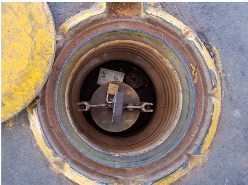
Foto 03 - Descarga selada sobre o tanque, com placa de identificação
