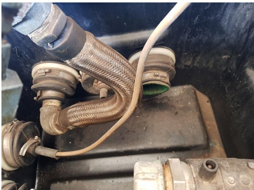
**Foto 16** - Câmara de contenção de unidade de filtragem de diesel, apresentando falta de manutenção e com uma da tubulação aberta
