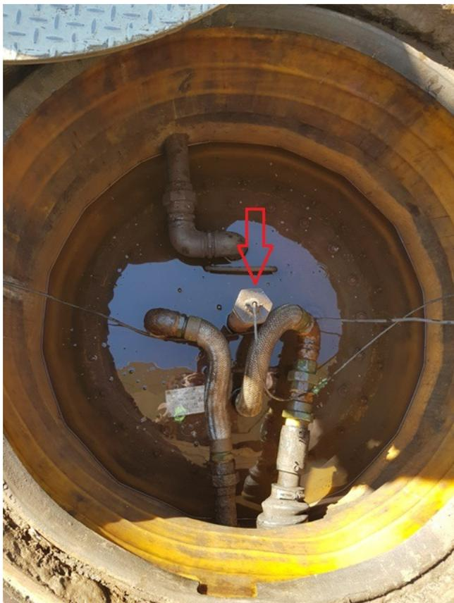
Foto 06 - Controle de estoque instalado em um dos tanques
