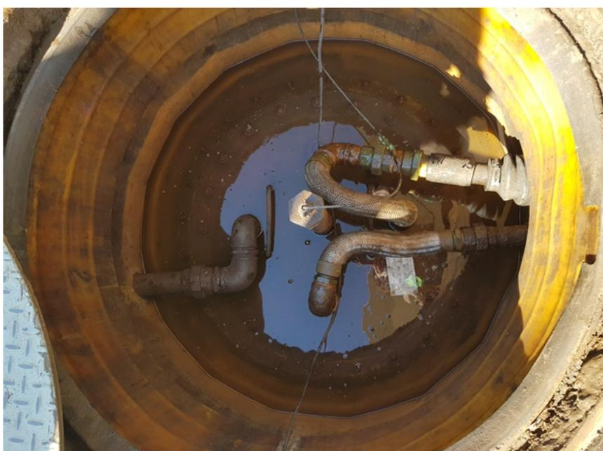
Foto 04 - Boca de acesso ao tanque, ainda com tubulação metálica e com falta de manutenção
