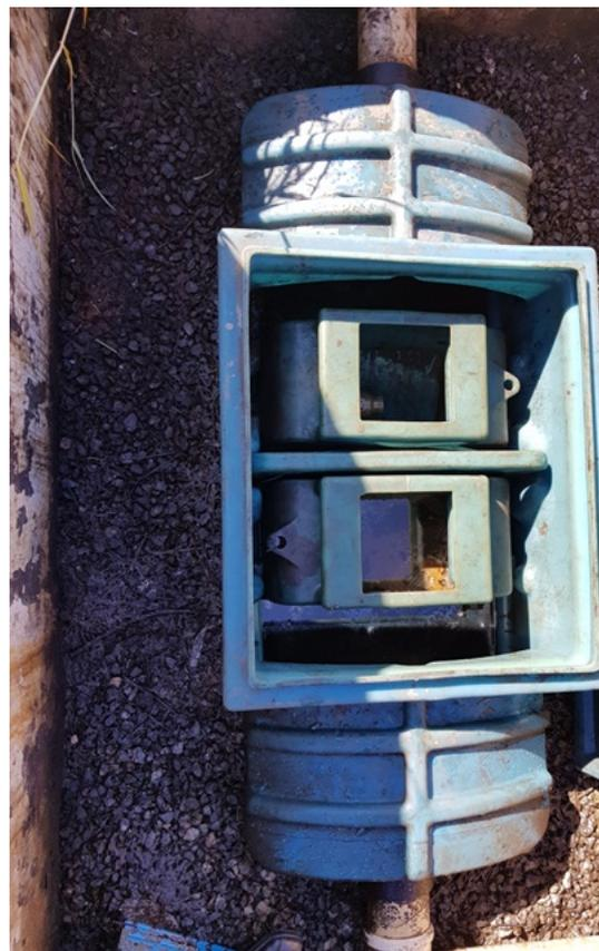
Foto 23 - S.A.O das pistas de abastecimento, com boa manutenção e funcionando de acordo com a ABNT 14.605-2
