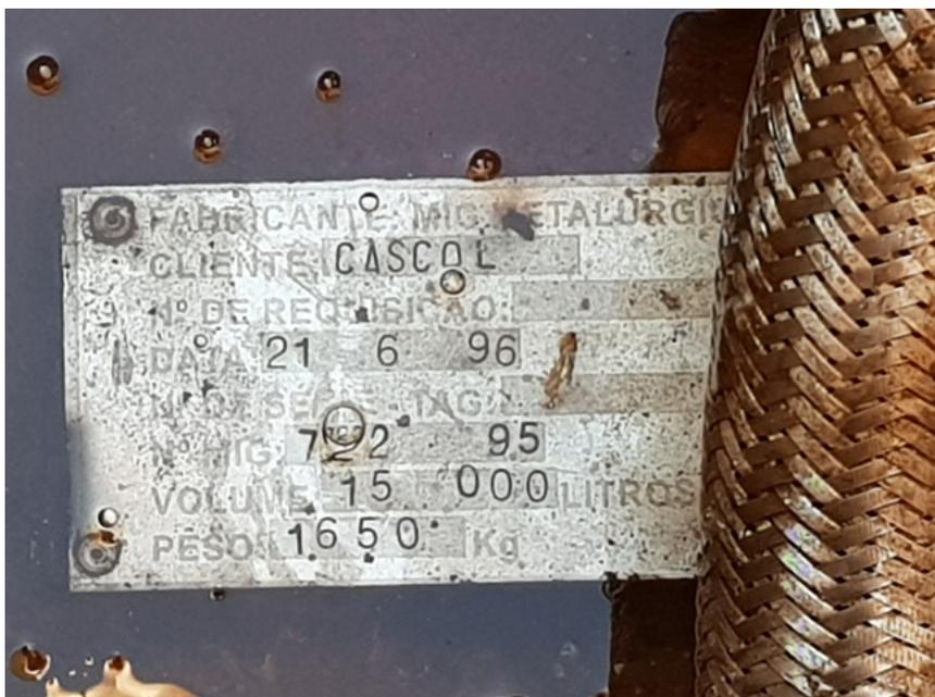
Foto 02 - Placa de identificação de um dos tanques
