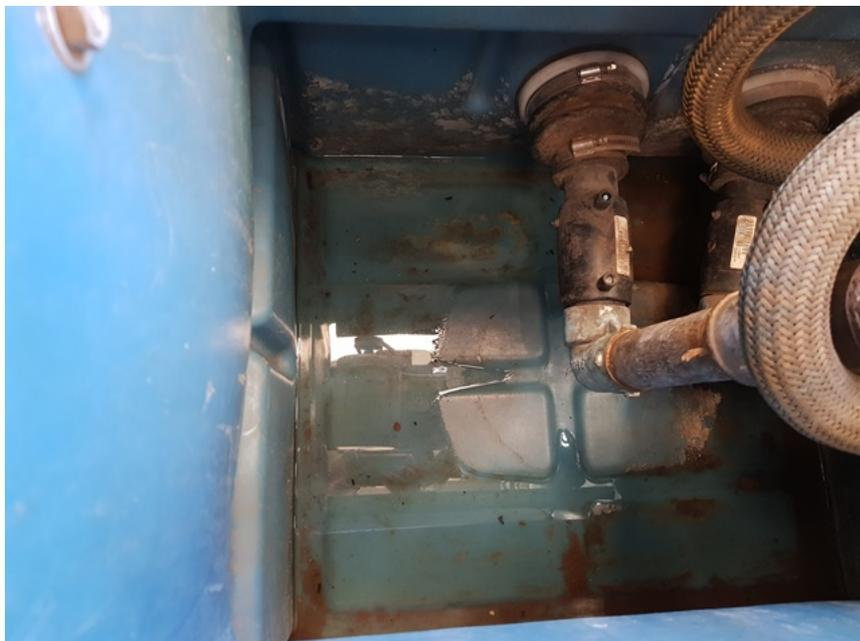
**Foto 14** - Sump de bomba, com água em seu interior, apresentando falta de manutenção
