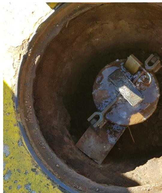
Foto 03 - Descarga selada sobre o tanque, sem c
