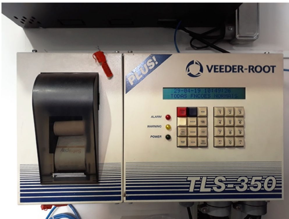
Figura 15 - Sistema de Monitoramento Ambiental. Observa-se que o sistema opera de forma correta (luz verde) conforme exige a ABNT NBR 15594-3:2008 tabela 1.
