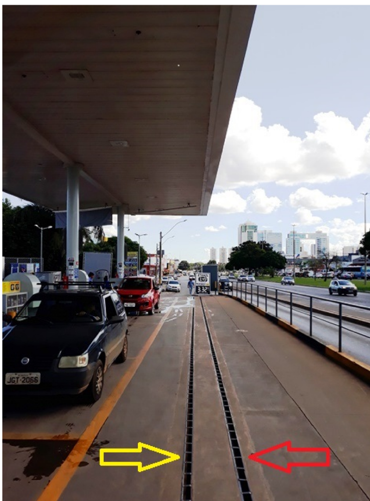
Figura 7 - Canaletes Internos ( seta amarela ) do Sistema de Drenagem Oleosa - SDO com recuo interno de 0,5 metros conforme exige a ABNT NBR 14.605-2:2010 item 4 e externos ( seta vermelha ) do Sistema de drenagem de águas pluviais da pista de abastecimento
