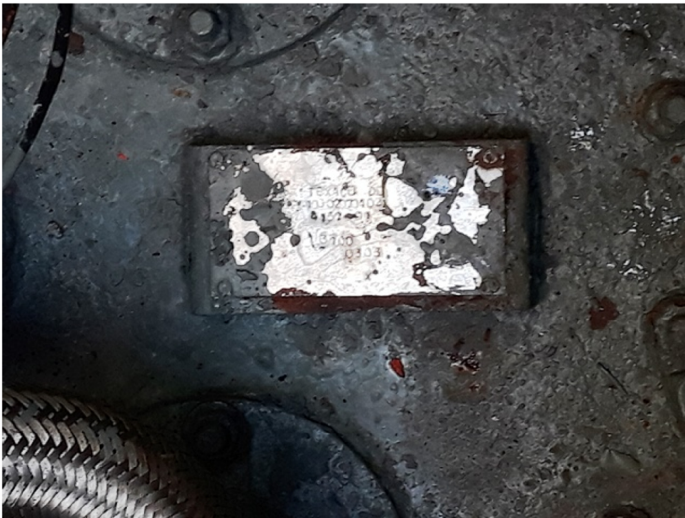
Figura 12 - Placa de identificação de um dos SASC, observa-se o estado de conservação da placa de identificação.
