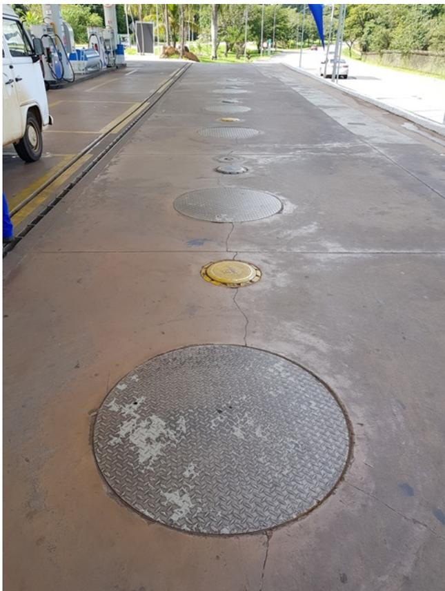
**Foto 01** - Tanques do empreendimento, percebe-se algumas trincas na área de tancagem
