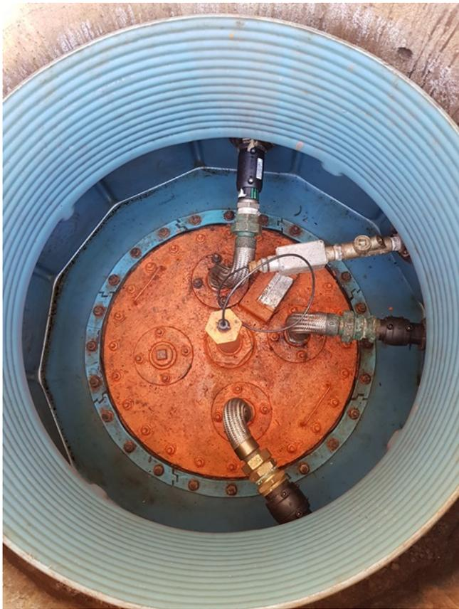
**Foto 05** - Câmera de contenção do tanque, em bom estado de manutenção
