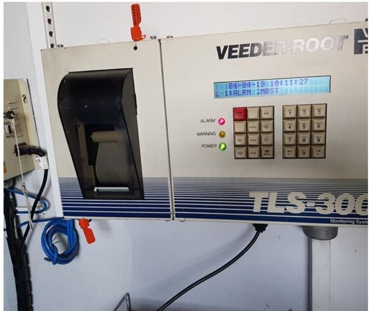
**Foto 06** - Monitoramento eletrônico dos tanques - "Veeder-Root"
