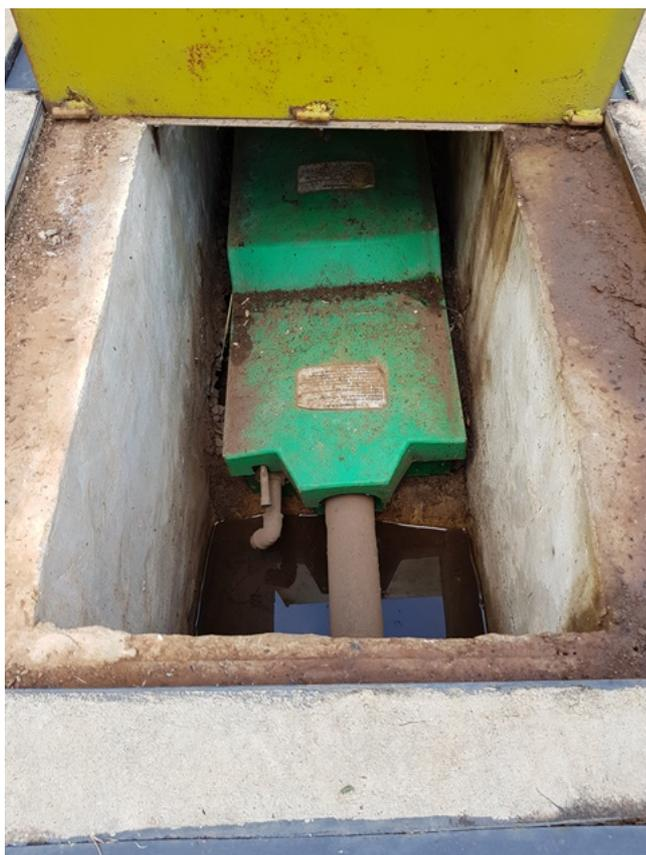
Foto 21 - Espécie de S.A.O próximo a área de lubrificação desativada
