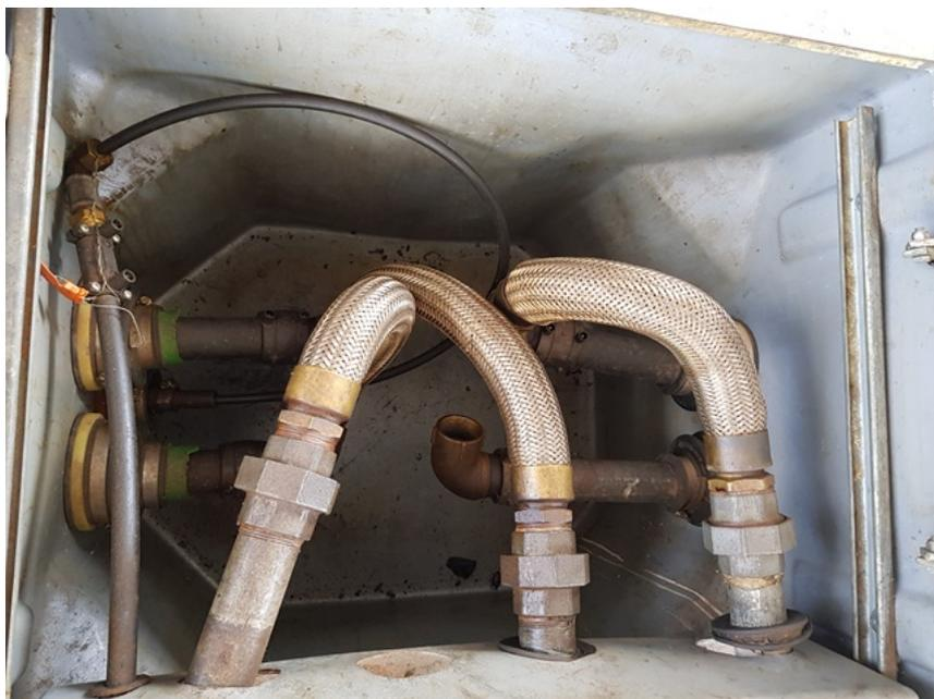
Foto 17 - Unidade de filtragem de óleo diesel localizada na área de abastecimento e dotada de câmara de contenção, foi verificado que uma das tubulações estava aberta.
