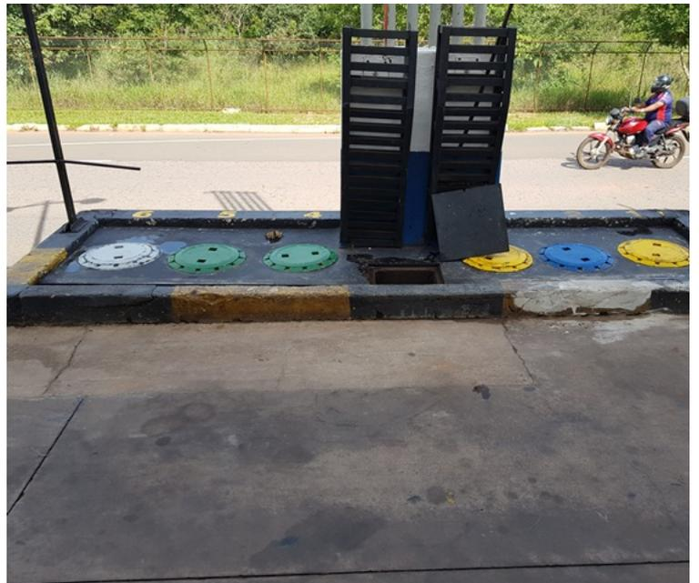
**Foto 08** - Descarga selada a distância, circundada por canaletes e em bom estado de r
