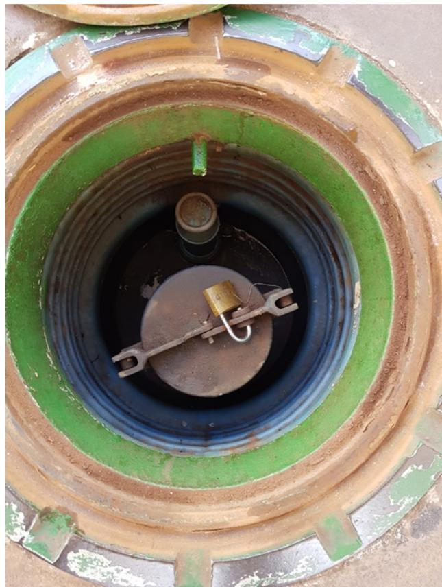
**Foto 04** - Descarga selada sobre o tanque, com válvula anti-transbordament
