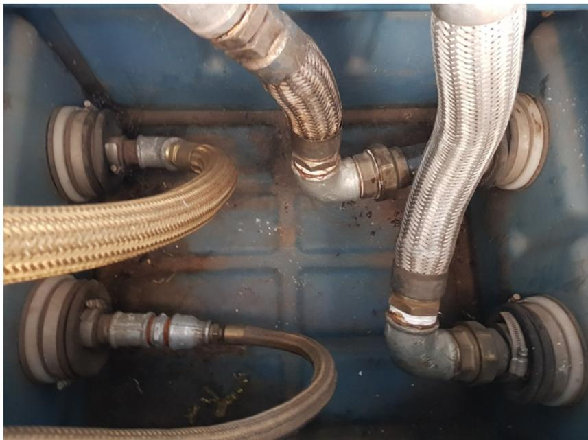
Foto 15 - Sump de bomba, com a tubulação corretamente contida, necessitando de manutenção
