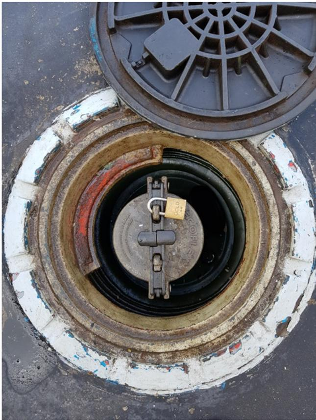
**Foto 09** - Descarga selada a distância, apresentando bom estado de manutenção
