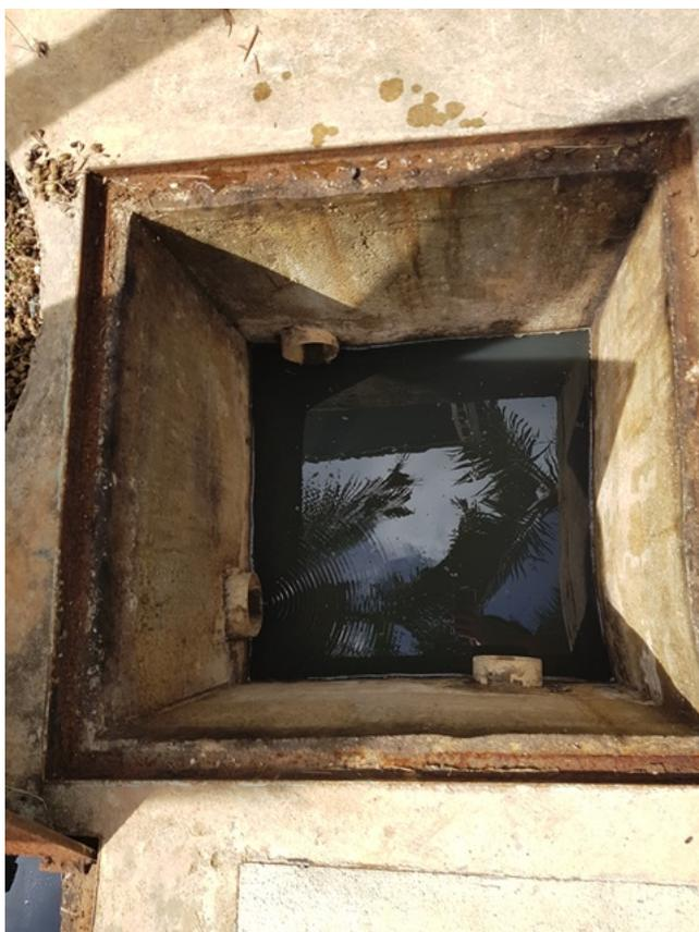
Foto 28 - Caixa de amostragem de efluente
