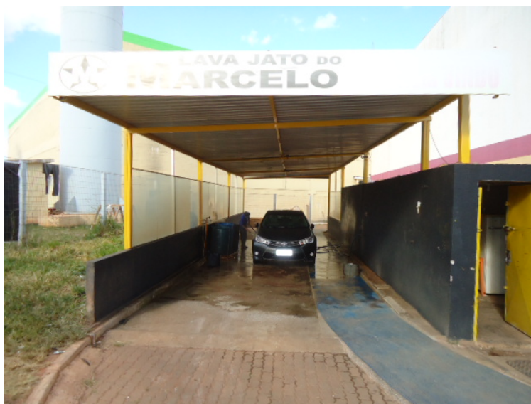
Foto 6. Área de lavagem de veículos sem canaletes.
