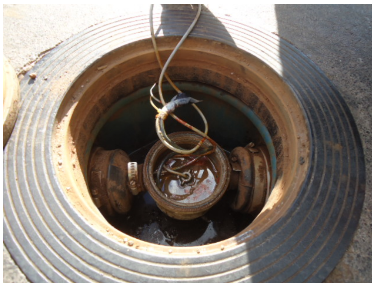
Foto 5. Monitoramento intersticial de um dos tanques está em mal estado de conservação.
