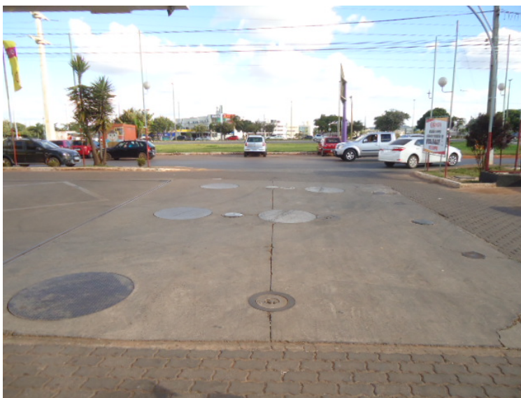
Foto 8. Área de tancagem.
