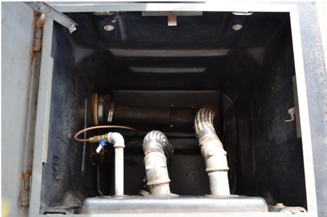
**Figura 7** - Detalhe interno da Câmara de contenção da unidade de filtragem de óleo Diesel. Observa-se que a tubulação esta totalmente contida no *sump de filtro* da câmara de contenção no dispositivo de segurança. O *sump* das demais unidades necessitam de manutenção operacional diária conforme exige a ABNT NBR 15594-3:2008 tabela 1
