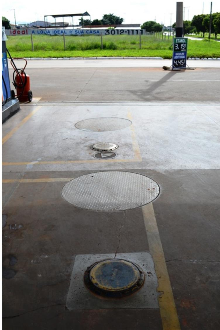
**Figura 9** - Aspecto da área de tancagem do SASC tanque bipartido com capacidade de 30 m<sup>3</sup>.
