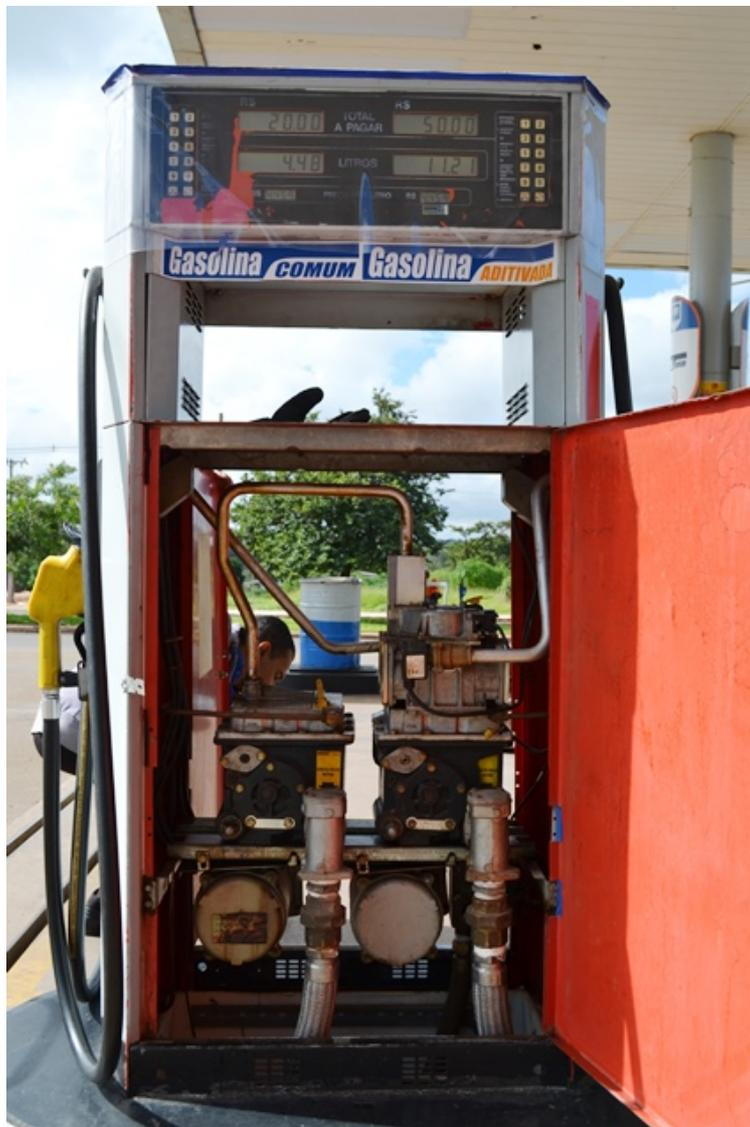
**Figura 3** - Unidade abastecedora de Gasolina Comum, Diesel e Etanol com o dispositivo de segurança *check-valve*, observa-se que a tubulação está limpa e totalmente contida na câmara de contenção para unidade da bomba. A unidade necessita de manutenção operacional diária conforme exige a ABNT NBR 15594-3:200 tabela 1.
