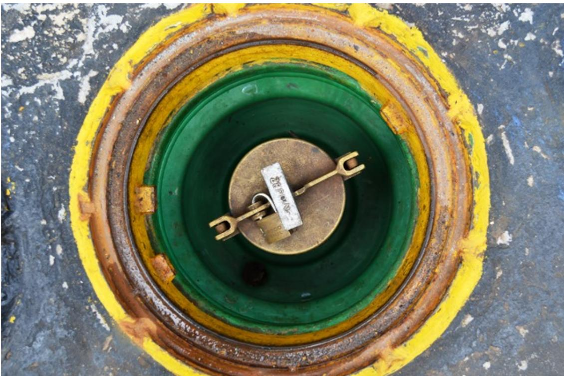
**Figura 18** - Aspecto de um dos 5 (cinco) dispositivos do conjunto da Descarga Selada à Distância com câmara de contenção (*Spill container*). Observa-se que o dispositivo está em bom estado de conservação. O dispositivo necessita de manutenção operacional constante conforme exige a ABNT NBR 15594-3:2008 tabela 1.
