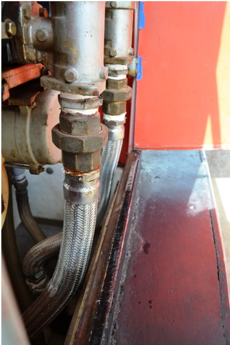
**Figura 4** - Aspecto externo da Câmara de contenção de uma das Unidades Abastecedoras do SASC. Observa-se que a tubulação está fora do *sump* da câmara de contenção do dispositivo de segurança. Os *sumps* das demais unidades necessitam de manutenção operacional diária conforme exige a ABNT NBR 15594-3:2008 tabela 1.
