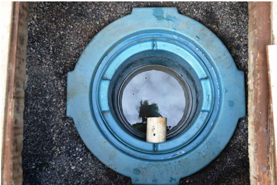
**Figura 12** - Aspecto da Caixa de areia do Separador de água e Óleo da pista de Abastecimento. O sistema deverá realizar manutenção operacional semanal conforme exige a ABNT NBR 155943:2008 tabela 1.
