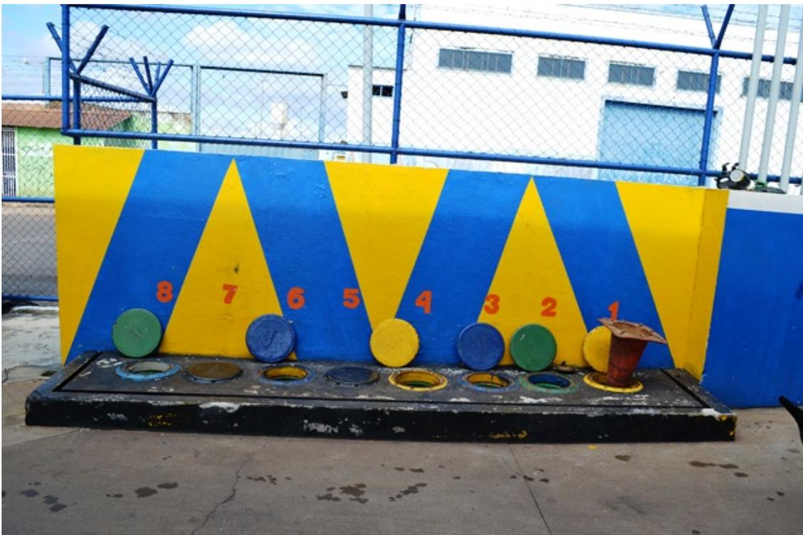
**Figura 16** - Aspecto da Descarga selada à distância. Observa-se que o dispositivo é circundado por canaletas direcionadas ao CSAO da pista de abastecimento.
