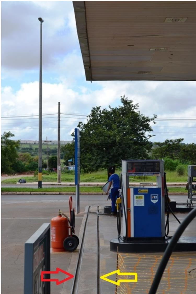
**Figura 8** - Canaletes Internos (*seta amarela*) do Sistema de Drenagem Oleosa - SDO com recuo interno de 0,5 metros conforme exige a ABNT NBR 14.605-2:2010 item 4 e externos (*seta vermelha*) do Sistema de drenagem de águas pluviais da pista de abastecimento.
