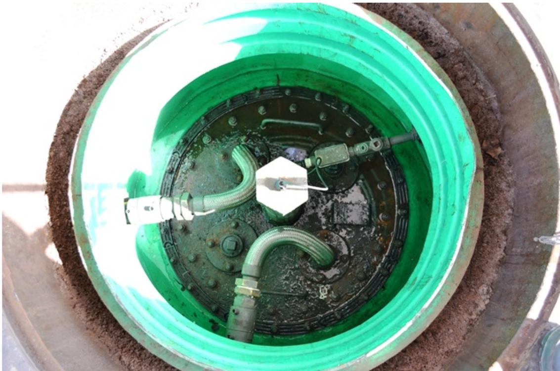
**Figura 10** - Aspecto da Câmara de contenção de acesso à boca de visita (*sump de tanque*) do
