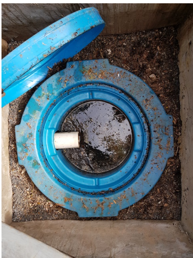
Foto 19 - Caixa de areia
