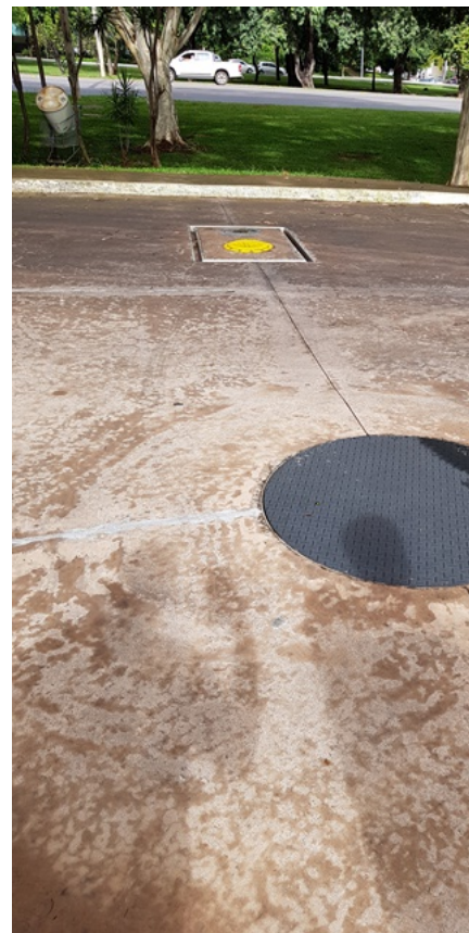
Foto 02 - Tanque do outro lado do posto sendo, 01 (um) pleno selado sobre este tanque, apresentava folhas, necessitando de canaletes
