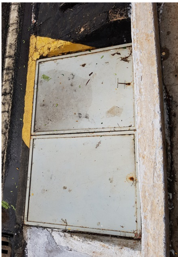
Foto 17 - O Sistema Separador de Água e Óleo
