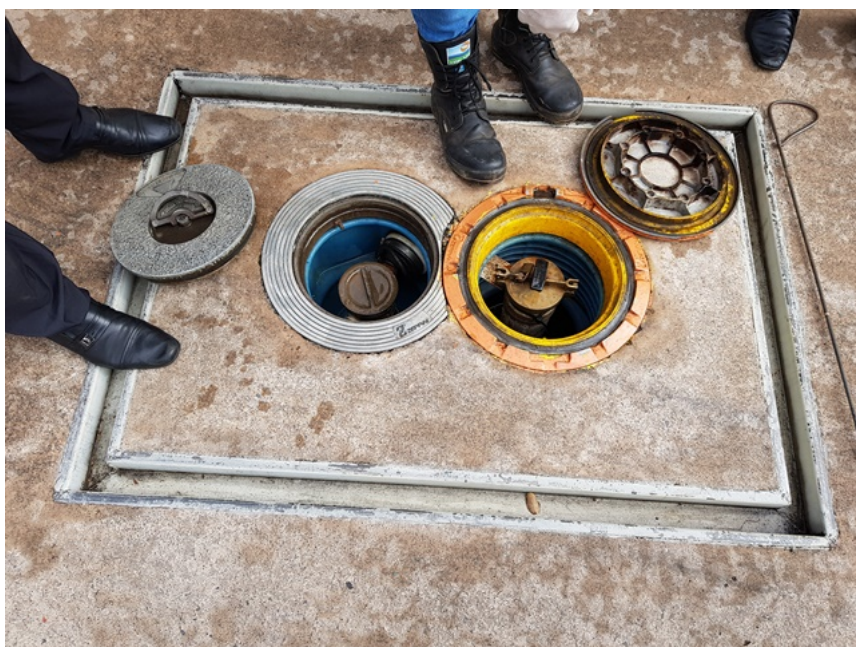
Foto 05 - Descarga selada sobre os tanques, com canaletos ao seu redor e em bom estado de conservação
