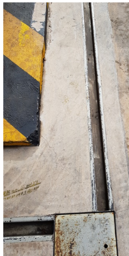
Foto 11 - Canaletas da pista de abastecimento em b
