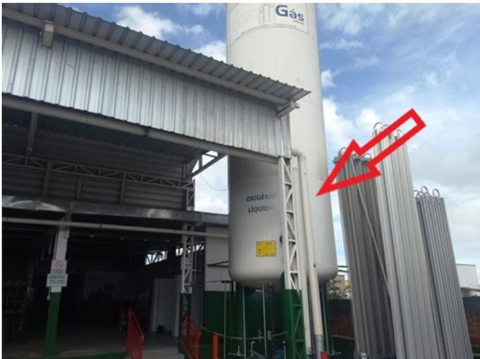
Foto 03 - Tanque de armazenamento de Oxigênio Líquido.
