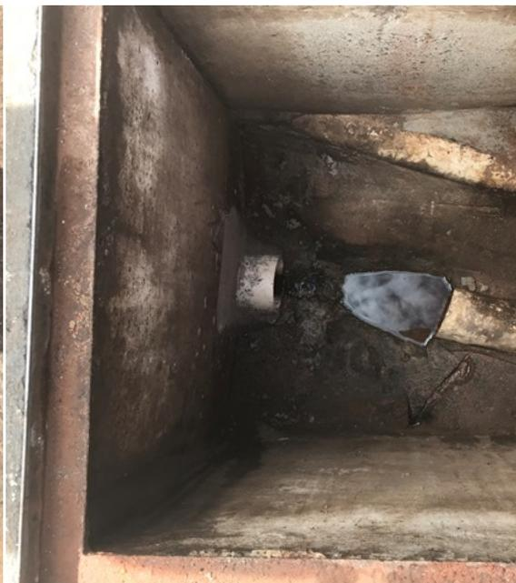
Foto 16. Caixa de amostragem de efluente na pista de abastecimento.
