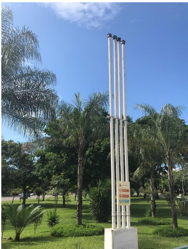
Foto 19. Visão geral dos respiros dos tanques com terminal corta-chamas.
