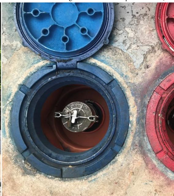
Foto 10. Detalhe das câmaras de contenção das descargas seladas
