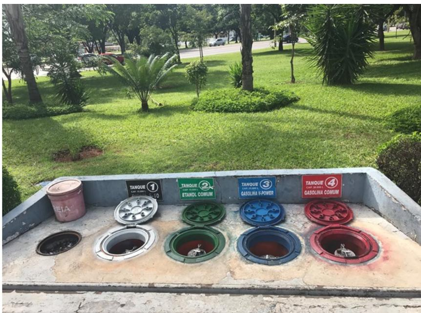
Foto 9. Visão geral da descarga selada à distância.
