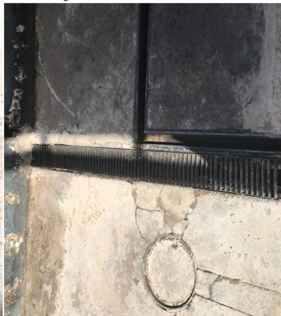
Foto 6. Canaletas da pista de abastecimento instalados incorretamente.
