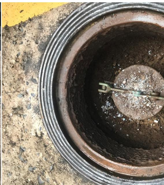
Foto 8. Detalhe da descarga selada sobre o tanque desativado, sem
