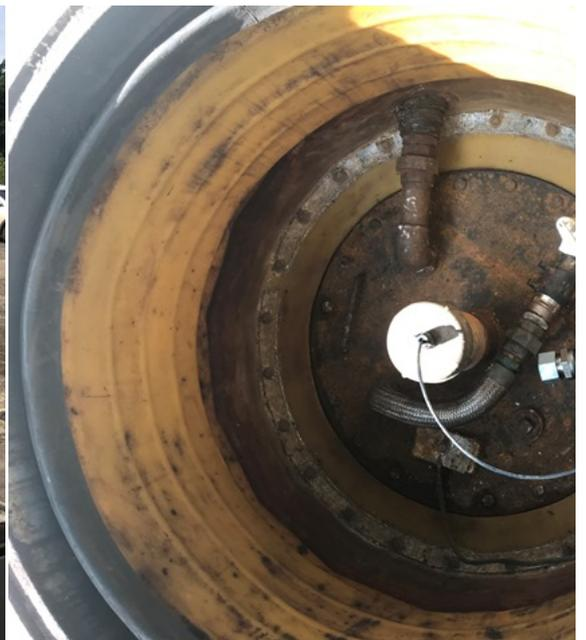
Foto 2. Visão geral da câmara de contenção e as tubulações metálicas
