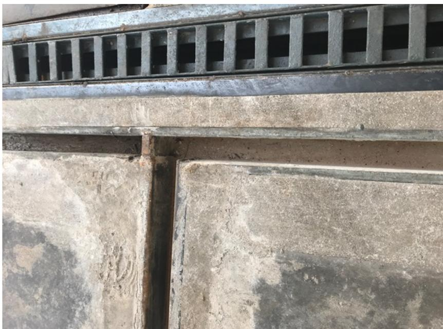
Foto 7. Detalhe do canaleta instalado incorretamente.
