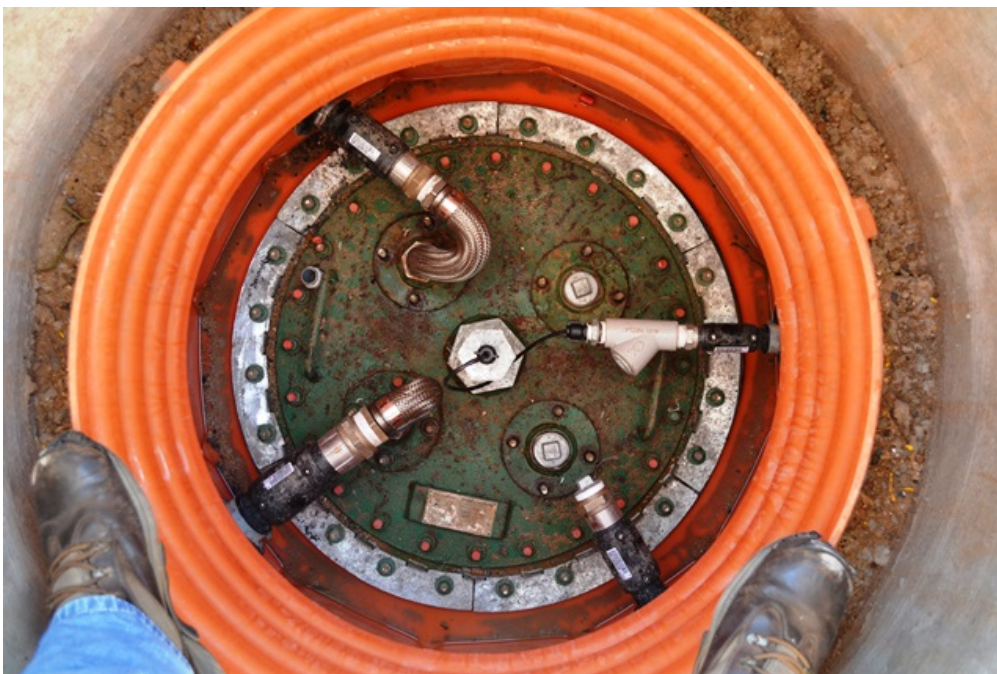
Figura 10 - Aspecto da Câmara de contenção de acesso à boca de visita ( sump de tanque ) do tanque com controle eletrônico de estoque, tubulação metálica flexível, tubulação subterrânea em PEAD e flanges de vedação . O tanque deverá ter manutenção operacional constante conforme exige a ABNT NBR 15594-3:2008 tabela 1.
