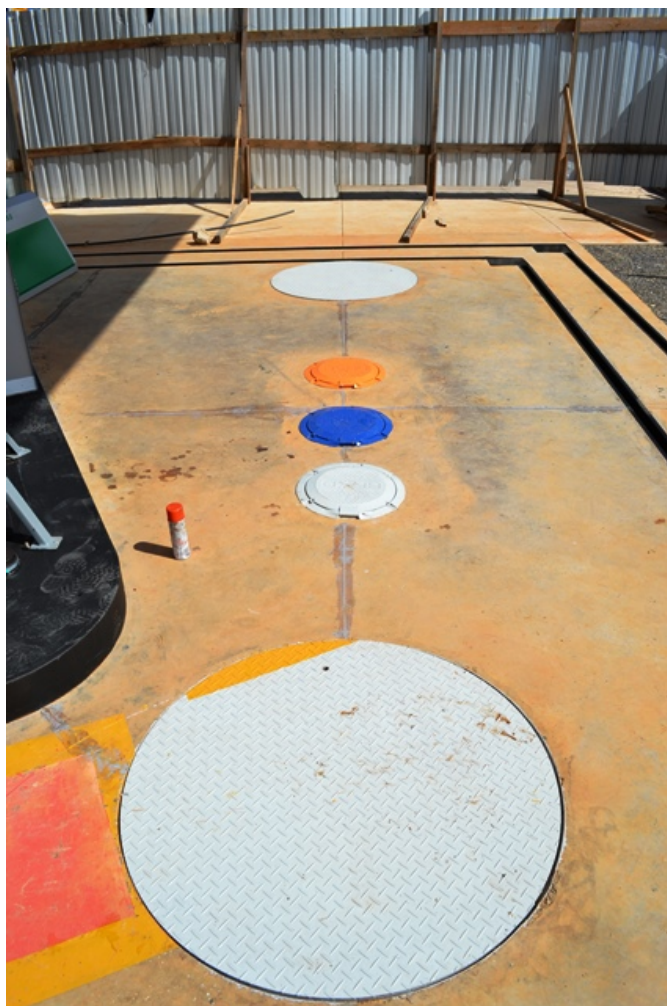
Figura 9 - Aspecto da área de tancagem do SASC tanque bipartido com capacidade de 30 m 3 .
