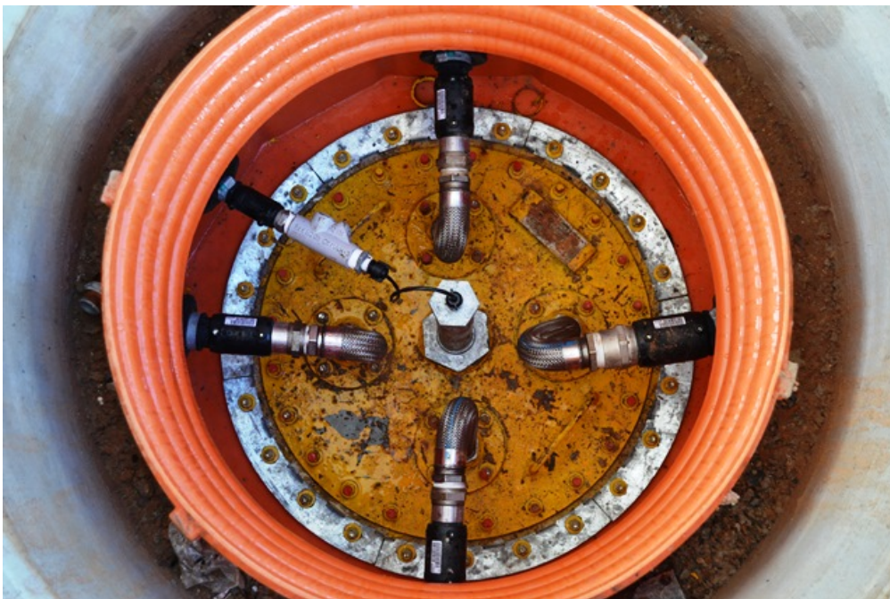
Figura 11 - Aspecto da Câmara de contenção de acesso à boca de visita de um dos SASC ( sump de tanque ) do tanque com controle eletrônico de estoque, tubulação metálica flexível, tubulação subterrânea em PEAD e flanges de vedação . O tanque deverá ter manutenção operacional constante conforme exige a ABNT NBR 15594-3:2008 tabela 1.
