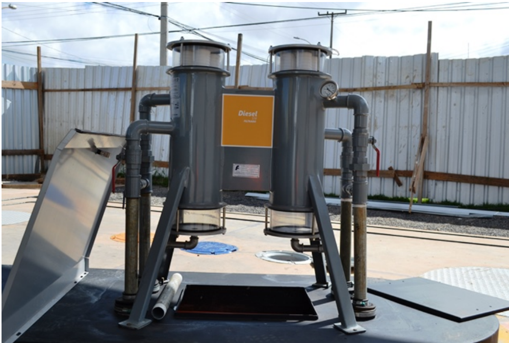
Figura 6 - Aspecto do Filtro desidratador duplo.
