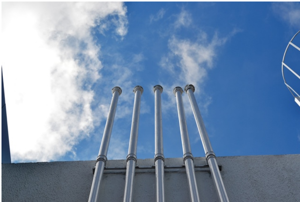
Figura 9 - Respiros com terminal corta chamas em conformidade com o que é exigido na ABNT NBR 13783:2014 item 8.3.4.
