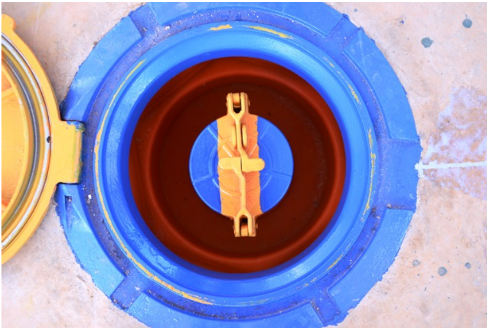
Figura 13 - Dispositivo de Descarga selada sobre o tanque com câmara de contenção ( Spill container ou descarga ) sem válvula anti-transbordamento. O dispositivo deverá ter manutenção operacional constante conforme exige a ABNT NBR 15594-3:2008 tabela 1.
