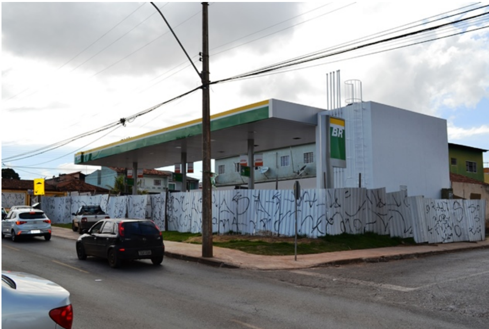
Figura 2 - Vista geral do Posto
