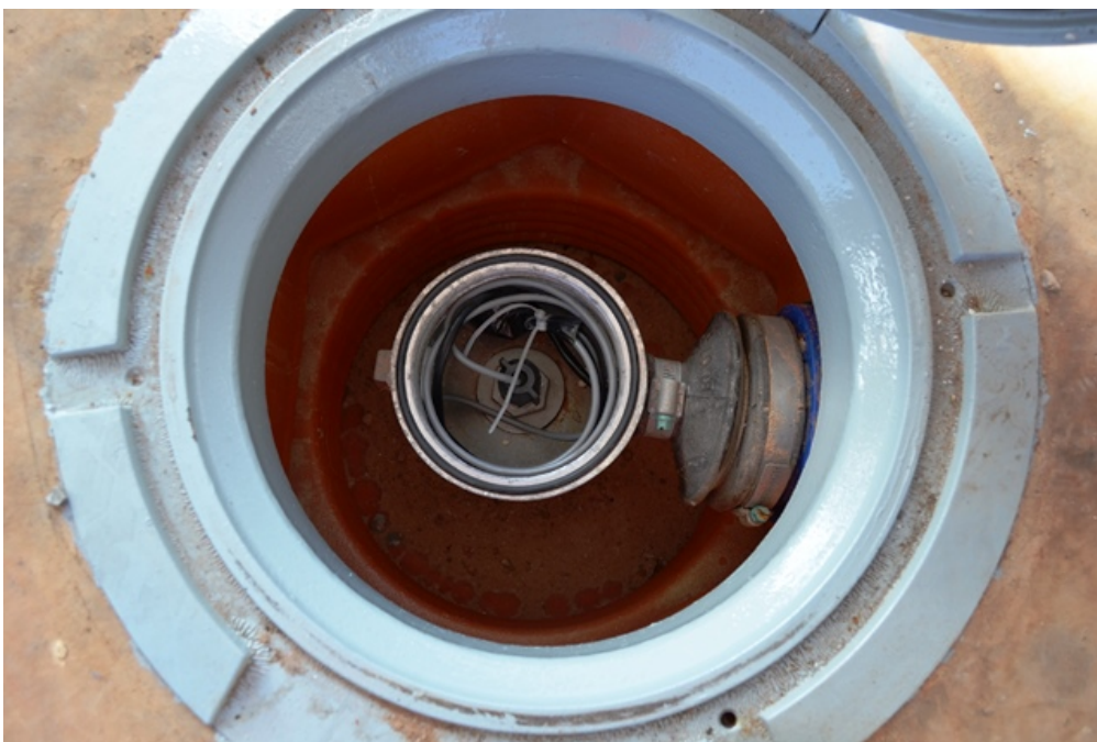
Figura 14 - Dispositivo do Monitoramento do interstício do tanque de parede dupla. O dispositivo deverá ter manutenção operacional constante conforme exige a ABNT NBR 15594-3:2008 tabela 1.
