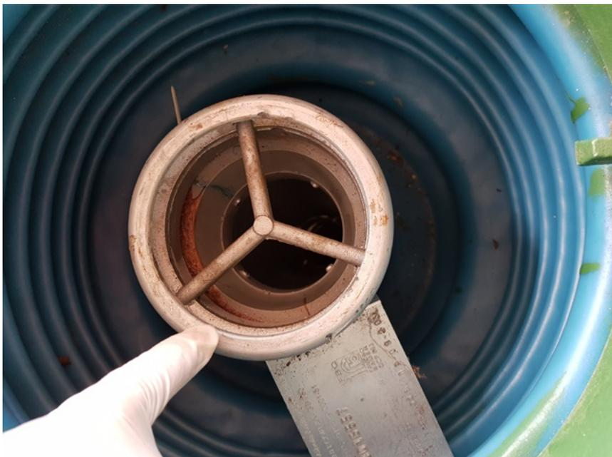
Foto 03 - Descarga selada sobre o tanque e com válvula anti-transbordamento
