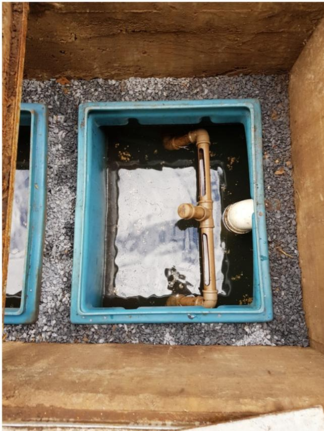
**Foto 24** - Caixa separadora de água e óleo da área de abastecimento
