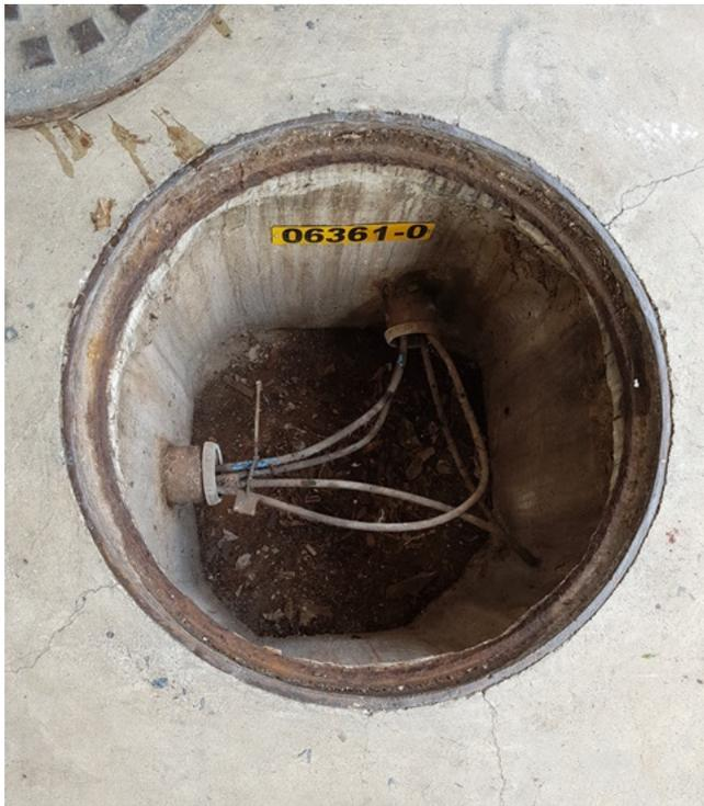
**Foto 17** - Compartimento da parte elétrica do posto, na área de abastecimento
