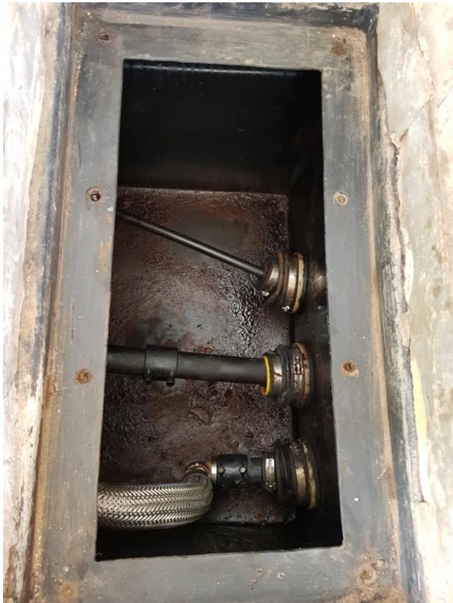
Foto 15 - Interior da câmara de contenção do diesel, com resíduos de combustível em seu interior
