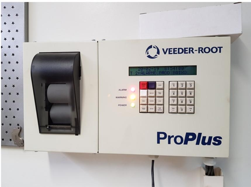
Foto 05 - Controle de estoque "Veeder-Root", os alarmes estavam acionados pois os tanques estão vazios
