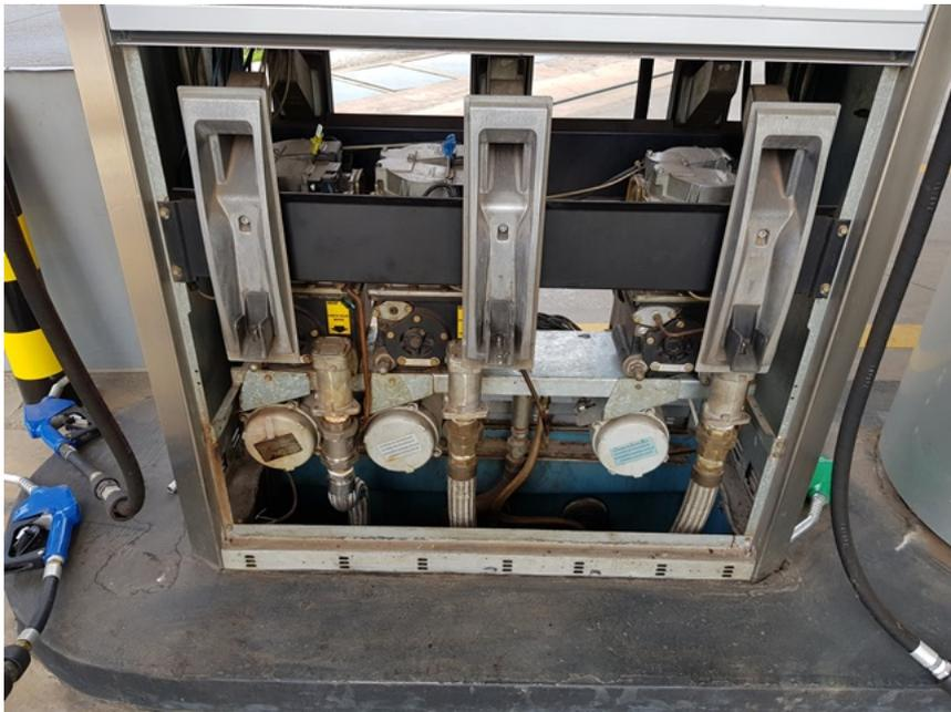
Foto 13 - Válvulas de retenção instaladas na linha de sucção – Check Valve
