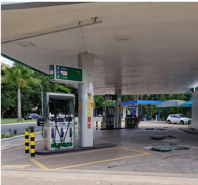
**Foto 09** - Vista geral da área de abastecimento, em bom estado de conservação, sem fissuras e com canaletes circundando toda a área
