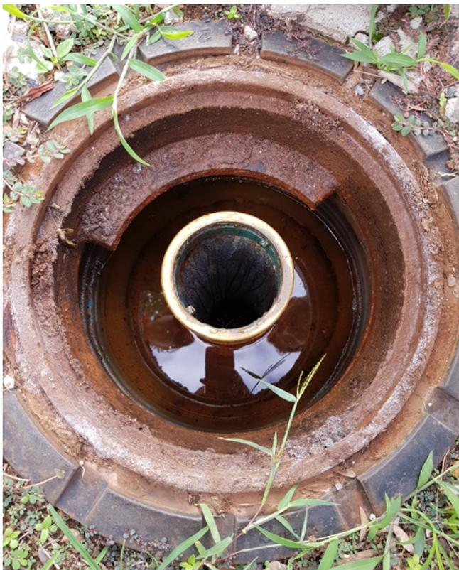
**Foto 27** - Tanque de OLUC, com vestígios de óleo, sem monitoramento, sem canaletas ao redor da descarga e sem respiro
