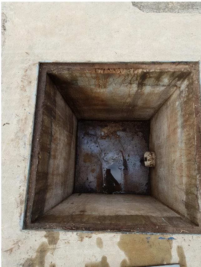
**Foto 26** - Caixa de amostragem de efluente em concreto
