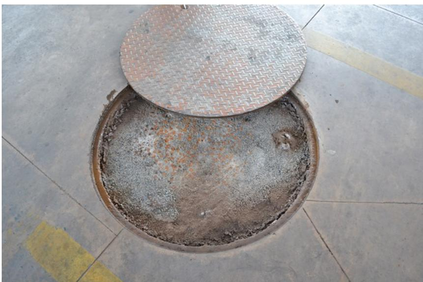
Foto 7. Detalhe da boca de visita de um dos tanques desativados, tamponada com areia.
