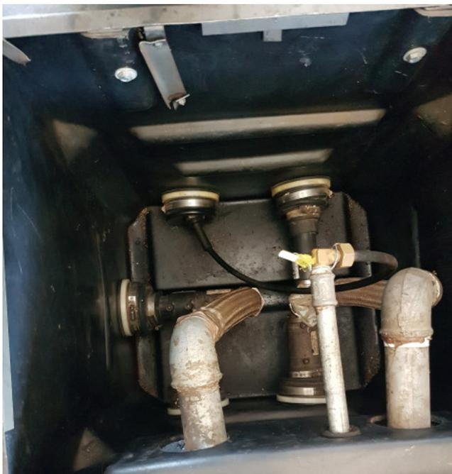
Foto 3. Câmara de contenção do filtro de diesel com a manutenção adequada.
