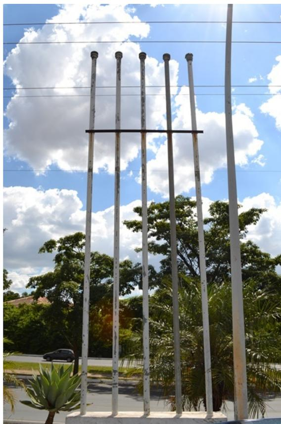
Foto 10. Visão geral dos respiros dos tanques de combustível subterrâneos.
