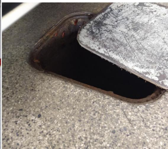
Foto 14. Caixa de esgoto na pista da área de lubrificação.
