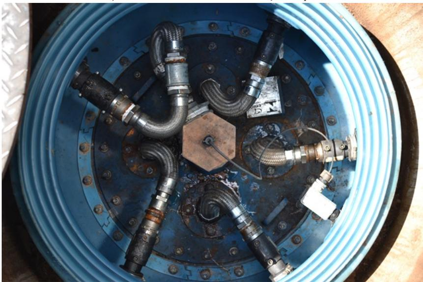
Foto 5. Câmara de contenção de um dos tanques subterrâneos de combustíveis.
