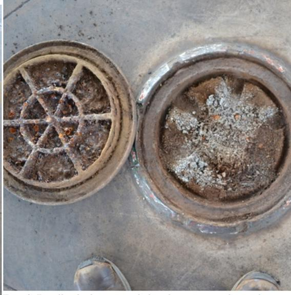
Foto 8. Detalhe de descarga selada sobre o tanque de um dos tanques.
