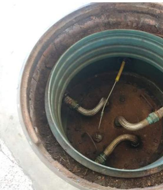
Foto 6. Câmara de contenção de um dos tanques subterrâneos de
