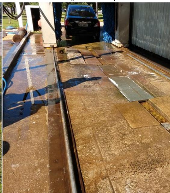
Foto 14. Visão geral da lavagem de veículos sem canaletas.
