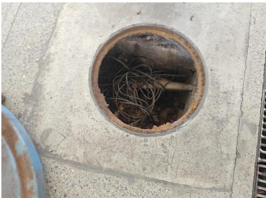
Foto 5. Caixa de passagem de fiações, sem canaletos ao redor.
