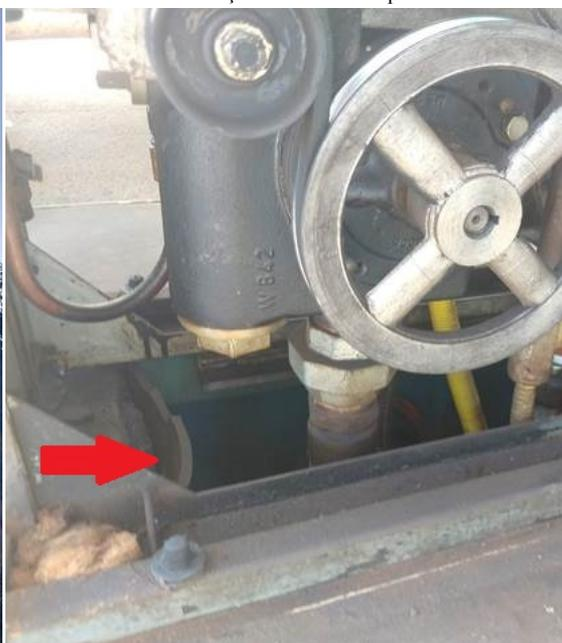
Foto 8. Câmara de contenção da unidade abastecedora deformada
