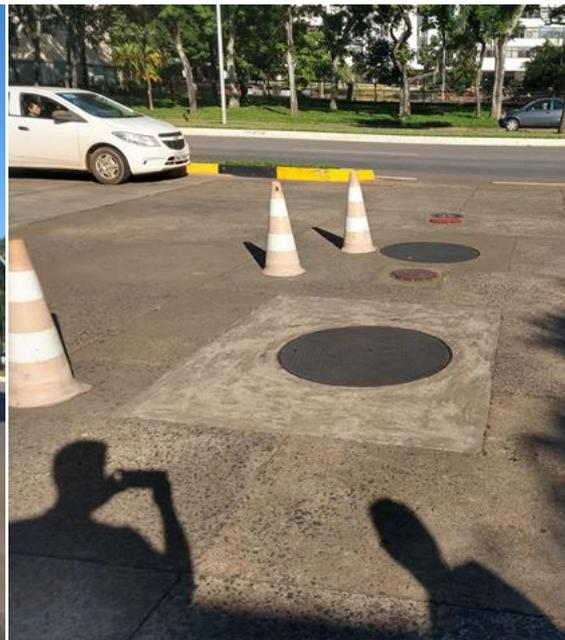
Foto 2. tanque bicompartimentado na lateral da pista de abastecimento
