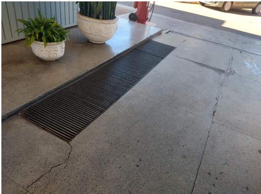
Foto 3. Fissuras na pista e grelha não circundada por canaletes.
