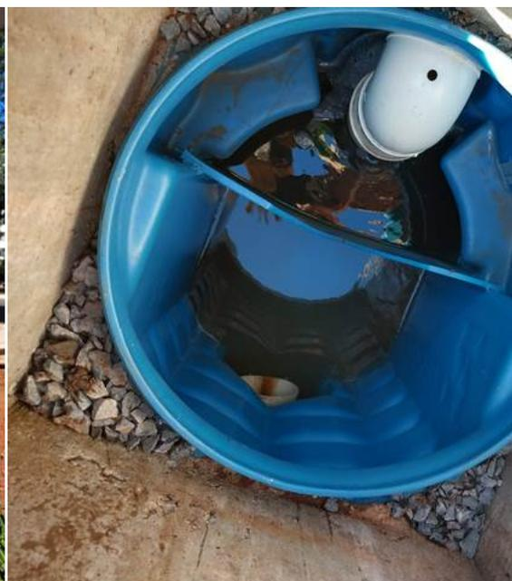
Foto 12. Caixa de amostragem do SAO da pista de abastecimento
