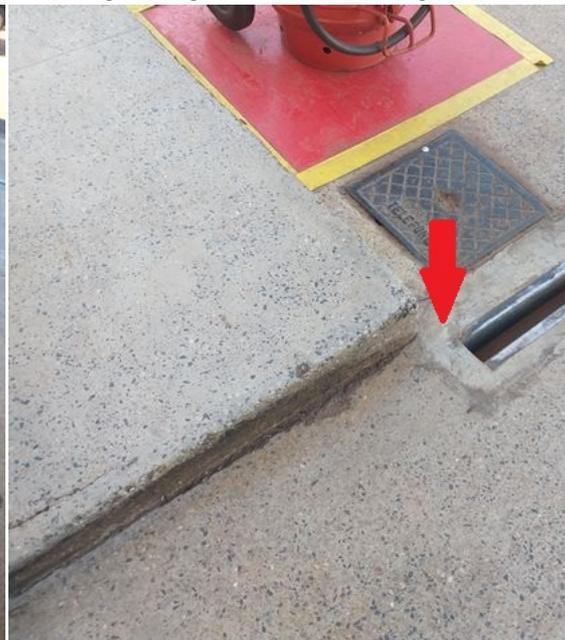
Foto 4. Canaleta da pista de abastecimento instalado de forma inc
