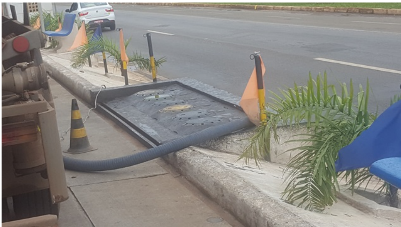
Figura 5: Descarga selada a distância contemplada por canaletas.
