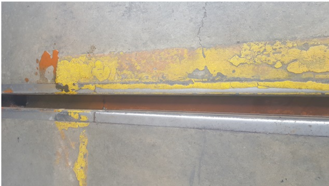
Figura 11: Canaletes da pista de abastecimento em boa manutenção.
