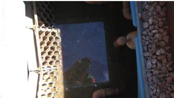
**Figura 23** – Detalhe de um dos compartimentos da Caixa Separadora do SAO da área de lavagem.
