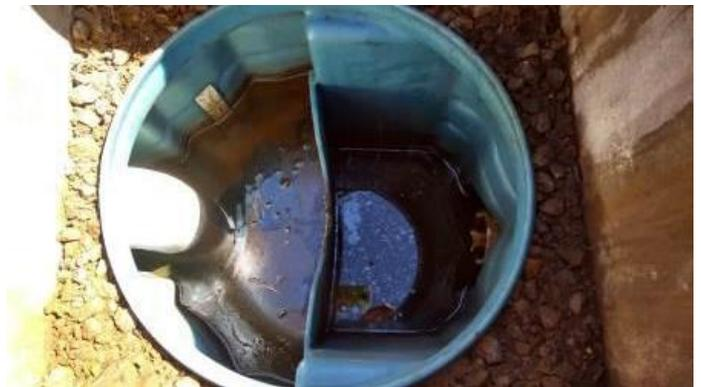
**Figura 18 –** Caixa de Amostragem do SAO da pista de abastecimento.
