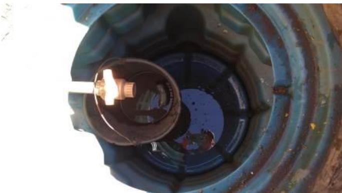
**Figura 19 –** Caixa Coletora de óleo do SAO da pista de abastecimento.
