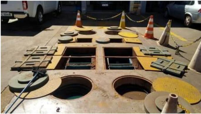
**Figura 15:** Aspecto Geral dos SAO's da área da pista de abastecimento e lubrificação e lavagem de veículos.
