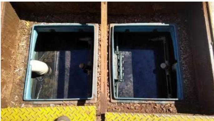
**Figura 17 –** Caixa Separadora do SAO da pista de abastecimento
