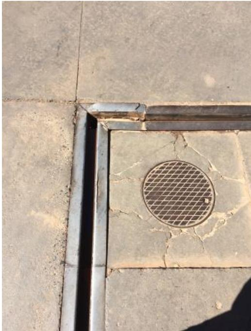
**Figura 8**- Detalhe da danificação interna de um trecho dos Canaletes. Observa-se que essa adequação foi corrigida conforme atesta (15045286)
