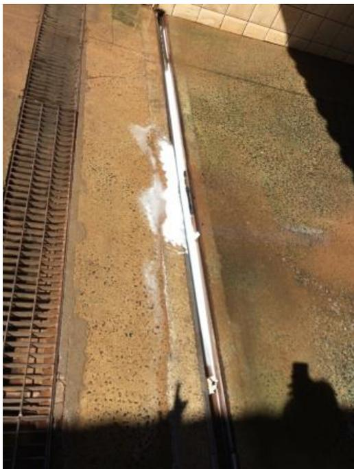
**Figura 43** – Aspecto dos canaletos localizados na área do Lava Jato. Observa-se o extravasamento do efluente gerado quando da lavagem de veículos denotando não está com a inclinação para a caixa de areia central.
