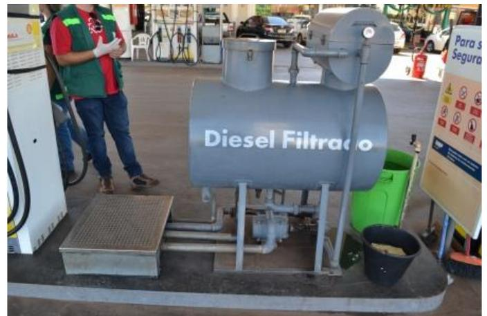
**Figura 5** – Aspecto do filtro de Diesel (S10) com a câmara de contenção da unidade filtrante.
