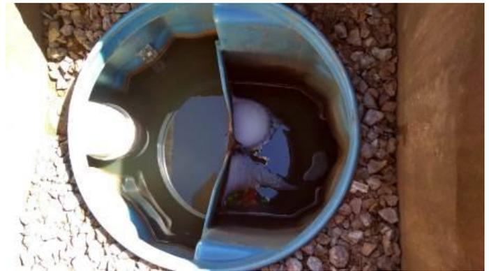
**Figura 24** – Caixa de Amostragem de efluentes do SAO da área de lavagem.
