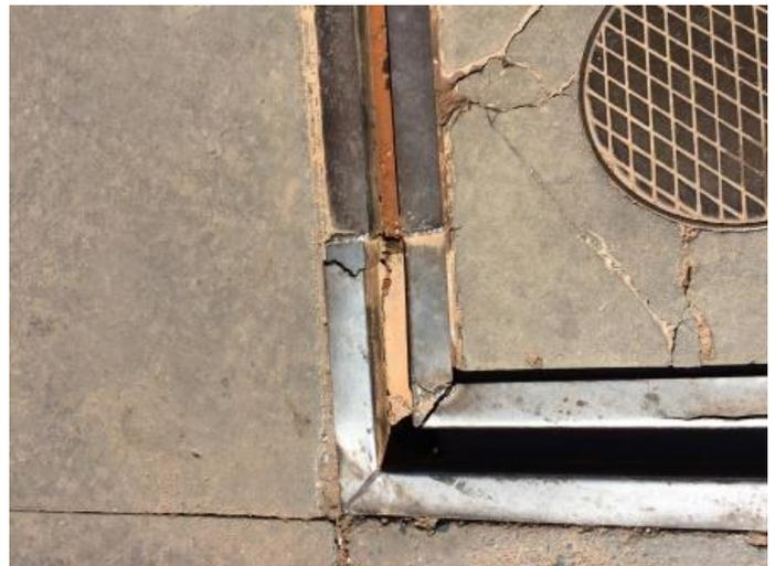
**Figura 9** – Detalhe da danificação interna de um trecho dos Canaletes. Observa-se que essa adequação foi corrigida conforme atesta (15045286)
