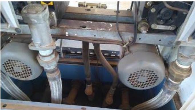
**Figura 4** – Aspecto interno de uma das Unidades abastecedoras com o dispositivo de segurança *Check-valve*.
