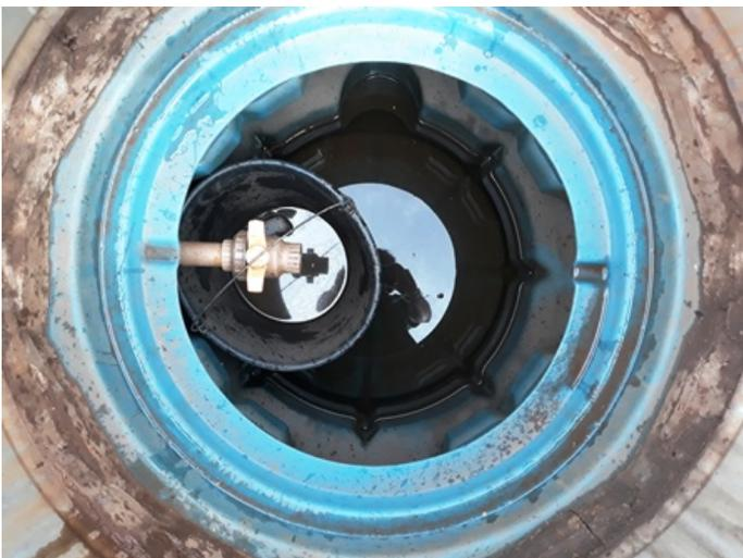
**Figura 25** - Caixa Coletora de Óleo do SAO da área de lavagem.
