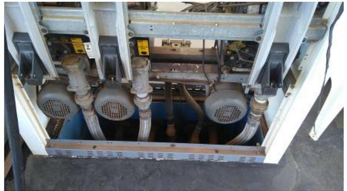
**Figura 3** – Aspecto de uma das Unidades abastecedoras com o dispositivo de segurança, *Check-valve*.
