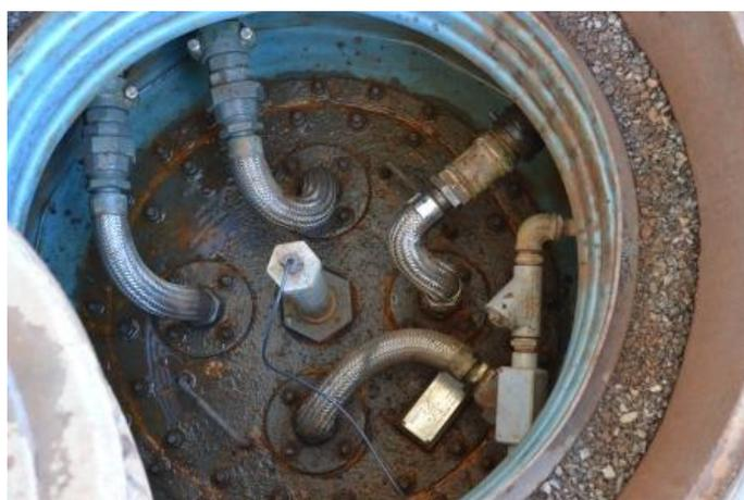
**Figura 30** – Aspecto interno da Boca de Visita do Tanque evidenciado controle eletrônico de estoque e tubulação subterrânea de metal. Observa-se a necessidade de manutenção operacional constante conforme exige a tabela 1 da ABNT NBR 15594-3:2008
