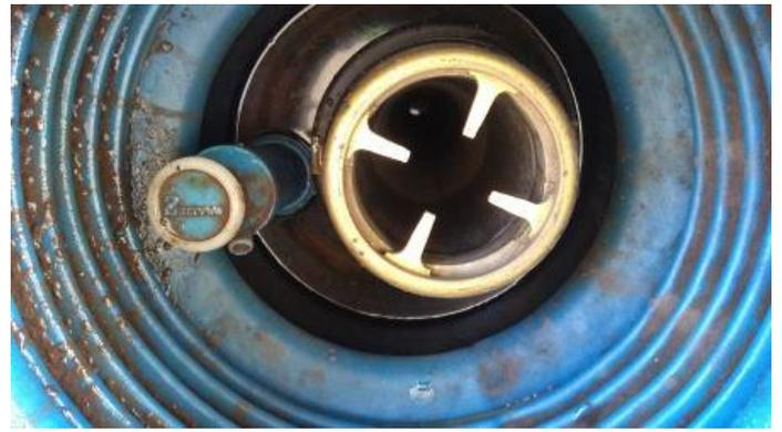
**Figura 32** – Aspecto da descarga selada sobre o tanque, observa-se que não possui *válvula anti-transbordamento*.
