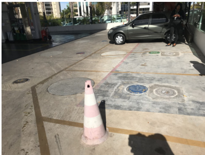
Foto 5. Vista parcial dos tanques.
