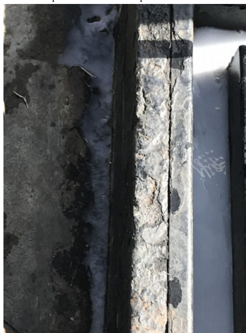
Foto 4. Líquido branco do teste vazando do canaleta das descargas à distância.
