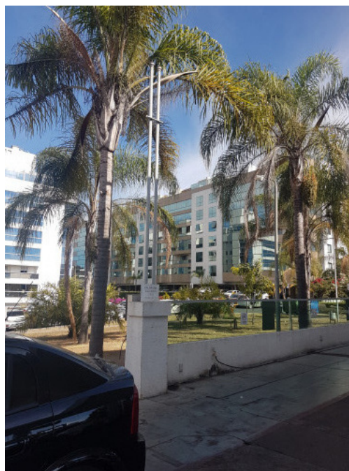
Foto 2. Respiro referente ao tanque novo.
