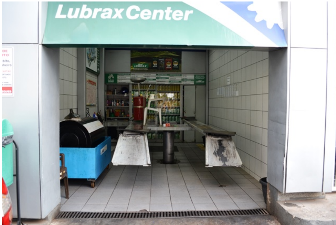
Figura 22 - Área de lubrificação de veículos com cobertura, canaletes, tanque OLU e barril de armazenamento de embalagens de óleos usadas. Observa-se que o local é totalmente coberto e possui canaletes somente na parte frontal.
