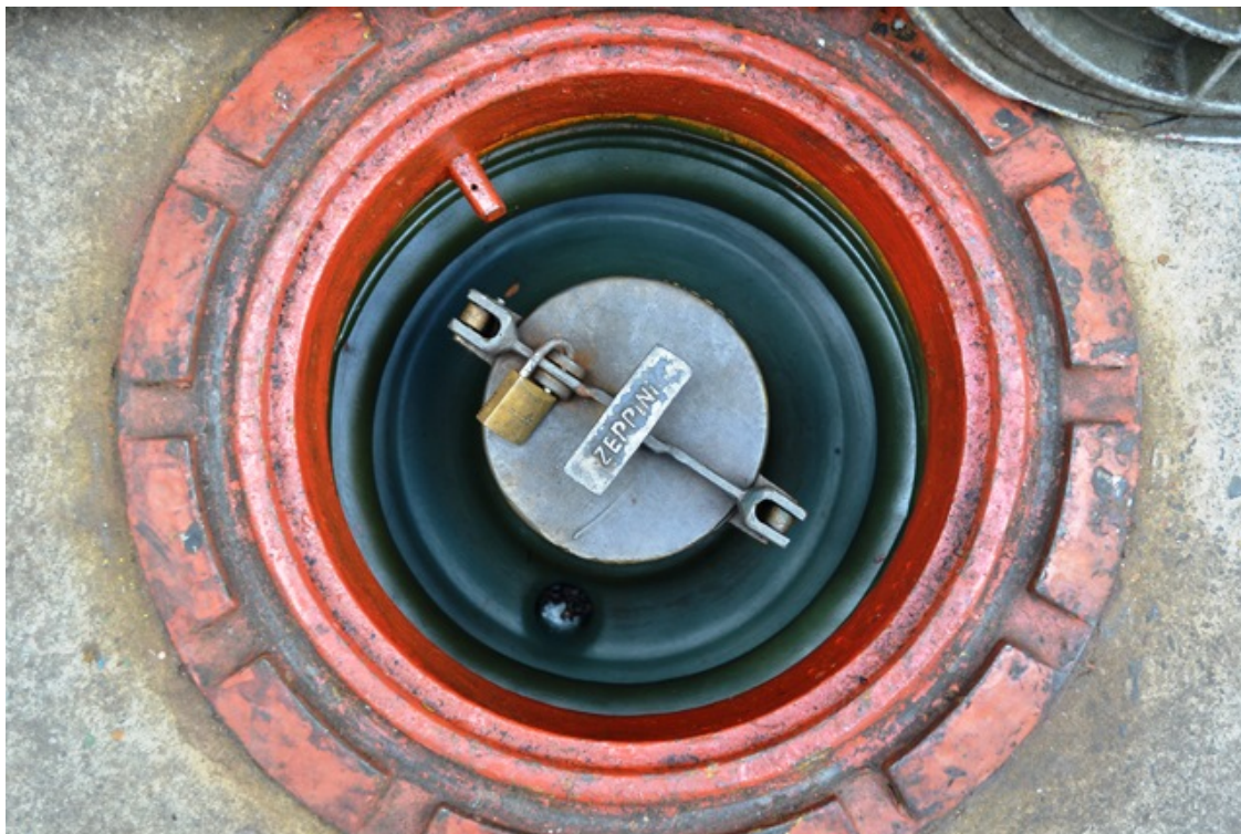
Figura 6 - Aspecto de um dos 7 dispositivos do conjunto da Descarga Selada à Distância com câmara de contenção ( Spill container ). Observa-se que o dispositivo está em bom estado de conservação.
