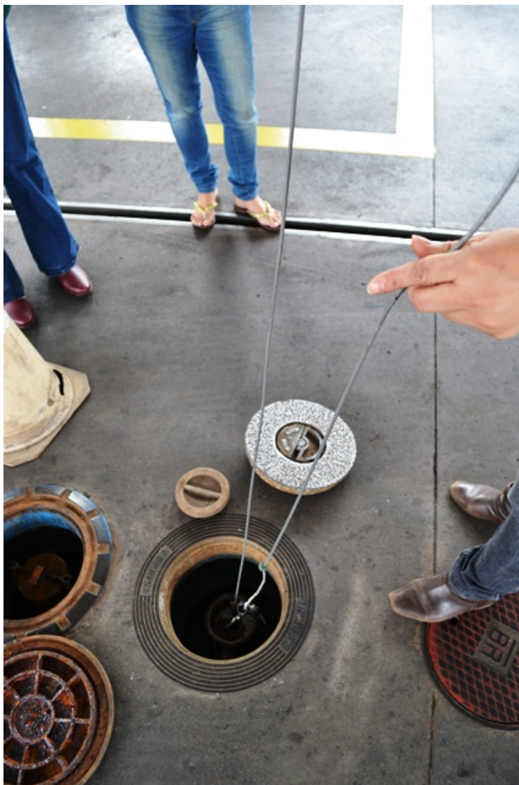
Figura 15 - Verificação do Monitoramento do Interstício de um dos 7 SASC.
