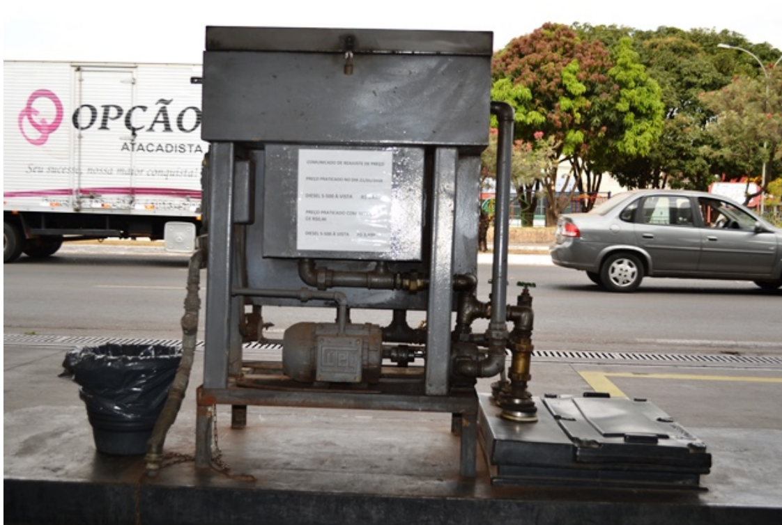
Figura 5 – Aspecto do filtro desidratador de Diesel com sump
