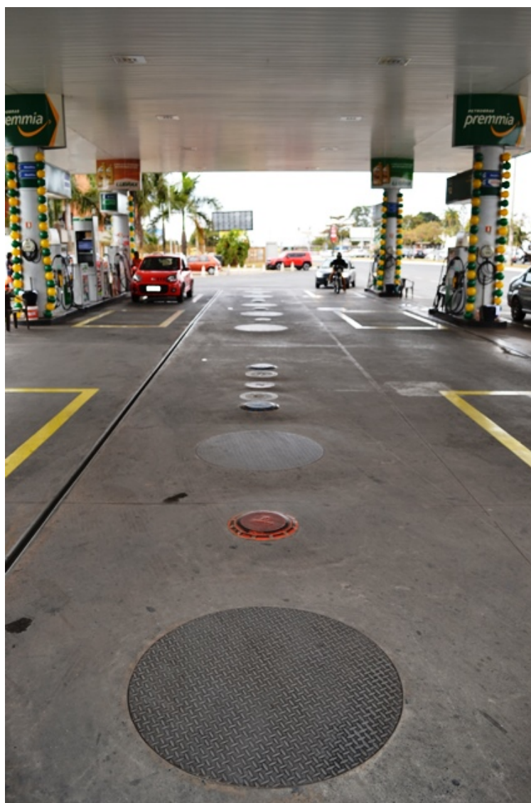
Figura 8 - Respiros com terminal corta chamas.
