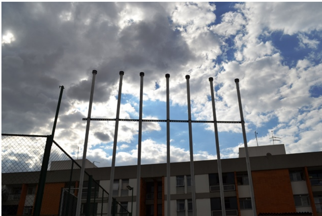
Figura 8 - Respiros com terminal corta chamas.
