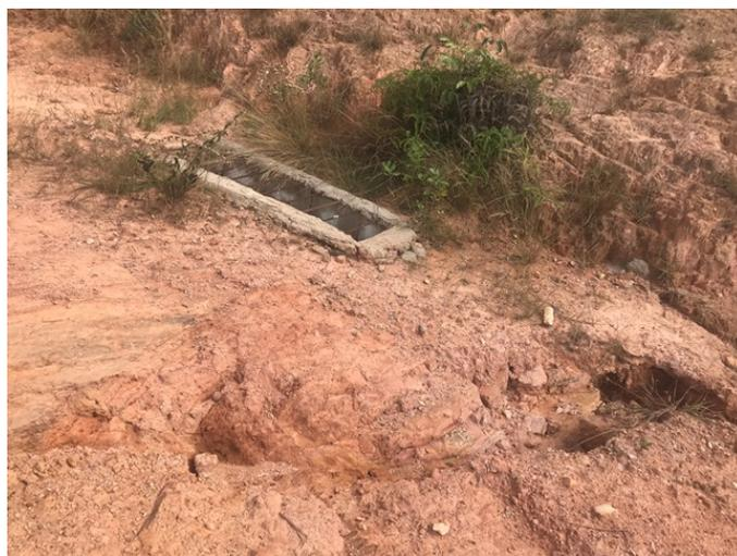
**Imagem 04- Área de Intervenção 02- Elementos de drenagem e formação de ravinas.**
