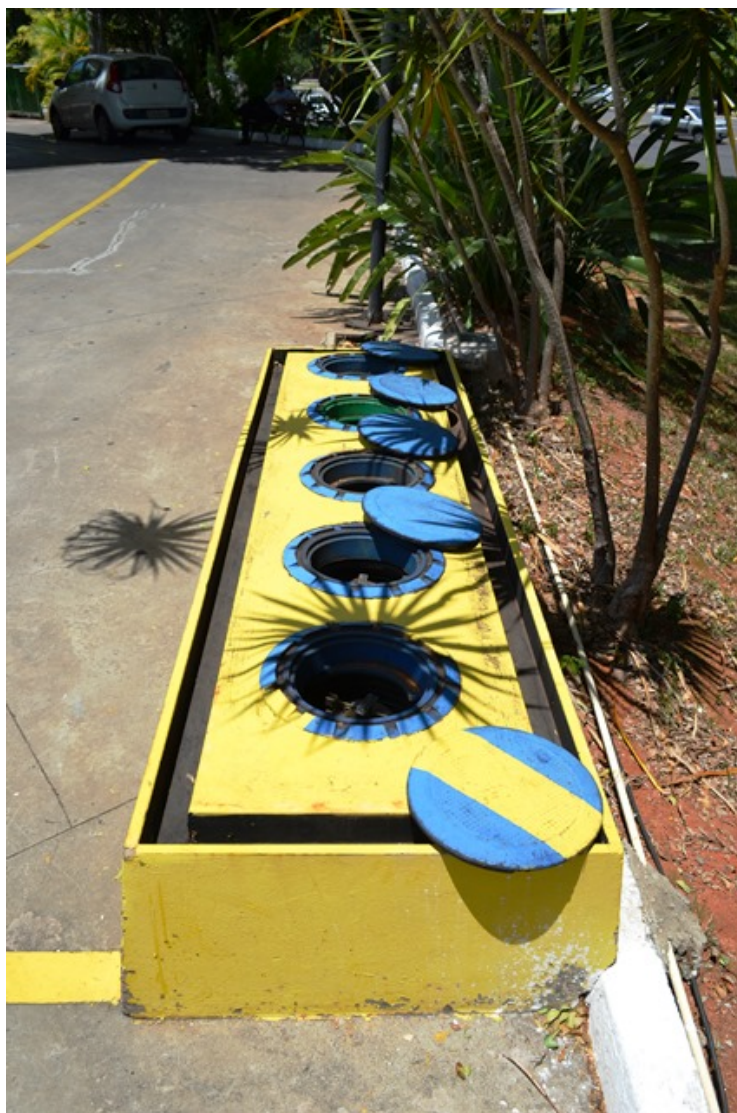
Figura 10 - Dispositivo de Descarga selada sobre o tanque com câmara de contenção ( Spill container ) sem válvula anti-transbordamento. Observa-se manutenção operacional constante conforme exige a tabela 1 da ABNT NBR 15594-3:2008.
