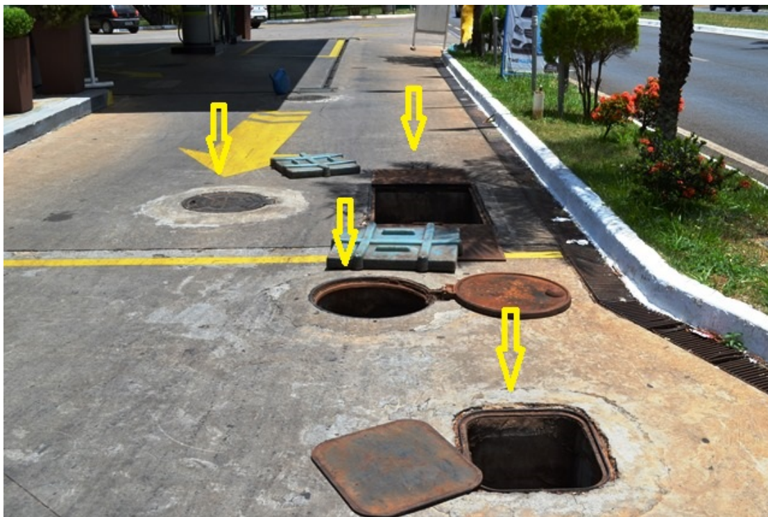
Figura 18 - Aspecto geral do Separador de Água e Óleo da pista de Abastecimento. O sistema possui Caixa de areia, Caixa separadora de água de óleo, caixa coletora de óleo e caixa de amostragem de efluentes.
