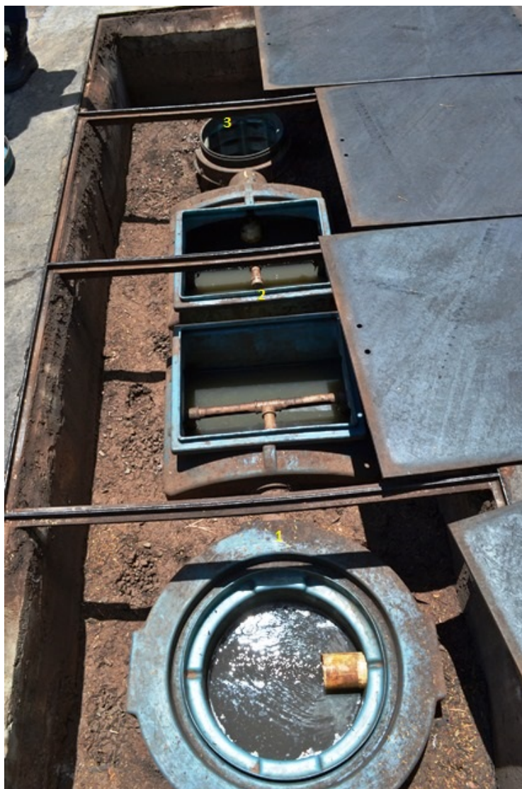
Figura 18 - Aspecto geral do Separador de Água e Óleo da pista de Abastecimento. O sistema possui Caixa de areia, Caixa separadora de água de óleo, caixa coletora de óleo e caixa de amostragem de efluentes.
