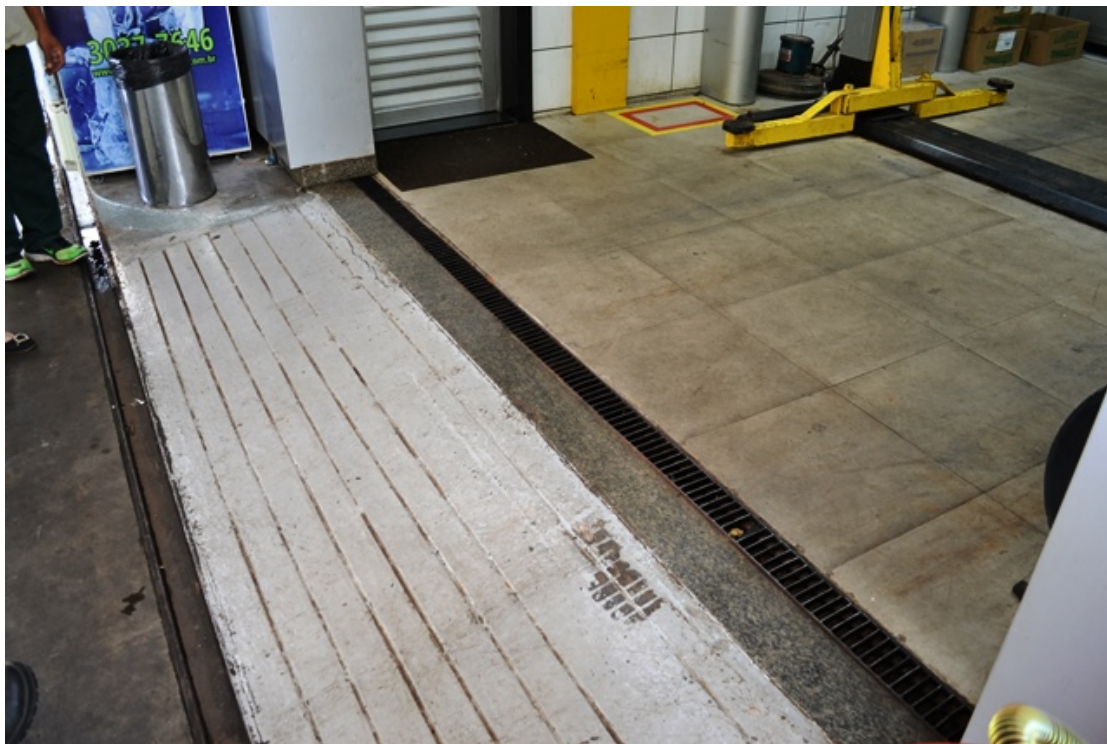
Figura 15 - Aspecto dos canaletes da parte frontal da área de lubrificação e manutenção de veículos.
