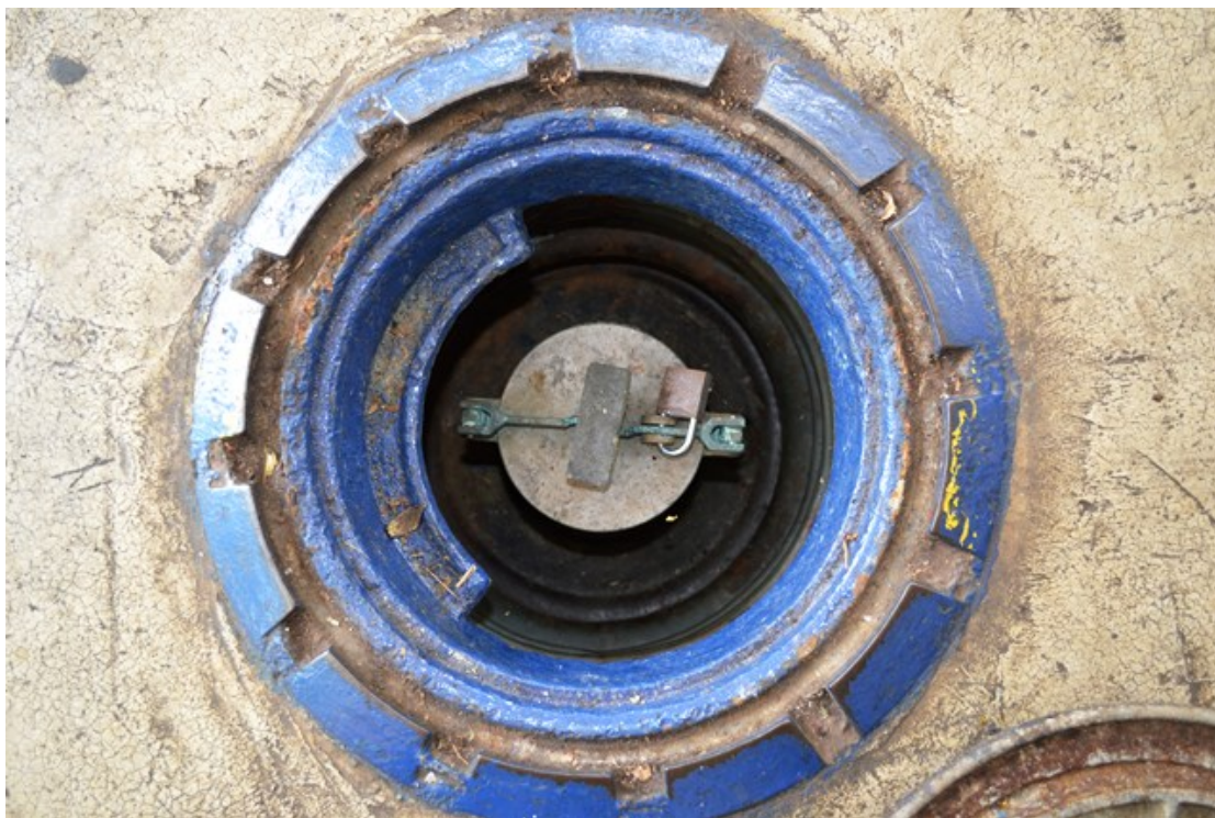
Figura 10 - Dispositivo de Descarga selada sobre o tanque com câmara de contenção ( Spill container ) sem válvula anti-transbordamento. Observa-se manutenção operacional constante conforme exige a tabela 1 da ABNT NBR 15594-3:2008.
