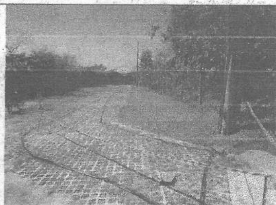
Figura 17 – Pavimentação com bloquetes permeáveis
