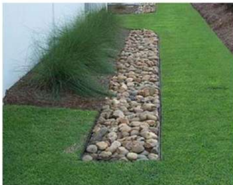
(a) Trincheira de infiltração
