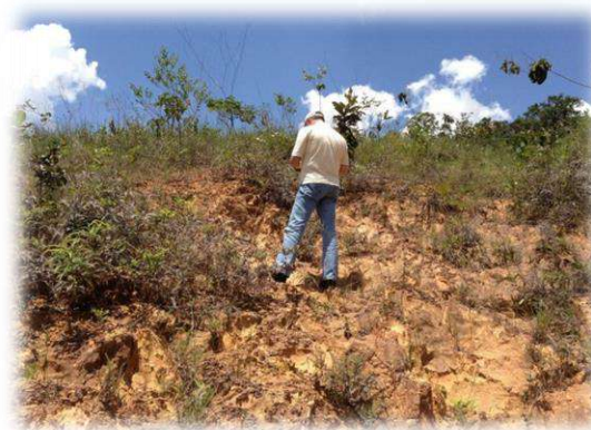
Talude com saprolito de Filito Canastra
