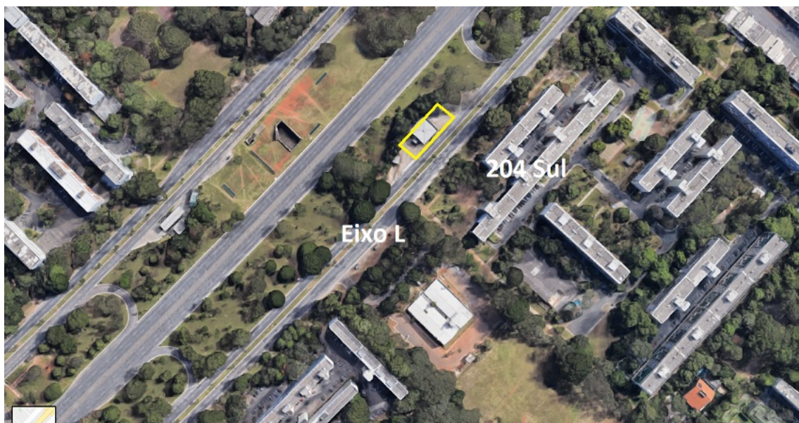
Figura 1 - Localização geral do post (polígono amarelo). Imagem: Google Maps, acessada em 27/9/2018.
