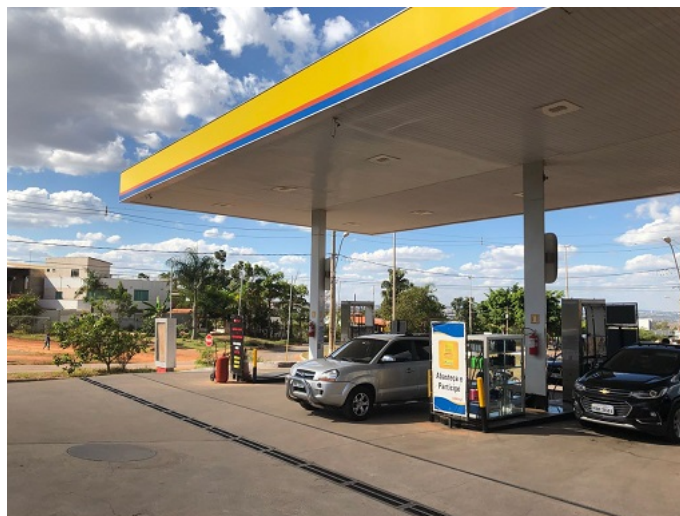
Figura 2 - Pista de Abastecimento
