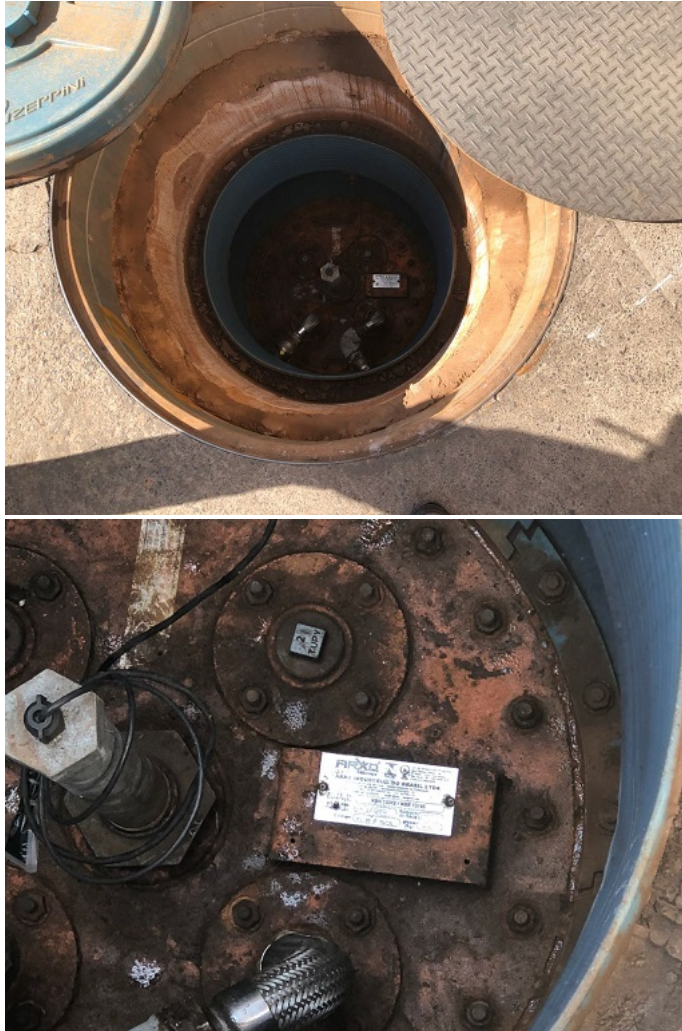
Figura 2 - boca de visita e tubulação do tanque.
