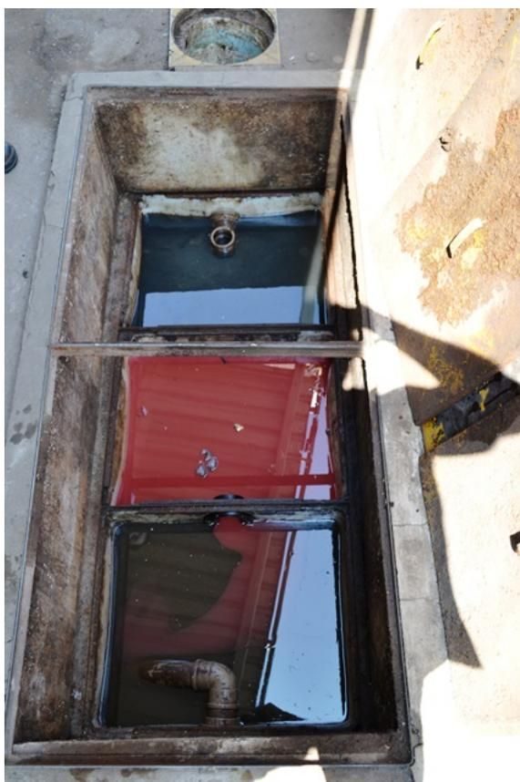
**Figura 20** - Aspecto geral do Separador de Água e Óleo da área do Lava Jato. Observa-se que o sistema necessita realizar manutenção operacional semanal conforme exige a tabela 1 da ABNT NBR 155943:2008.
