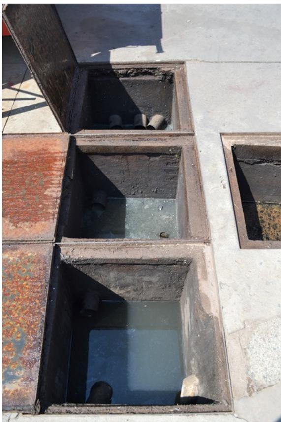
**Figura 19** - Aspecto geral do Separador de Água e Óleo da área do Lava Jato. O sistema possui Caixa de areia, Caixa separadora de água de óleo, caixa coletora de óleo e caixa de amostragem de efluentes da área do lava jato. Observa-se que o sistema necessita realizar manutenção operacional semanal conforme exige a tabela 1 da ABNT NBR 155943:2008.
