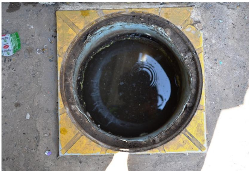
**Figura 21** - Aspecto da caixa de areia do Separador de Água e Óleo da área do lava jato. Observa-se a necessidade de adequação conforme exige a ABNT NBR 14605-2:2009.
