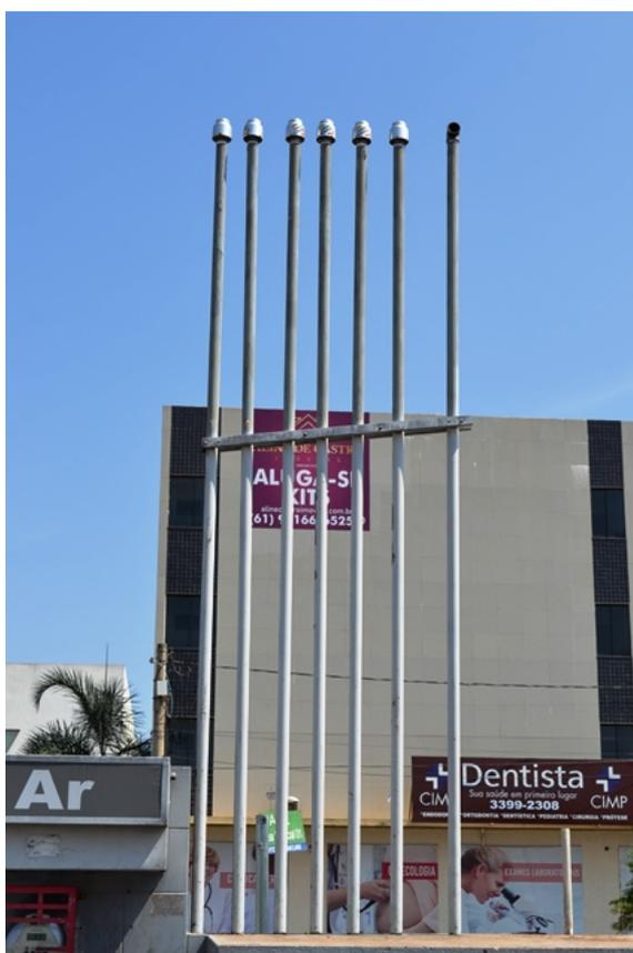
**Figura 9** - Respiros com terminal corta chamas. Observa-se que um dos 7 (sete) respiros não possui corta-chamas e apresenta-se com terminal cotovelo oriundo do tanque Subterrâneo de Armazenamento de Óleo Usado e Contaminado - OLUC.
