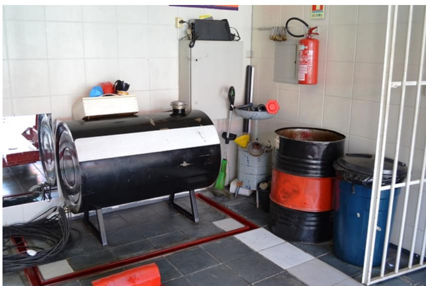
**Figura 16** - Aspecto do tanque de OLUC e dos tambores utilizados para o acondicionamento dos resíduos perigosos classe I. Observa-se que além dos canaletos externos à área de lubrificação a mesma possui um canaleta interno específico para o tanque de OLUC.
