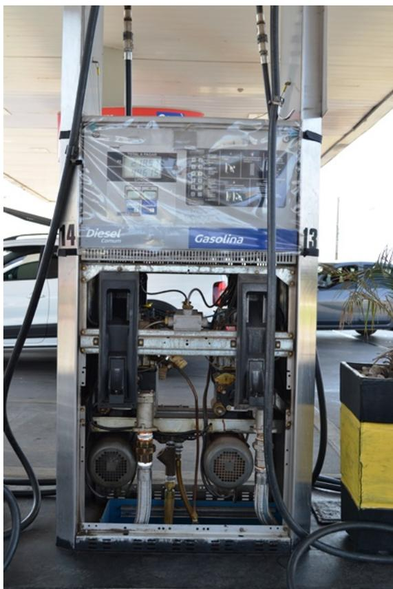
**Figura 3** - Unidade abastecedora de Gasolina Comum e Diesel Comum com o dispositivo de segurança *check-valve*, observa-se que a tubulação está limpa e totalmente contida na câmara de contenção para unidade da bomba. A unidade necessita de manutenção operacional diária conforme exige a tabela 1 da ABNT NBR 15594-3:2008
