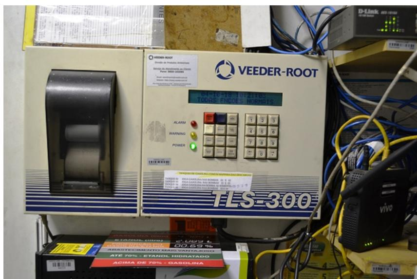
**Figura 15** - Sistema de medição e monitoramento ambiental Veeder-Root. O sistema está instalado e apresenta o *status* de operação dentro da normalidade conforme painel indicador com a luz verde.
