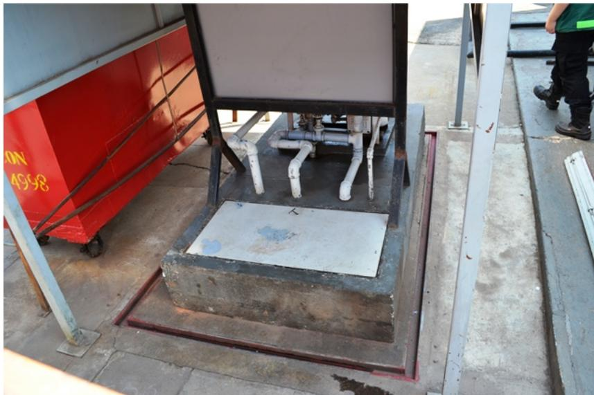
**Figura 6** - Aspecto do filtro desidratador de Diesel com *sump*. Observa-se que a unidade é coberta e circundada por canaletes de proteção.
