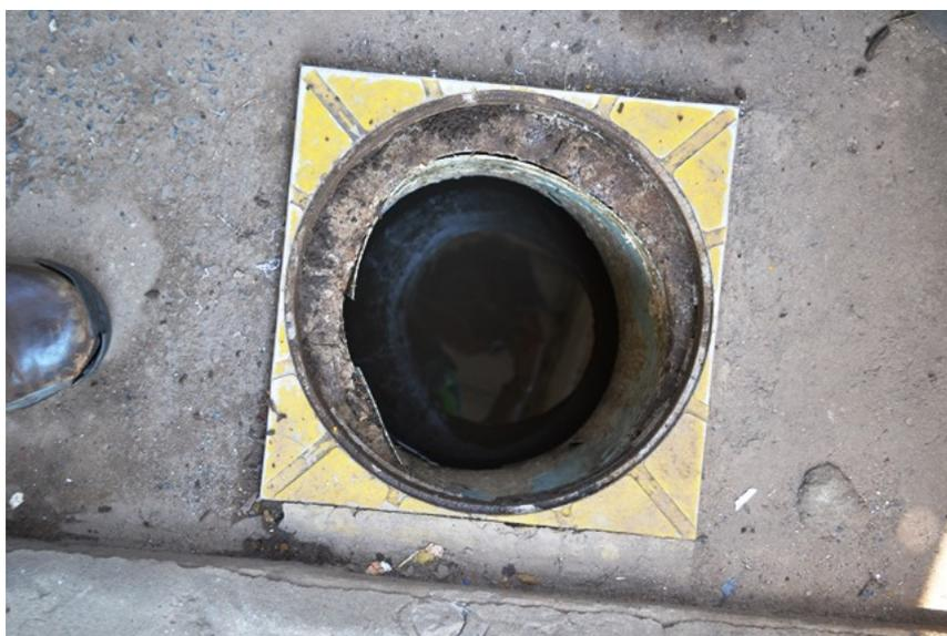
**Figura 22**- Aspecto da caixa de amostragem de efluentes do Separador de Água e Óleo da área do lava jato. Observa-se a necessidade de adequação conforme exige a ABNT NBR 14605-2:2009.
