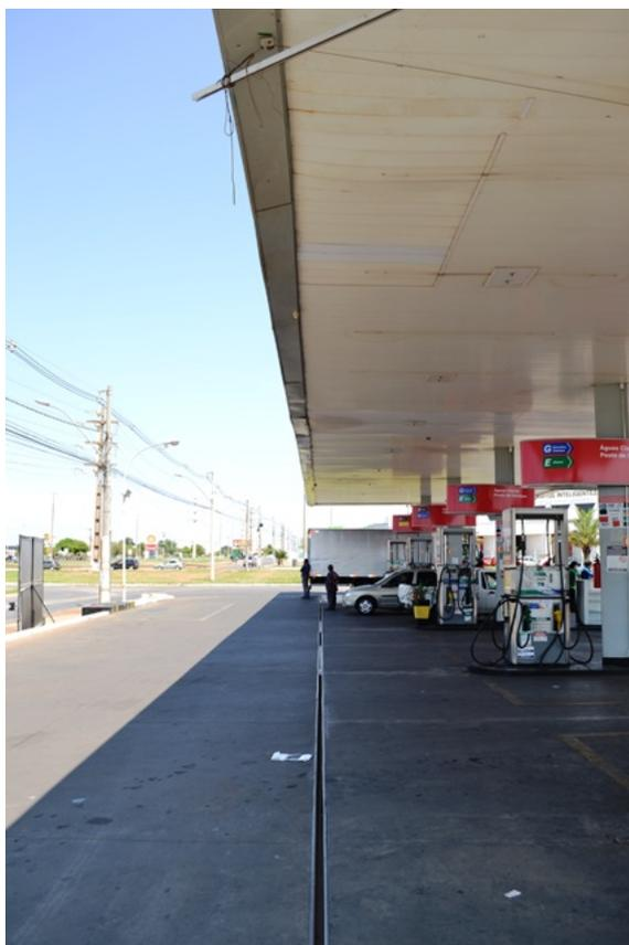
**Figura 8** - Canaletas Internas do Sistema de Drenagem Oleosa - SDO da pista de abastecimento com recuo interno de 0,5 metros conforme exige o item 4, da ABNT NBR 14.605-2:2010
