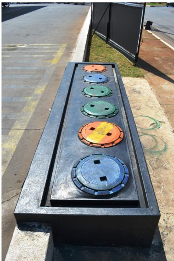
**Figura 12** - Descarga selada à Distância. Observa-se que o dispositivo é circundado por canaletas direcionados ao S.A.O. da pista de abastecimento.
