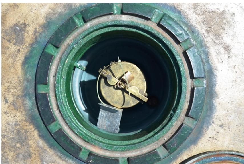
**Figura 11** - Dispositivo de Descarga selada sobre o tanque com câmara de contenção (*Spill container*) e válvula anti-transbordamento. Observa-se a necessidade de manutenção operacional constante conforme exige a tabela 1 da ABNT NBR 15594-3:2008.
