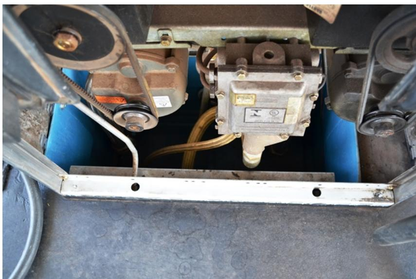
**Figura 4** - Aspecto externo da Câmara de contenção de uma das Unidades Abastecedoras do SASC. Observa-se que a tubulação está totalmente contida no *sump* da câmara de contenção do dispositivo de segurança. Os *sumps* das demais unidades necessitam de manutenção operacional diária conforme exige a tabela 1 da ABNT NBR 15594-3:2008.
