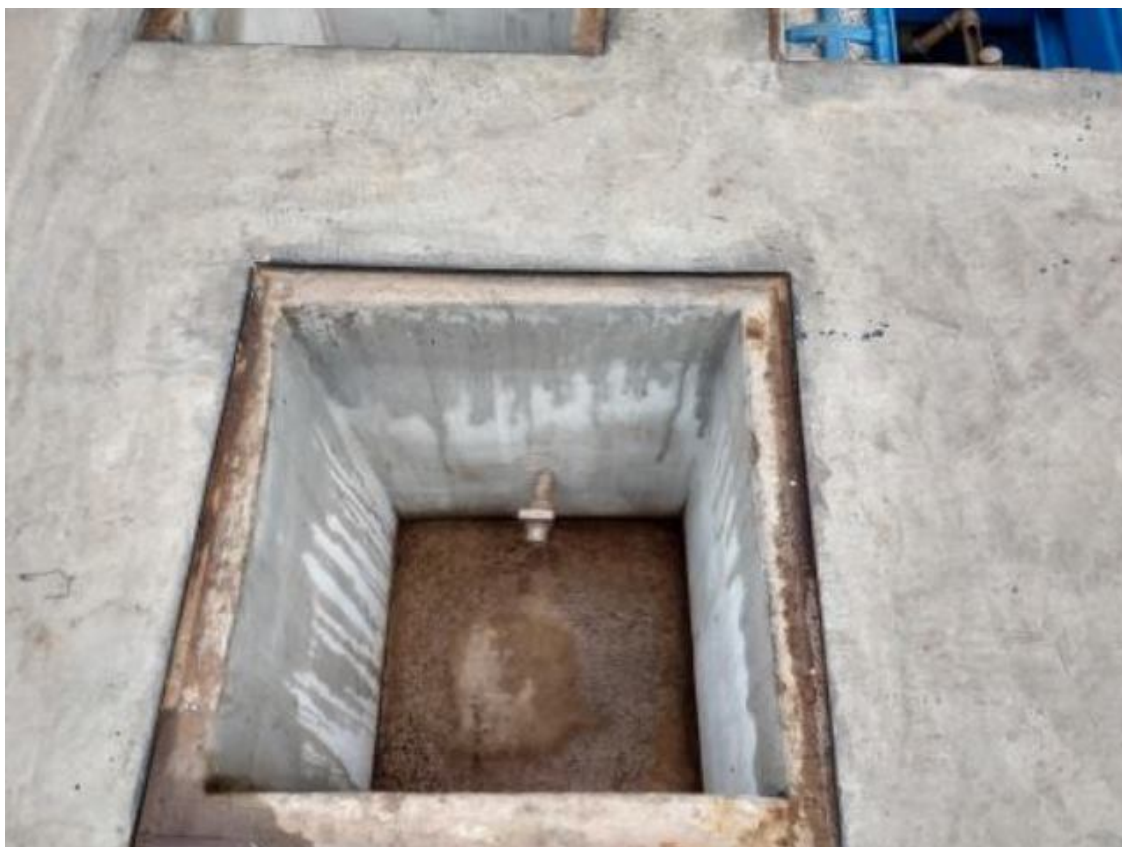
Figura 17 - Caixa coletora de óleo, em alvenaria.
