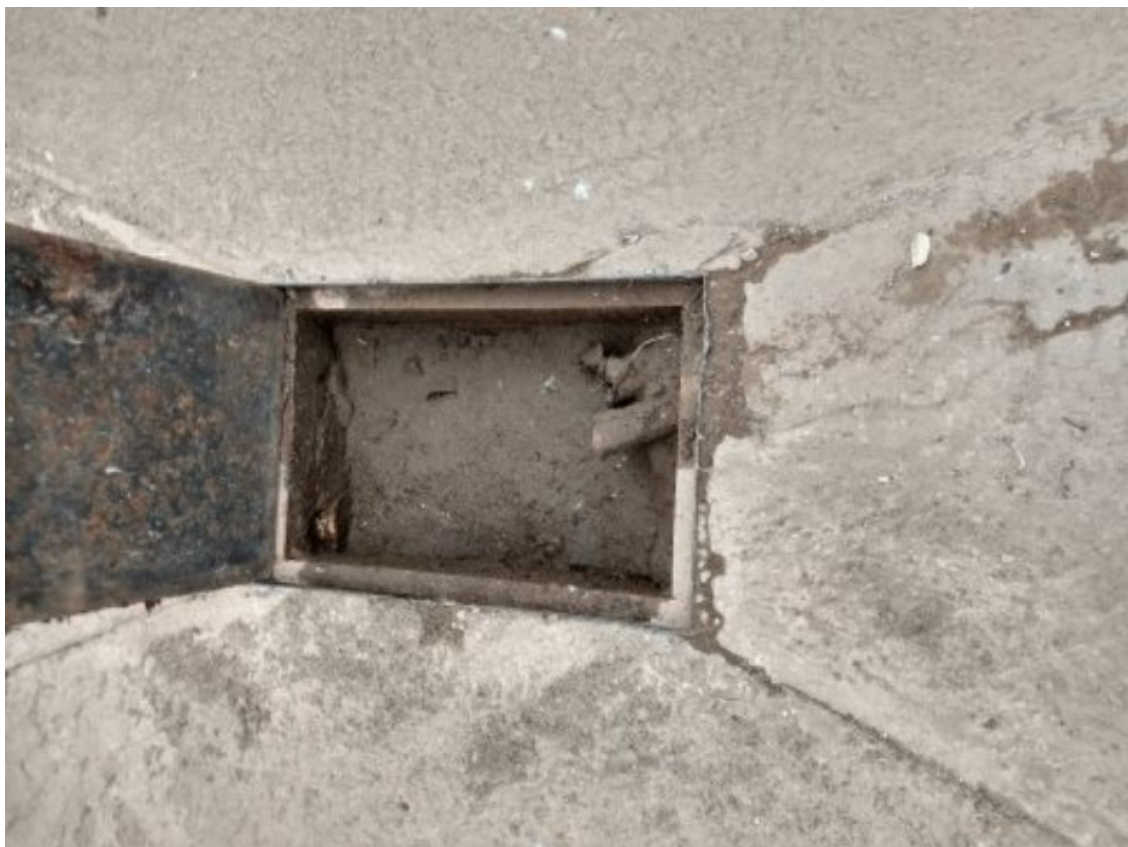
Figura 22 - Caixa de areia central da antiga área de lavagem de veículos.
