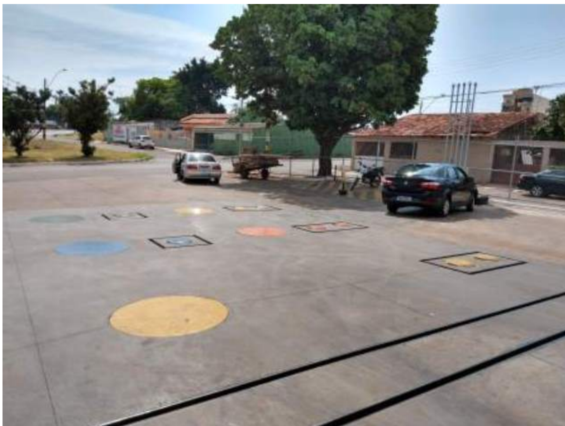
Figura 03 - Área de tancagem, observa-se as descargas seladas sobre o tanque circundadas por canaletas destinadas ao sistema separador.
