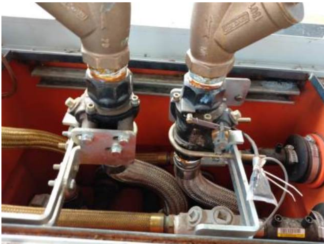
Figura 07 - Válvula de segurança contra abalroamento.
