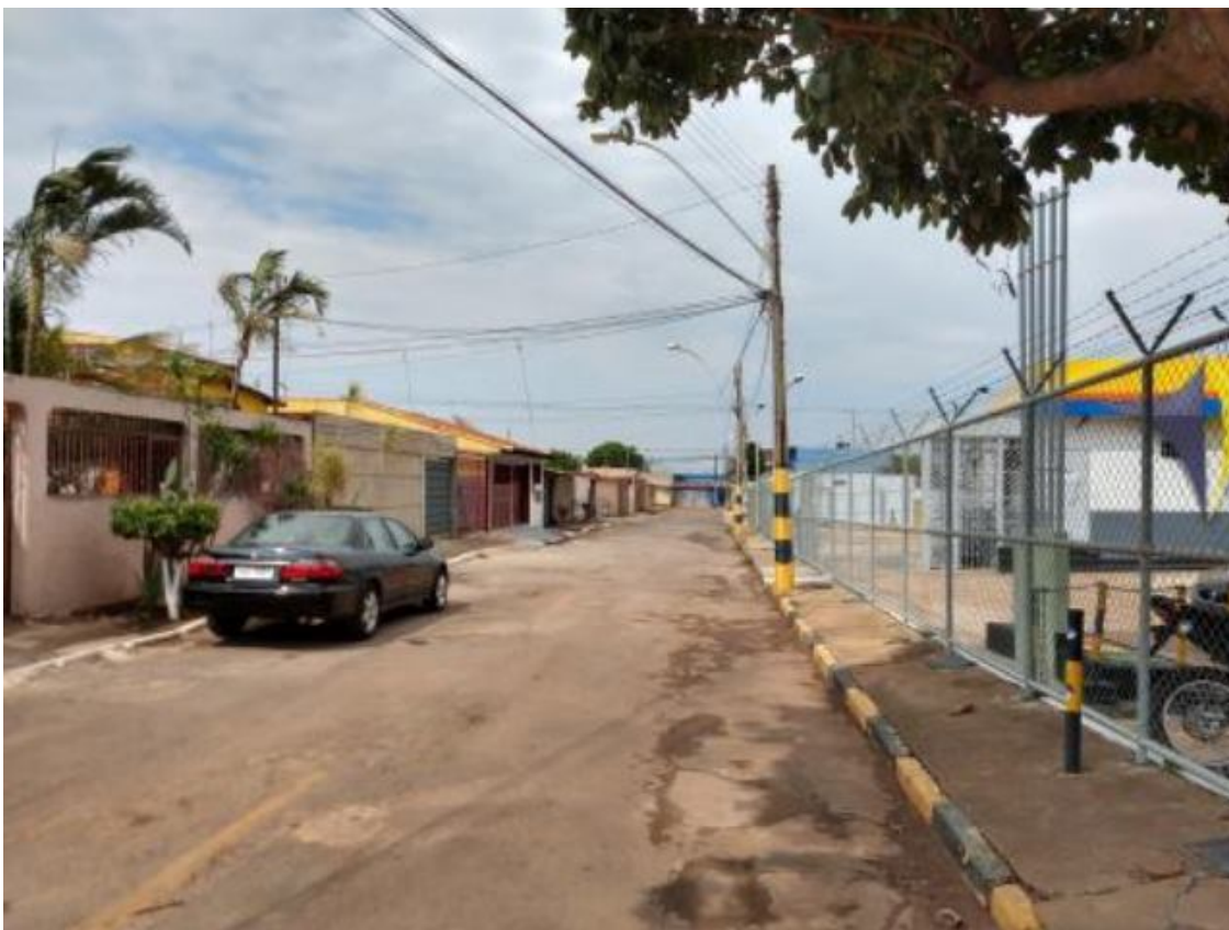
Figura 14 - Visão da parte traseira do empreendimento, observa-se os respiros dentro do limite do terreno.
