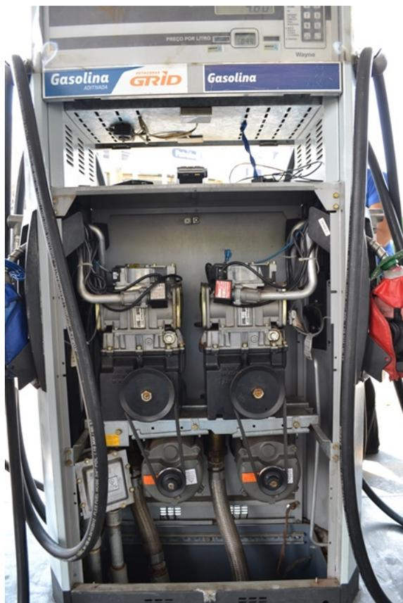
Foto 13- Unidade de abastecimento com câmara de contenção (sump de bomba).
