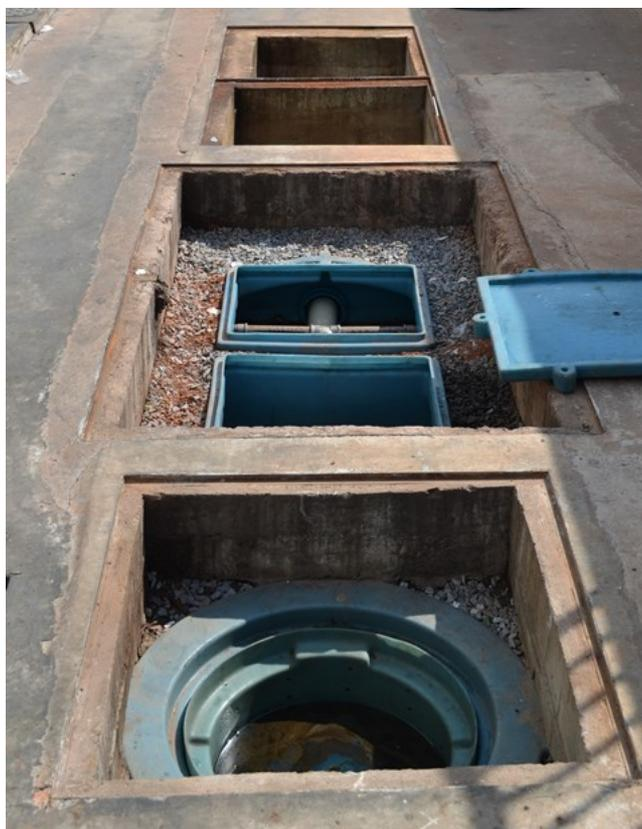
Foto 22- Visão geral do Sistema Separador de Água e Óleo (SAO).
