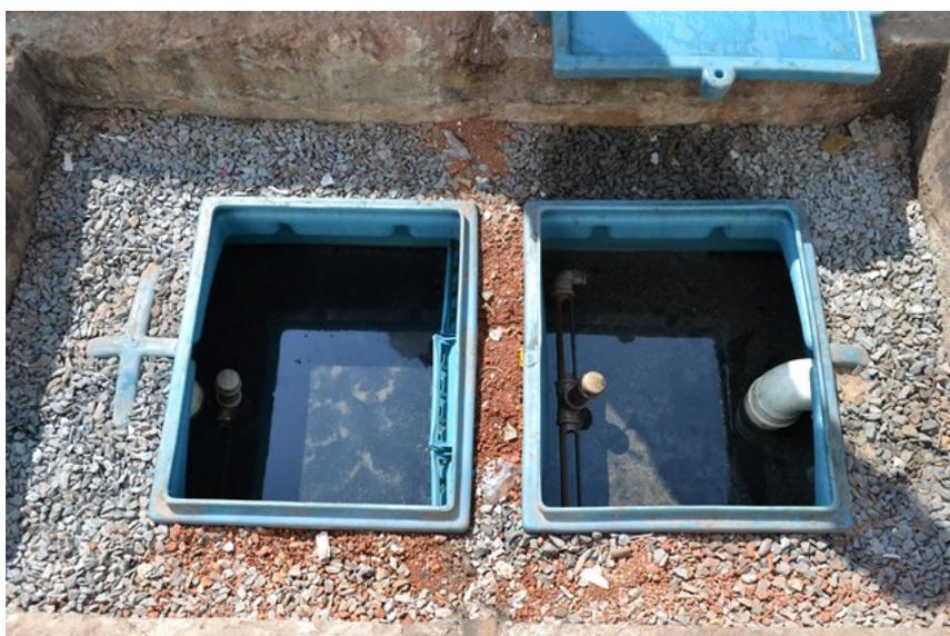
Foto 24 - Separador de Água e Óleo pré-moldado.
