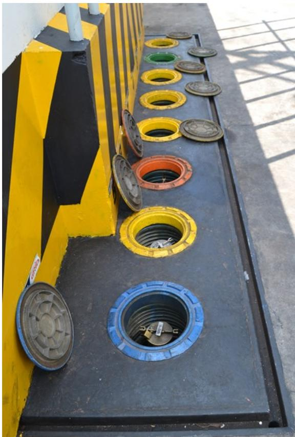
Foto 09- Câmaras de contenção das descargas seladas a distância (*spill container*), não apresentam sinais de oxidação e estão com manutenção adequada.
