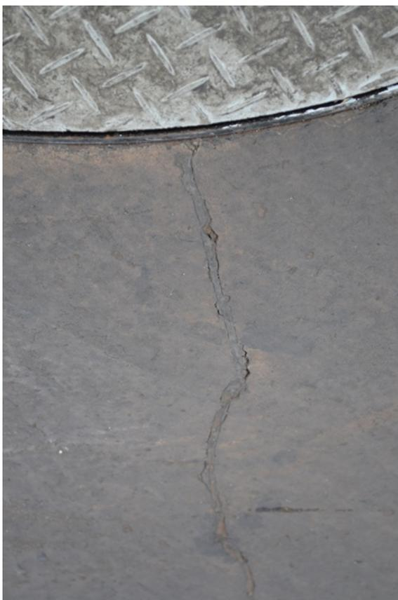
Foto 03 - Fissuras na pista de abastecimento
