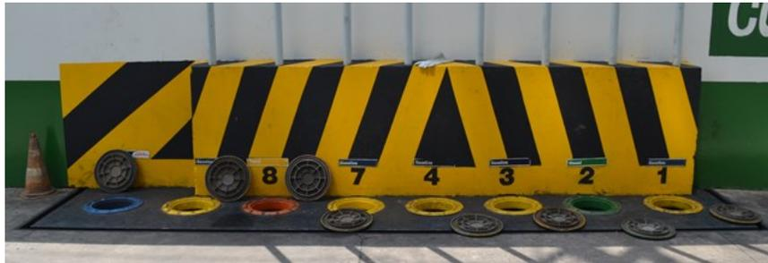
Foto 08- Descarga selada a distância com canaletas e piso impermeabilizado.
