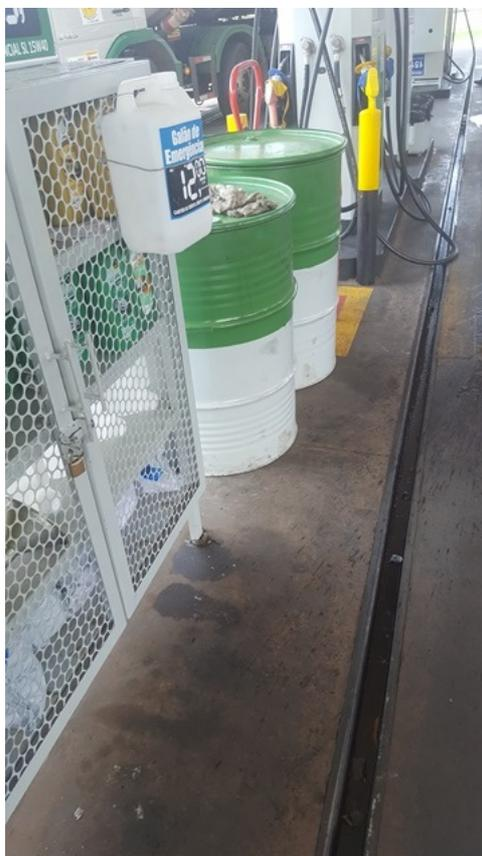
Foto 12 - Canaletes da pista de abastecimento. Observa-se a necessidade de manutenção operacional constante conforme exige a tabela 1 da ABNT NBR 15559-3:2008.
