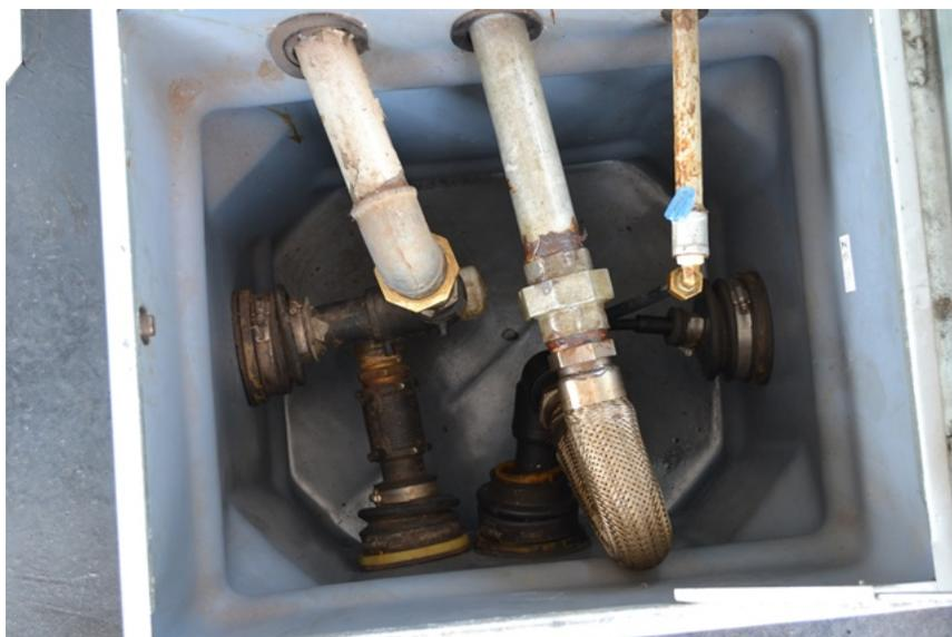
Foto 15 - Câmara de Contenção do Filtro de óleo Diesel.
