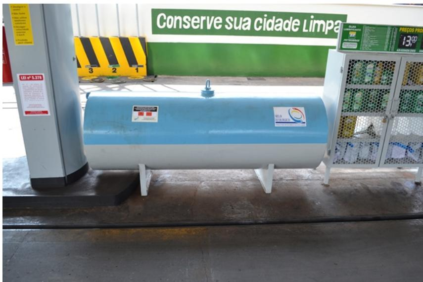
Foto 16-Tanque de armazenamento de óleo Usado ou Contaminado - OLU dentro da área apropriada.
