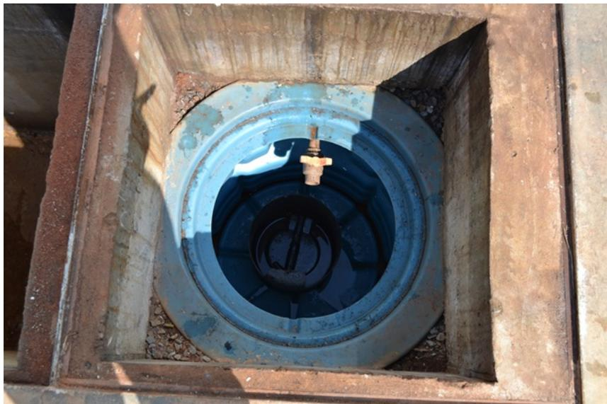
Foto 26 - Caixa coletora de óleo pré-moldada.
