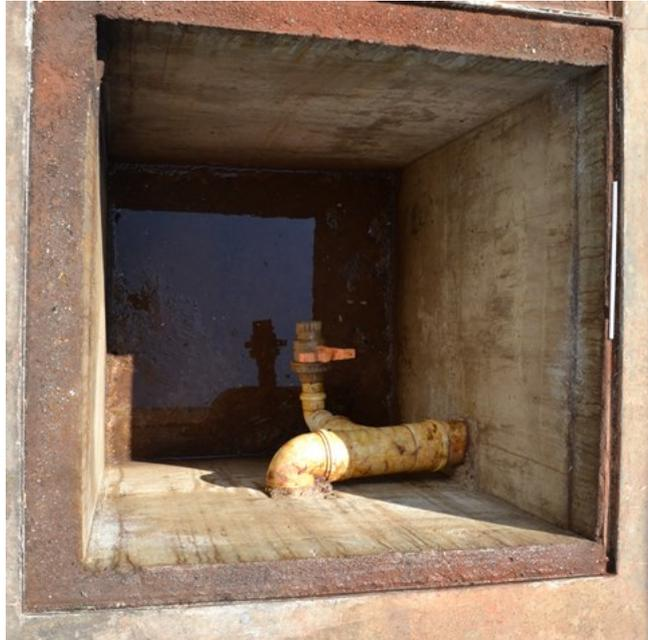
Foto 25 - Caixa de amostragem de efluente em concreto;
