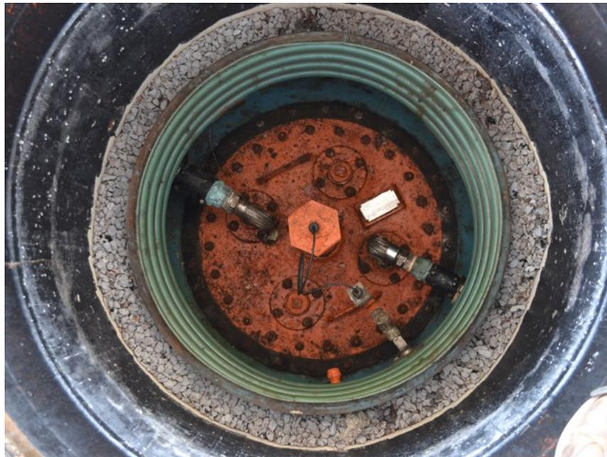
Foto 07- Aspecto da Câmara de contenção (*spill container*) da boca de visita de um dos 04 (quatro) SASC. Observa-se a corrosão na tampa do tanque necessitando de manutenção operacional constante conforme exige a tabela 1 da ABNT NBR 15594-3:2008.
