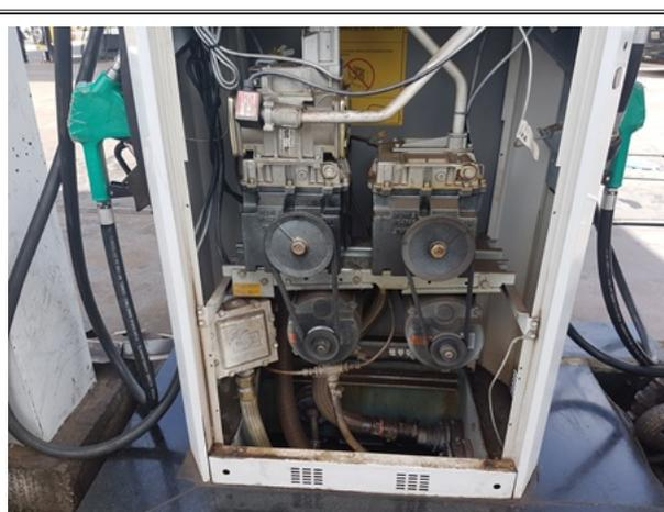
Foto 02 - Bomba de abastecimento com a câmara de contenção.
