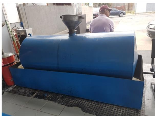
Foto 6 - Tanque de oluc em área impermeabilizada.
