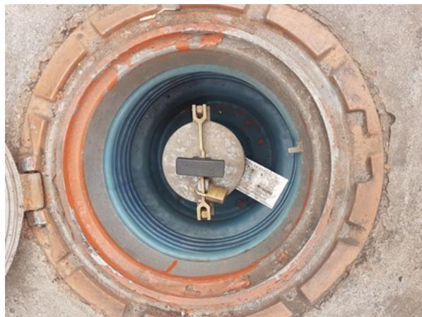
Foto 5 - Descarga selada com válvula antitransbordamento.
