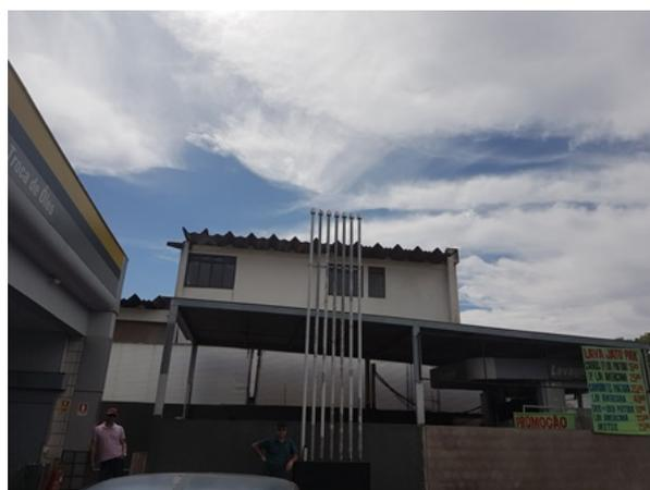
Foto 9 - Respiros referentes a cada compartimento dos tanques.
