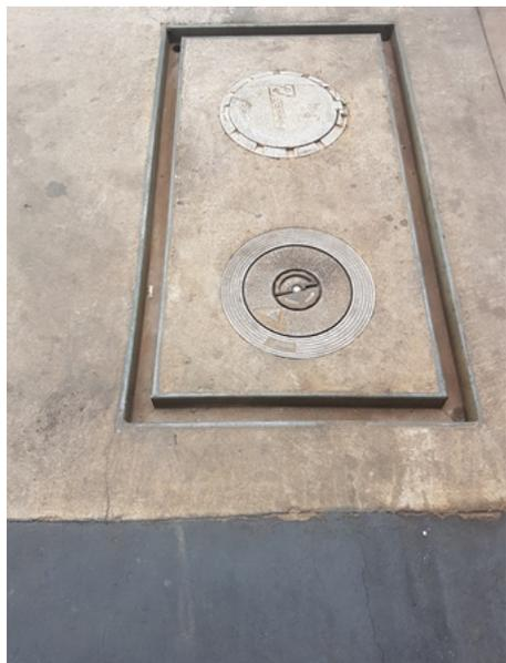
Foto 4 - Descarga sobre o tanque circundada por canaletes.
