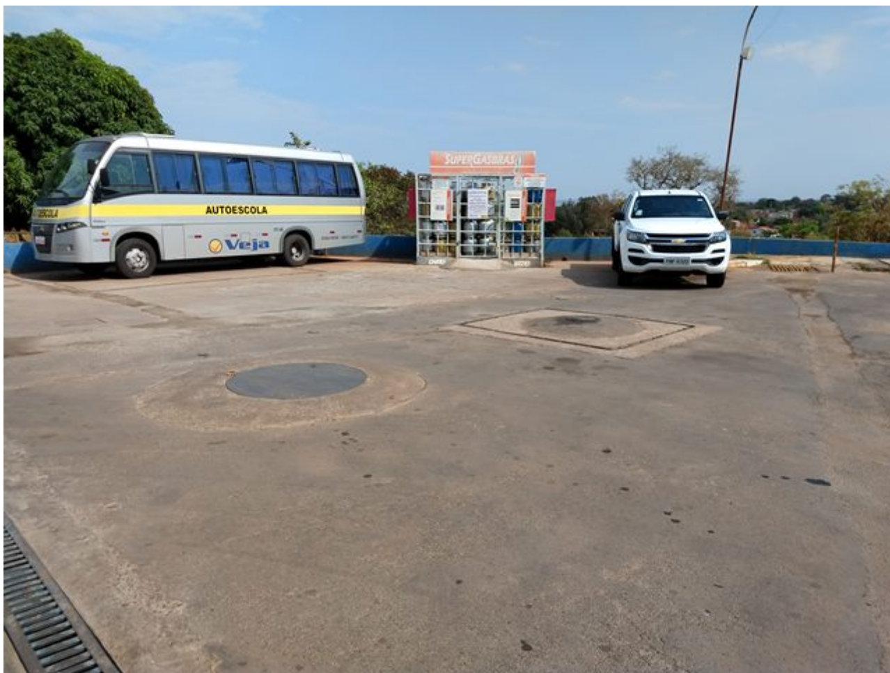
Figura 5- Área do tanque de diesel da pista de abastecimento 2. Pode-se observar que o interessado inseriu canaletes ao redor da descarga selada sobre o tanque e direcionou ao S.A.O. da pista de abastecimento, em atendimento a condicionante do IBRAM.
