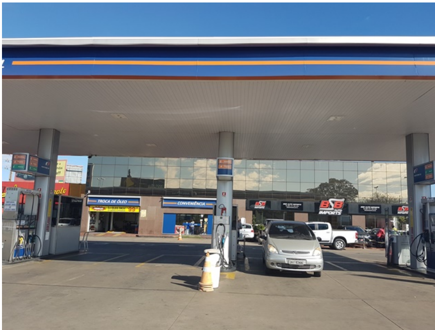
Foto 1. Visão geral do empreendimento.
