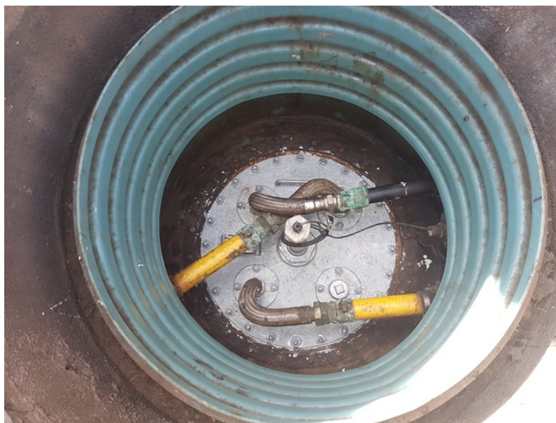
Foto 02. Boca de visita de um dos tanques.
