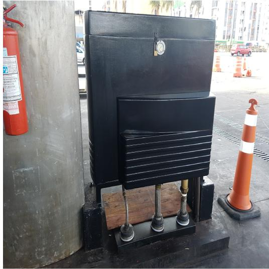
Foto 1 – Filtro de Diesel localizado na pista de abastecimento circundada por canaletas.
