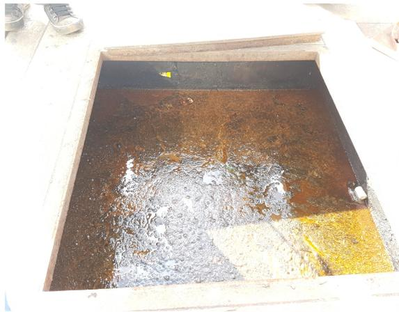
Foto 6 – Caixa Coletora de óleo do SAO da pista.
