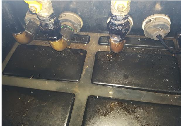
Foto 2 – Câmara de Contenção para Unidade de Filtragem localizada na pista de abastecimento.
