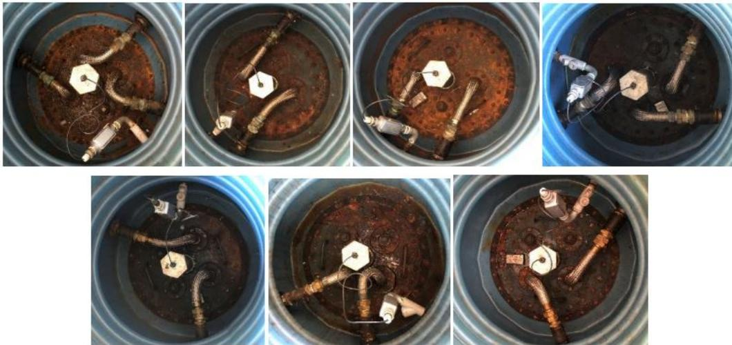
Foto 9 – Boca de Visita do Tanque evidenciando controle eletrônico de estoque, tubulação subterrânea de PEAD e ausência de água ou combustível em seu interior. Fonte: Plano de resposta a incidentes (9179728)
