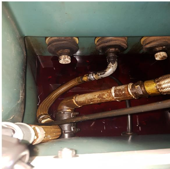
Foto 3 – Câmara de contenção sob a unidade de abastecimento de diesel localizada na pista de abastecimento
