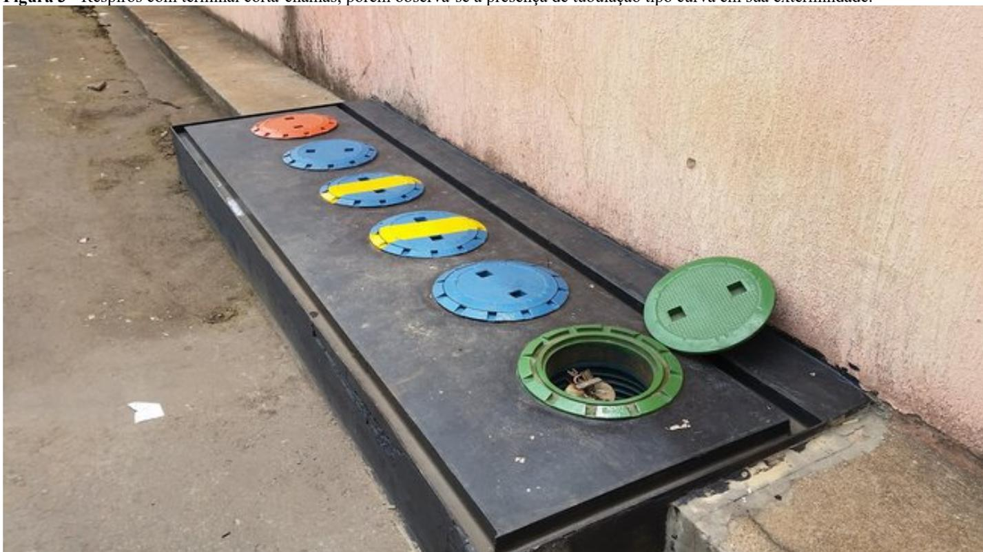
**Figura 4** - Descargas seladas a distância, em área circundada por canaletas direcionadas ao SAO.
