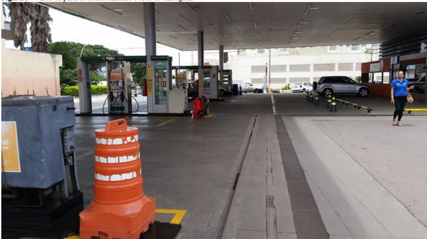
**Figura 6** - Pista de abastecimento, observa-se os canaletos do SDO (internos) e as grelhas, destinadas a drenagem pluvial.
