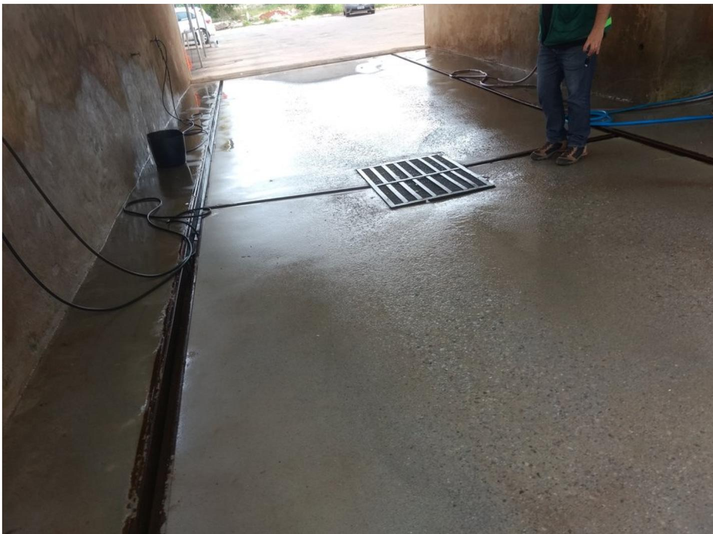
**Figura 9** - Área de lavagem de veículos, observa-se que é circundada por canaletas e caixa de areia central.
