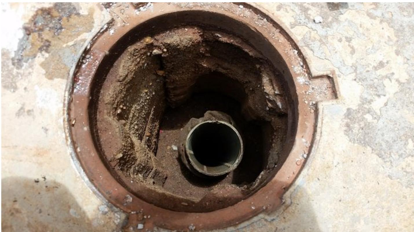
**Figura 15** - Descarga do tanque subterrâneo de OLUC, observa-se a ausência de câmara de contenção.
