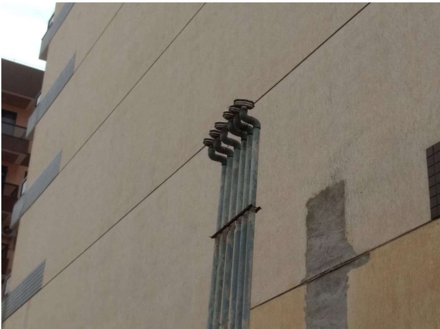
**Figura 3** - Respiros com terminal corta-chamas, porém observa-se a presença de tubulação tipo curva em sua extremidade.
