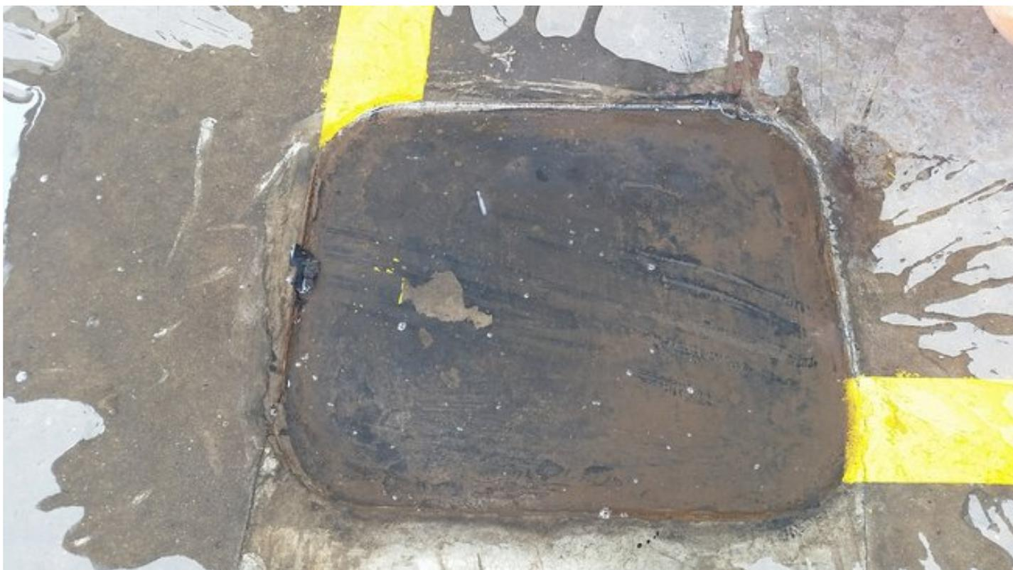
**Figura 17** - Antiga caixa de passagem na pista de abastecimento, observa-se a impermeabilização da mesma.
