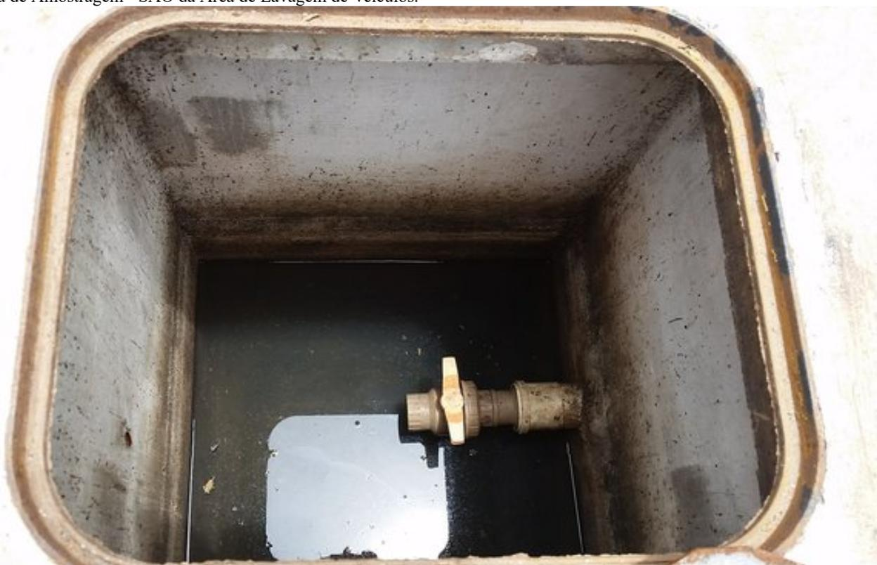
**Figura 14** - Caixa Coletora de Óleo - SAO da Área de Lavagem de Veículos.
