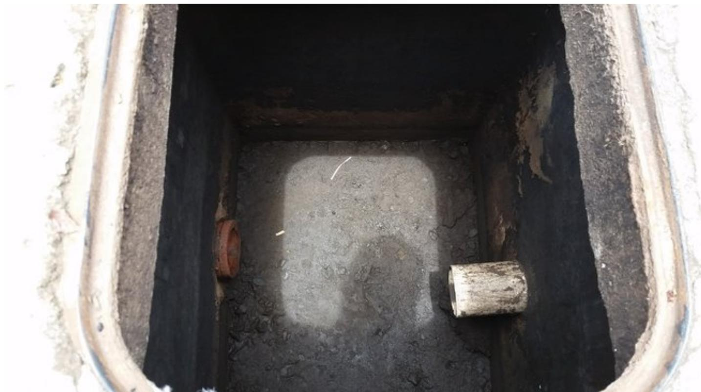
**Figura 13** - Caixa de Amostragem - SAO da Área de Lavagem de Veículos.
