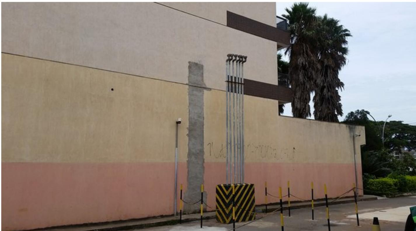
**Figura 2** - Respiros dos tanques subterrâneos, observa-se a marca do antigo local na parede da edificação adjacente ao empreendimento.
