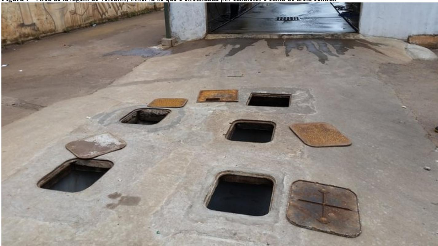
**Figura 10** - Sistema Separador Água/Óleo da área de lavagem de veículos.
