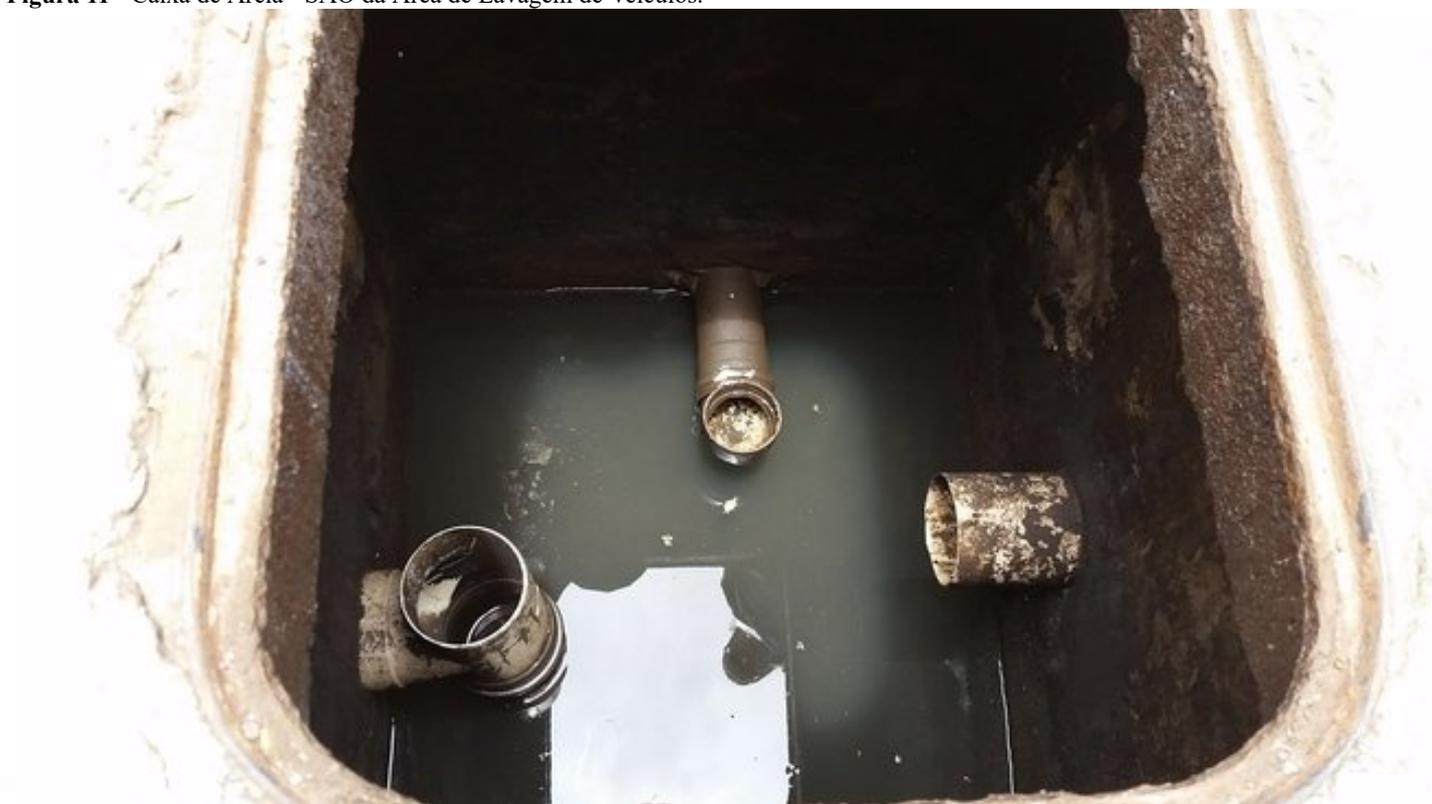
**Figura 12** - Caixa Separadora - SAO da Área de Lavagem de Veículos.
