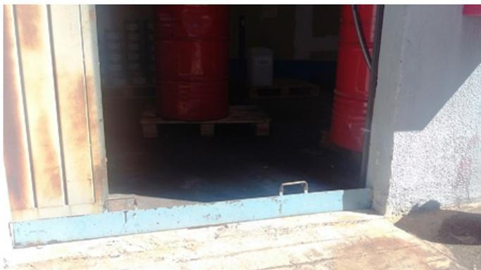
Foto 19 - Dispositivo removível para contenção de líquidos (entrada do depósito de produtos químicos não-inflamáveis)
