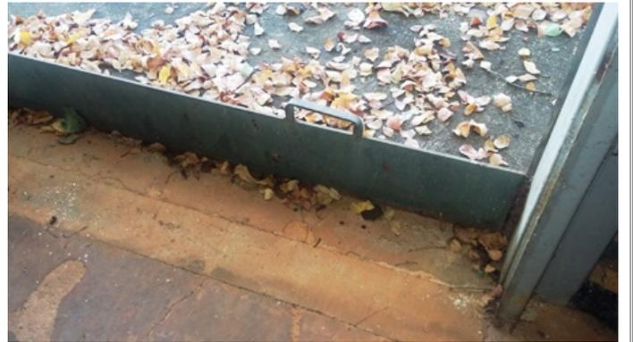
Foto 18 - Dispositivo removível para contenção de líquidos (entrada do depósito de produtos químicos inflamáveis).
