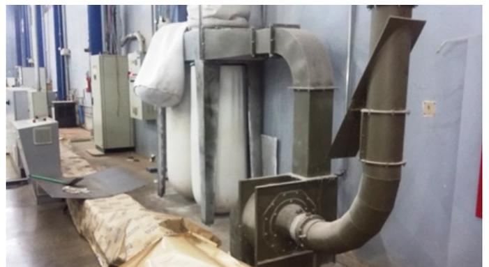
Foto 14 - Sistema de captação de pó de serragem de papel.
