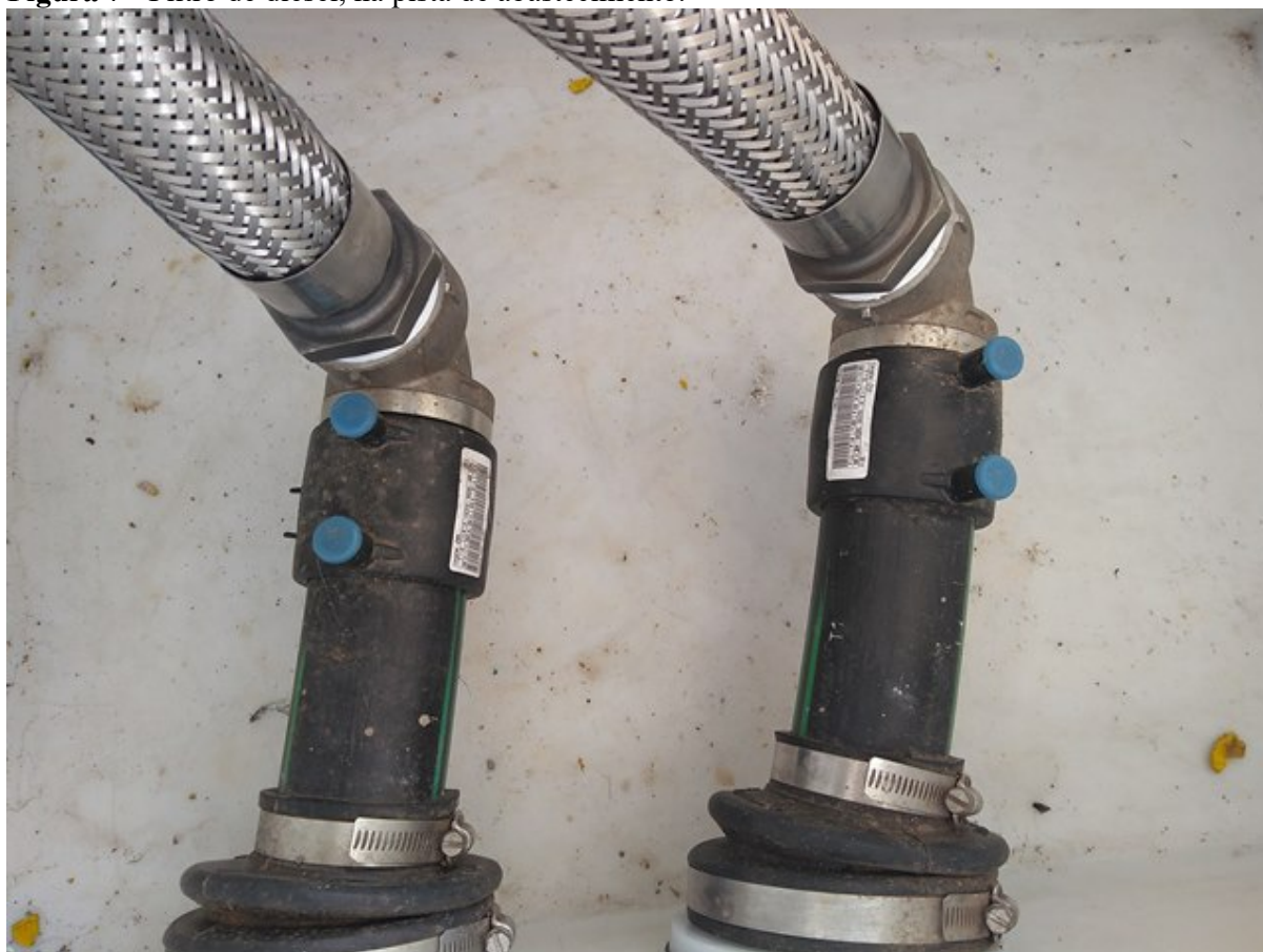
Figura 8 - Câmara de contenção do filtro de diesel.
