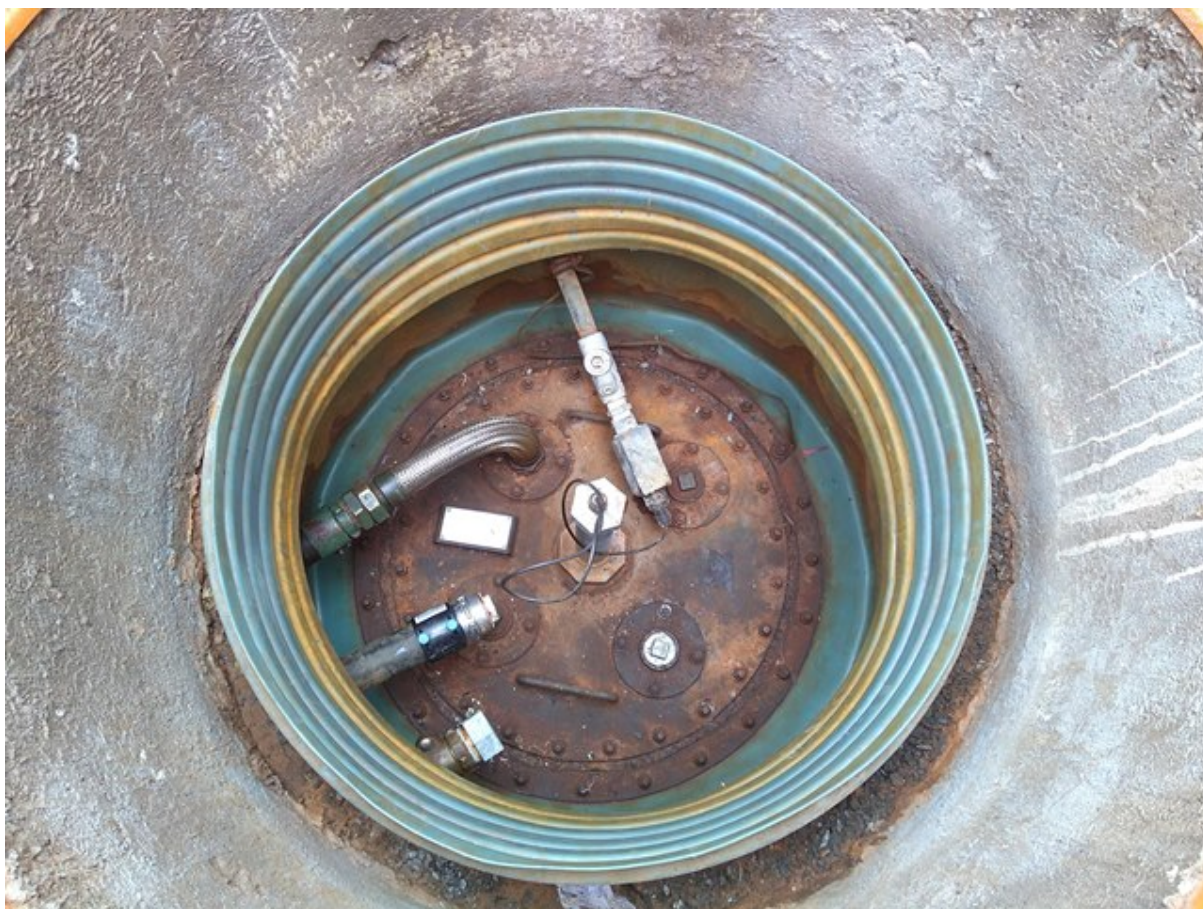
Figura 5 - Interior da câmara de acesso a boca de visita do tanque subterrâneo.
