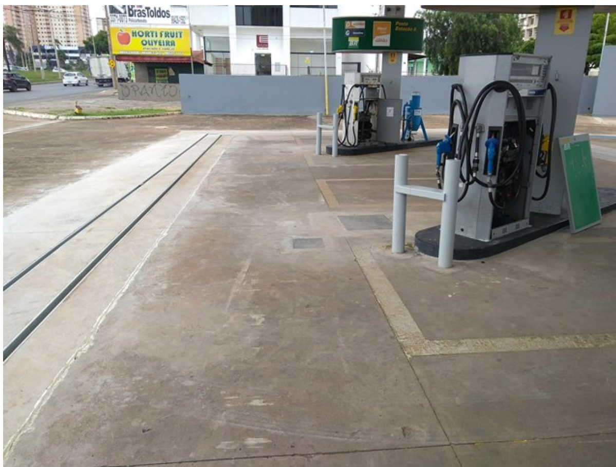
Figura 9 - Pista de abastecimento com antigas aberturas tamponadas com cimento/concreto.
