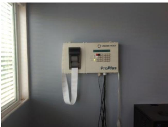
**Figura 04** – Vista do sistema de controle eletrônico de estoque e vazamento de combustível ( Marca Vedder Root)
