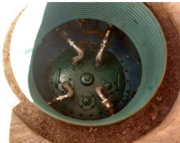
**Figura 02** – Vista da Boca de Visita do tanque de combustível. Não há instalação do monitoramento de controle de estoque
