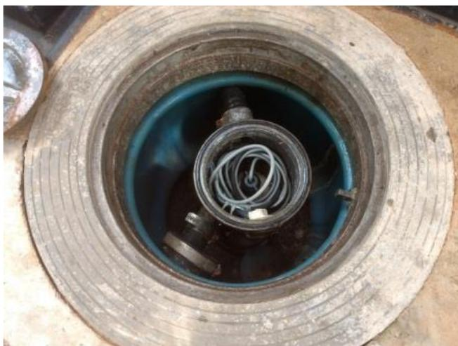
**Figura 03** - Vista da câmara de acesso do monitoramento intersticial. Nota que o monitoramento encontra-se instalado
