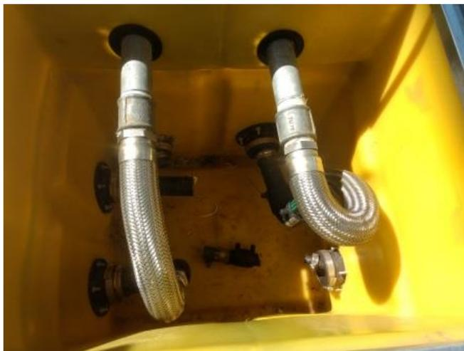
**Figura 06** – Vista da tubulação do sistema de abastecimento de diesel. Nota-se a presença de linhas abertas e sem conexões, que deverão ser isoladas.
