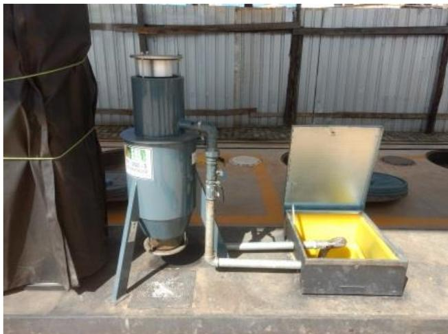
**Figura 07** – Vista do sistema de abastecimento de diesel, tubulações, linhas, filtro e câmara de contenção.
