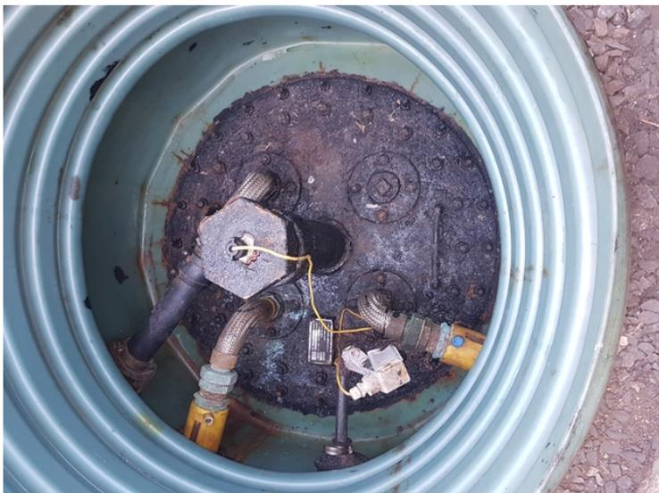
Foto 1. Câmara de contenção de um dos tanques que serão retirados.
