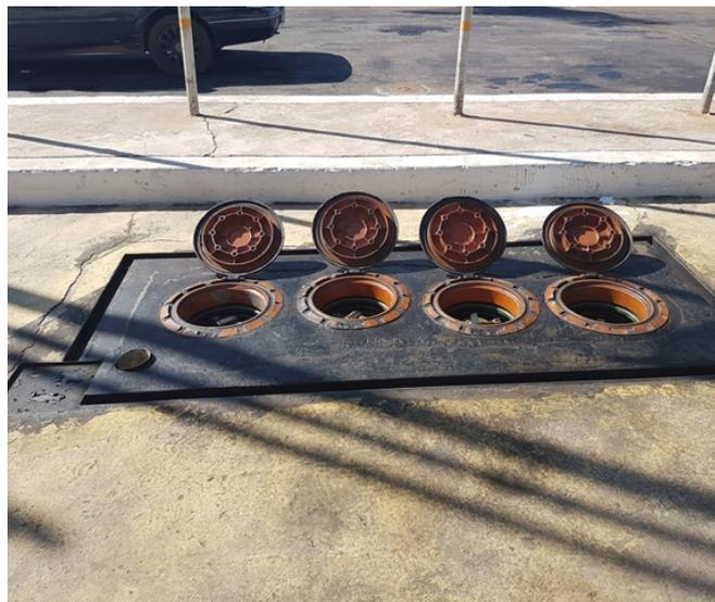
Foto 4. Visão geral da descarga selada à distância.
