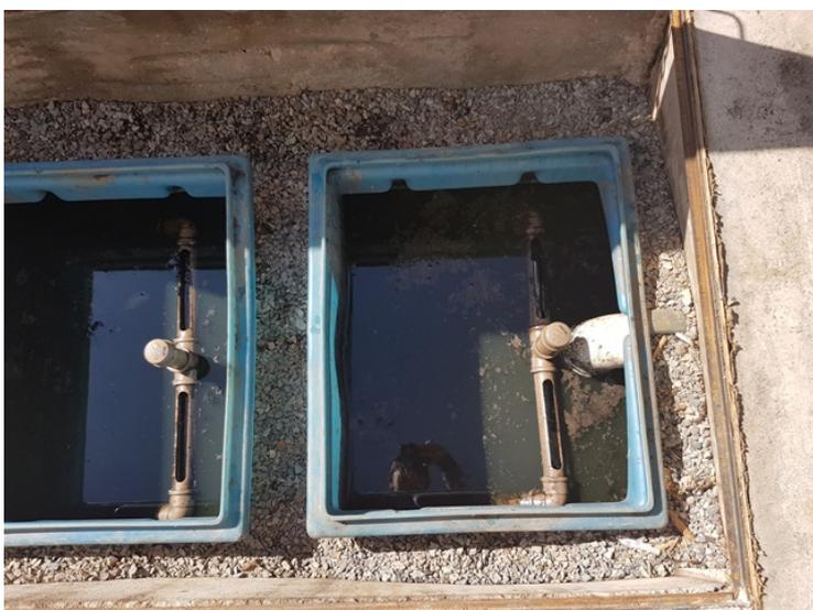
Foto 17. Caixa separadora de óleo do SAO da pista de abastecimento.
