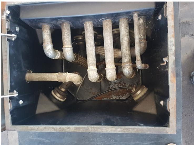
Foto 13. Câmara de contenção do filtro de diesel.
