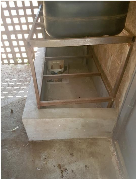
Foto 19. Bacia de contenção do tanque de diesel do gerador.
