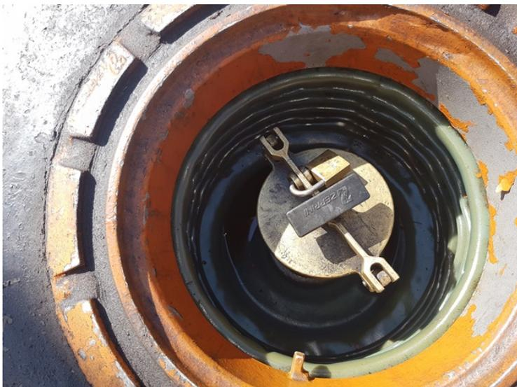
Foto 5. Detalhe da descarga selada à distância.
