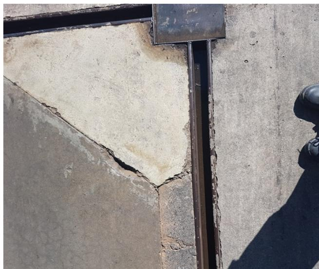
Foto 10. Detalhe da fissura na pista de abastecimento, próximo aos canos
