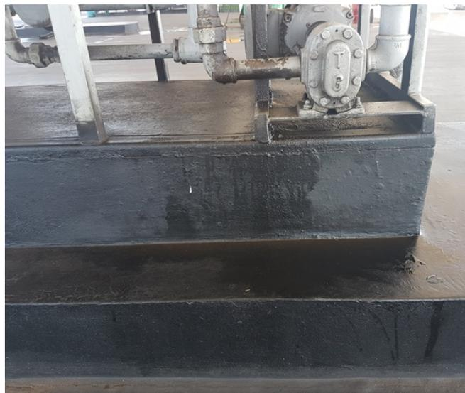
Foto 12. Detalhe do filtro de diesel com indícios de vazamentos.
