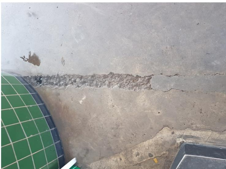
Foto 9. Fissura na pista de abastecimento.
