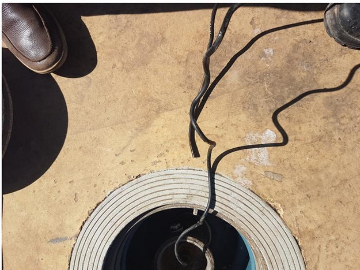
Foto 3. Detalhe do monitoramento intersticial não instalado.
