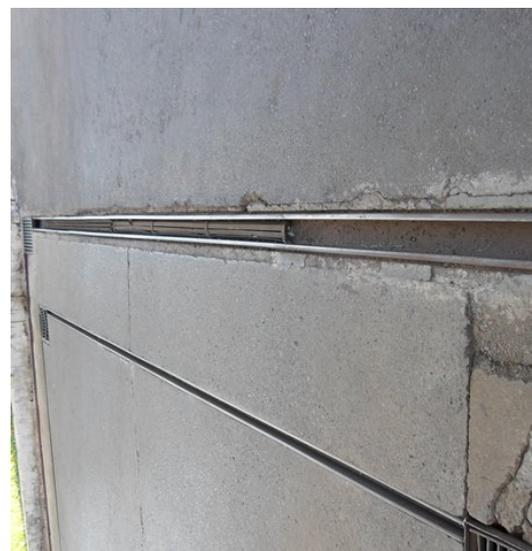
Foto 3. Canaleta danificado, sem a devida manutenção.
