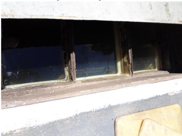
Foto 23. Caixa de separadora de água e óleo da pista de abastecimento.
