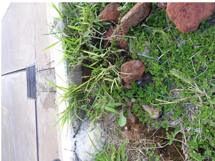
Foto 4. Detalhe do "ladrão" ligando o canal de drenagem ao canteiro de plantas.
