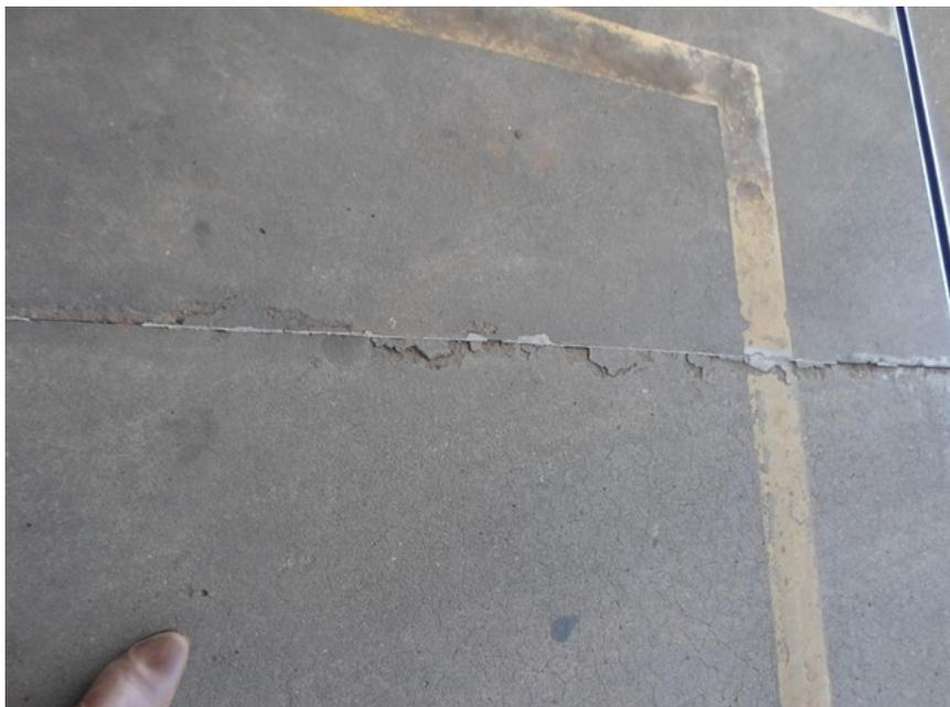
Foto 2. Rachadura na pista de abastecimento.
