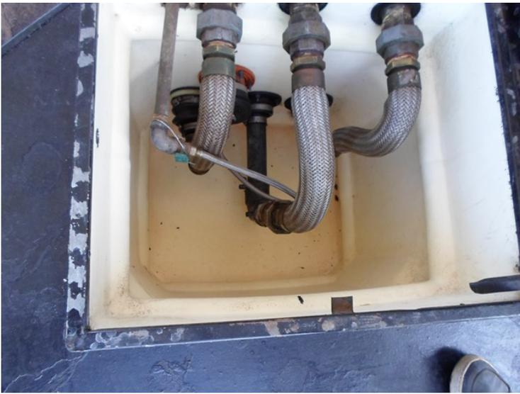
Foto 8. Câmara de contenção do filtro de diesel.
