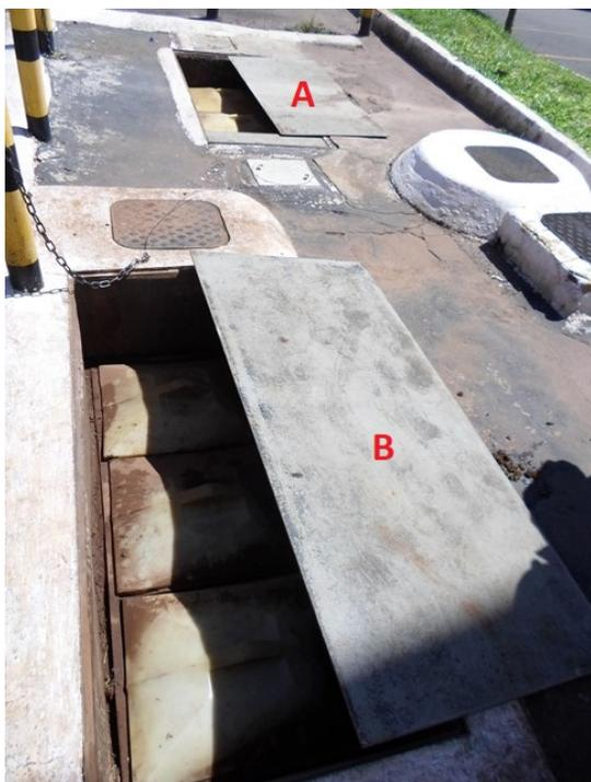
Foto 19. Sistemas separadores de água e óleo; sistema "A" da área de abastecimento e sistema "B" da área de lavagem e lubrificação.
