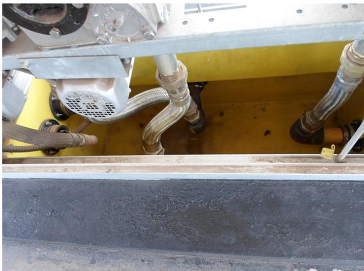
Foto 6. Detalhe da câmara de contenção da unidade abastecedora.
