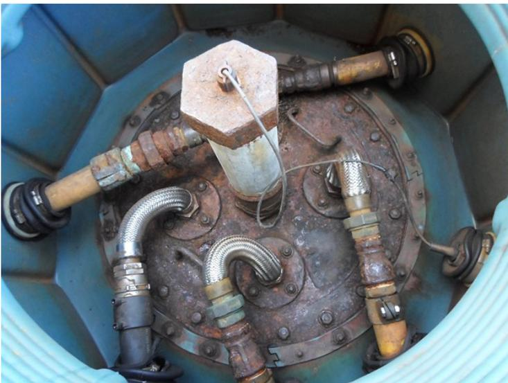
Foto 10. Câmara de contenção do tanque, e tubulações em PEAD.
