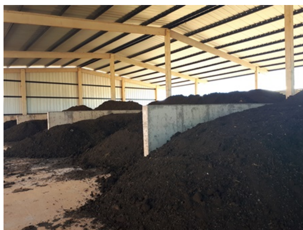
Foto 13 - Galpão de armazenamento de lodo desidratado.
