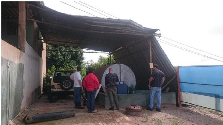
Figura 17: Posicionamento do tanque de combustível aéreo e da bacia de contenção e respiro abaixo da cobertura, de forma inadequada. Fonte: vistoria IBRAM, 15/12/2017.
