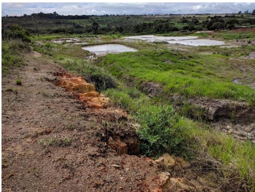
Figura 13: pontos com taludes sem cobertura vegetal e com focos erosivos. Fonte: vistoria IBRAM, 15/12/2017.
