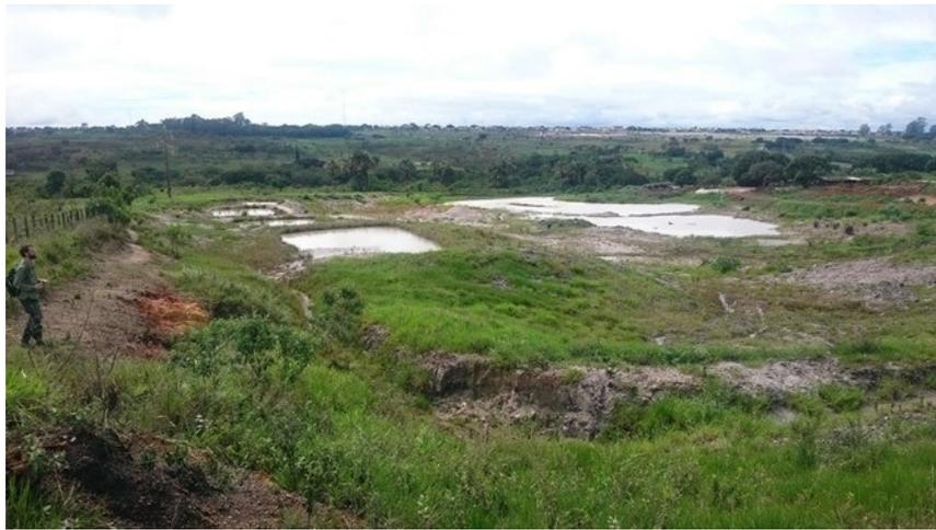
Figura 14: bacias de decantação de argila. Fonte: vistoria IBRAM, 15/12/2017.
