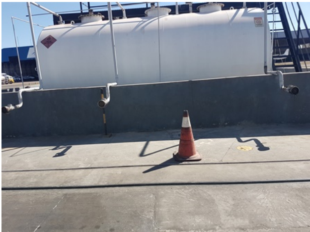
Figura 6 - Tanque aéreo tripartido.
