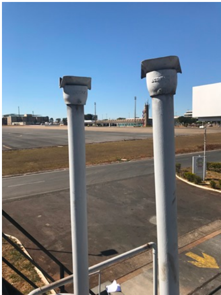
Figura 7 - Respiros dos compartimentos dos tanques.
