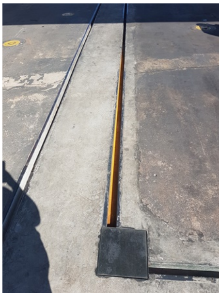
Figura 4 - Adequação dos canaletes.
