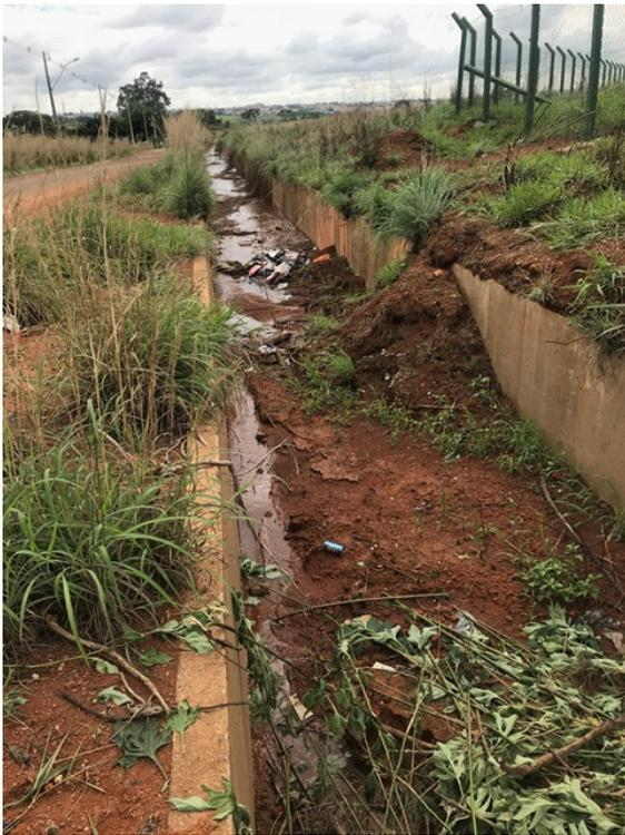
Figura 7 - Sedimentos ao longo do canal;
