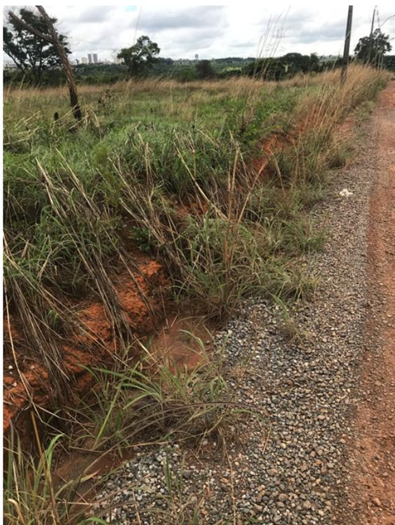
Figura 9 - Formação de processos erosivos ao longo da via;
